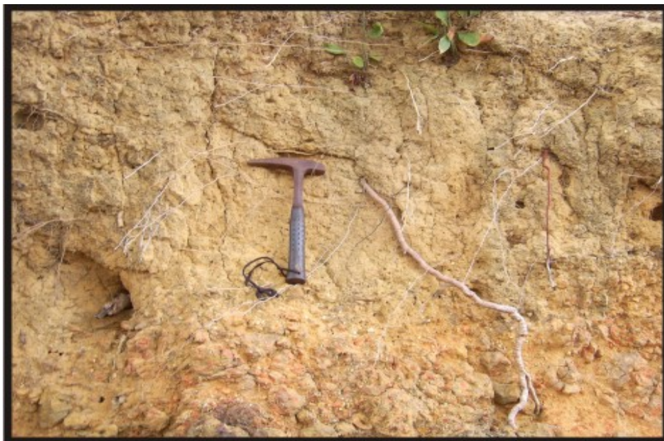
Figura 4.19 – Fraturas em latossolo (Sedimentos Pós-Barreiras). Notar, na Foto A, a penetração das raízes facilitada pela fratura. Praia Grande - Baía do Sol - ilha de Mosqueiro.
