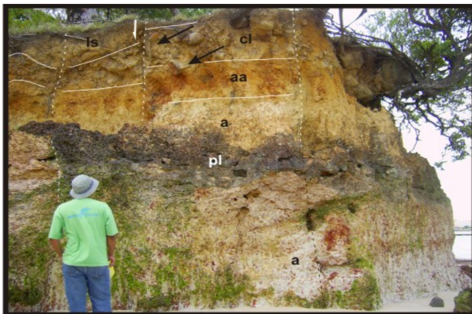
Figura 4.40 – Fraturas e falha transcorrente (tracejado), de direção de 310^{\circ} Az, com componente normal, em perfil laterítico imaturo imposto sobre a Formação Barreiras. Notar o deslocamento da “linha de pedra - cl” (seta preta) dobrada e de blocos facetados de concreção laterítica (seta preta). Praia do Murubira - ilha de Mosqueiro. ls - latossolo, cl- concreção laterítica, aa- arenito argiloso, pl- pseudolaterito, a - argilito.
