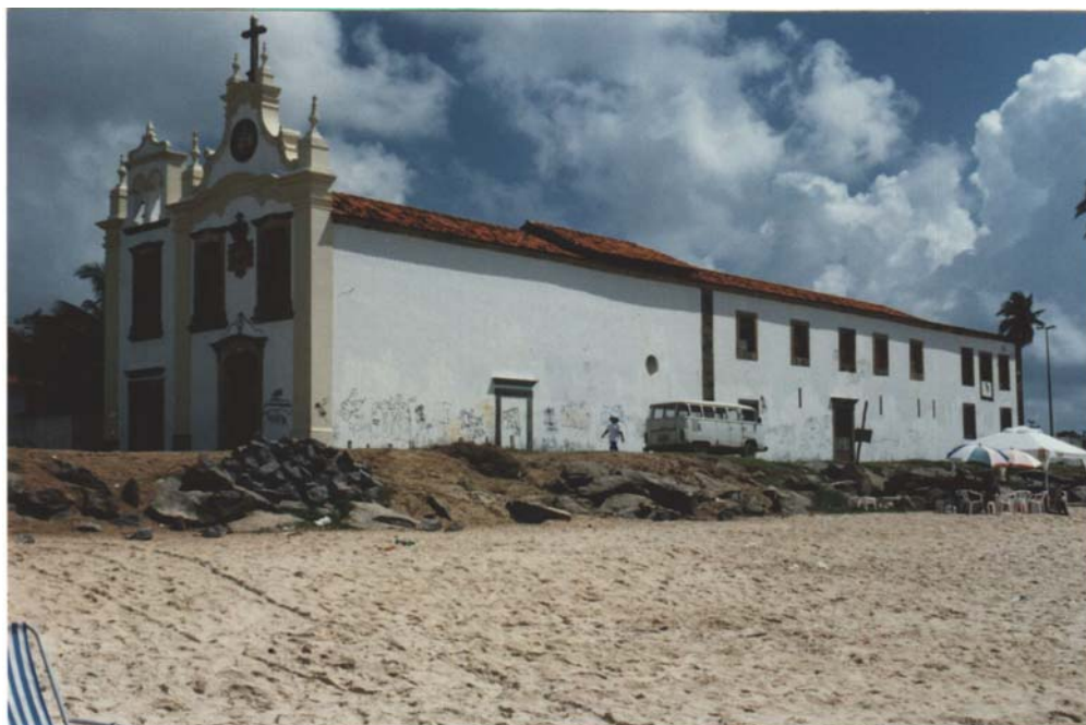
Foto 3 – Setor de pós-praia, à frente da Igreja de N. Sra. da Piedade, ocupado por enrocamento (final da Célula 2).
