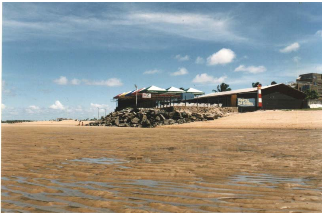
Foto 24 – Detalhe da foto anterior, onde se vê o avanço da construção sobre o setor praiial e o enrocamento instalado para sua proteção.
