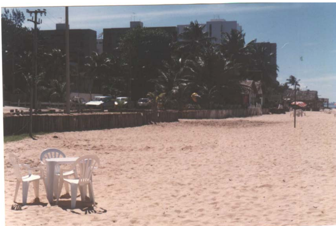
Foto 16 – Muro de troncos de coqueiros na pós-praia, respeitando um recuo em relação à escarpa de berma, permitindo uma estabilidade no ambiente praias (perfil P5 – praia das Candeias).
