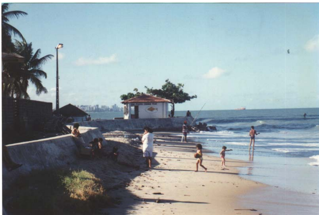
Foto 7 – Exemplo de uma construção de concreto ocupando indiscriminadamente todo o setor de pós-praia e parte do estirâncio, junto ao balneário do SESC, no limite entre as Células 4 e 5.
