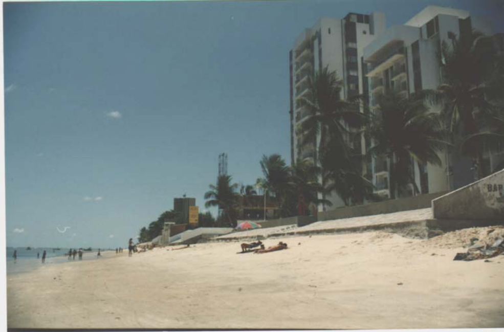
Foto 14 – Vista parcial da Célula 6 (praia das Candeias), mostrando a pós-praia ocupada por edifícios com seus muros e rampas de contenção.
