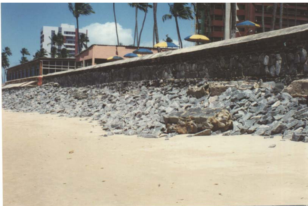
Foto 18 – Detalhe do enrocamento à frente da construção da foto anterior, que avança sobre o estirâncio superior.
