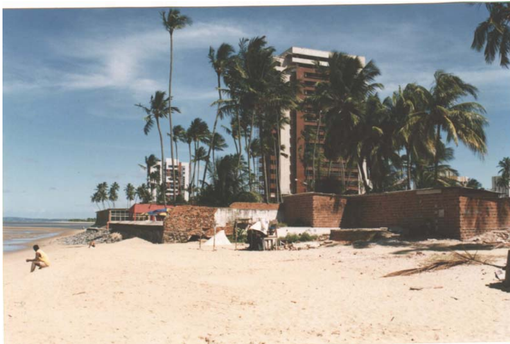
Foto 17 – Posicionamento inadequado de uma construção, ocupando a pós-praia e parte do estirâncio superior (restaurante Candelária - praia das Candeias).
