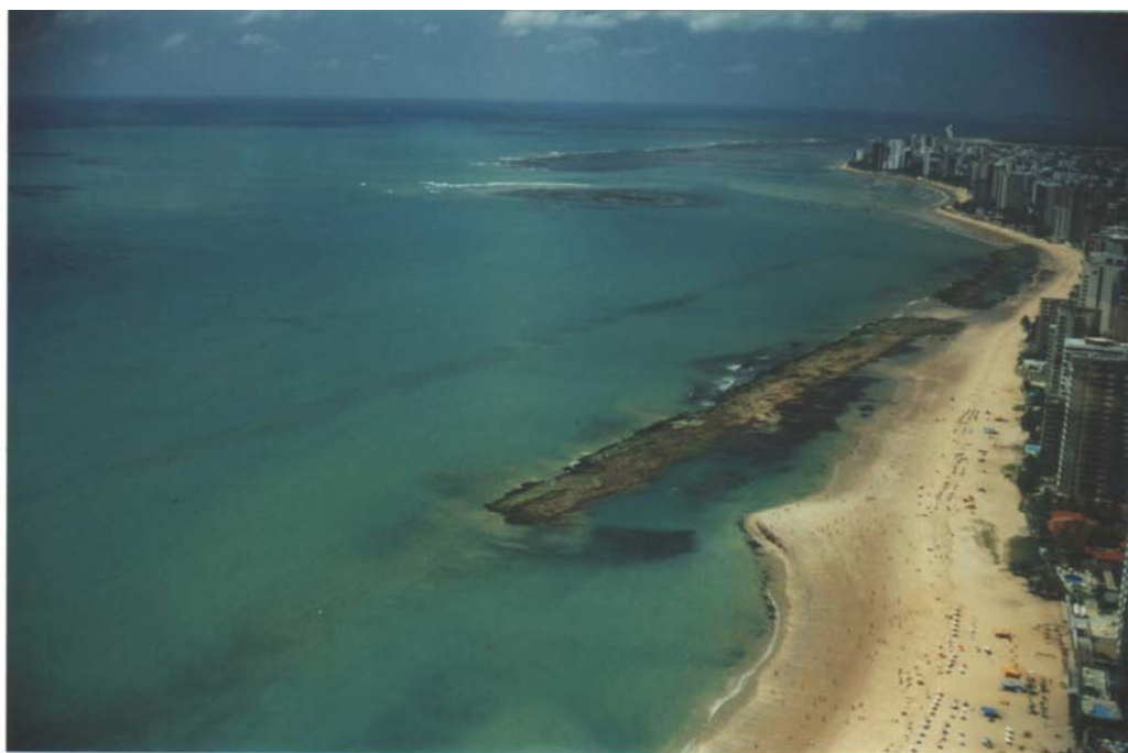
Foto 4 – Descontinuidade da primeira linha de recifes, ao longo da Célula 3, provocando um embaiamento na linha de costa (em primeiro plano).
