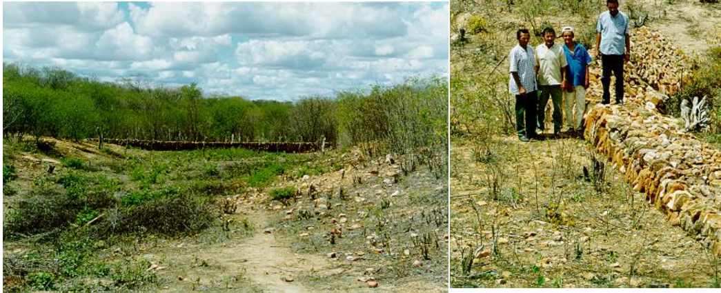
Figura 3.19 – Barragem de assoreamento – Estado de Pernambuco.
