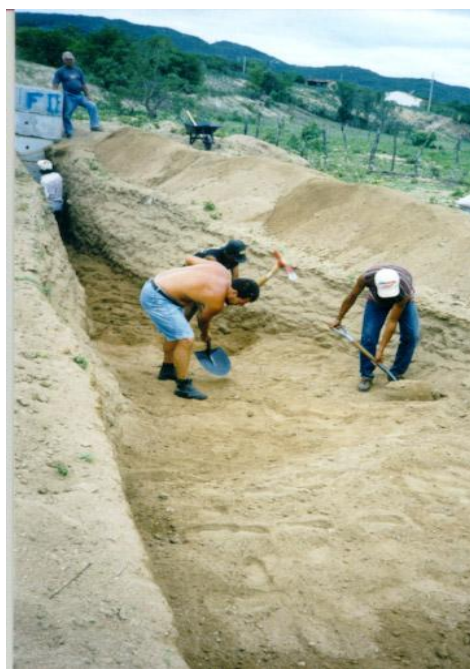
Figura 6.22 – Escavação do dreno da barragem FI ( Mutuca - PE).
