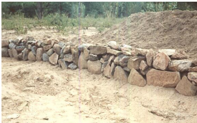
Figura 6.20 - Enrocamento de pedras na barragem SJ (Mutuca-PE).
