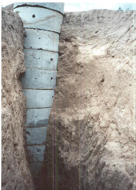
Figura 6.21 – Orifícios executados nos anéis de concreto do poço a montante da barragem FI (Mutuca- PE).
