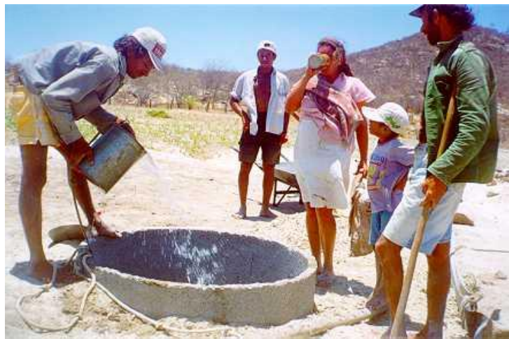
Figura 3.13 - Água utilizada para o abastecimento humano captada em depósito aluvional com barragem subterrânea.
