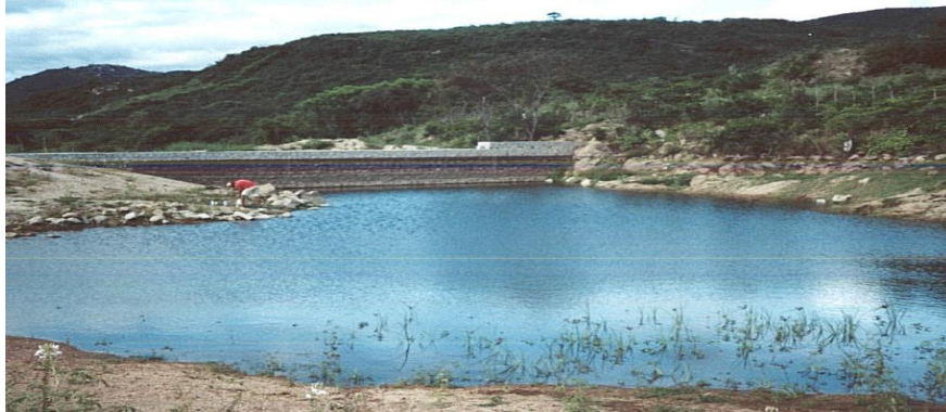
Figura 6.17 - Barragem superficial construída a montante de FI .
