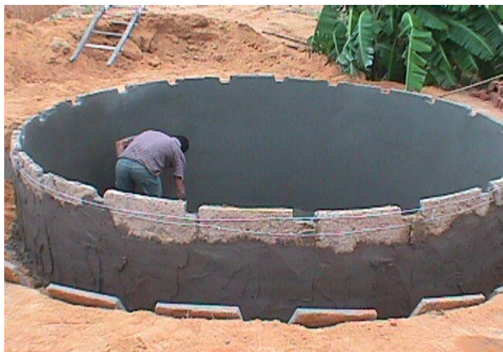
Figura 3.3 - Cisternas de placas de cimento (armação e reboco das paredes).
