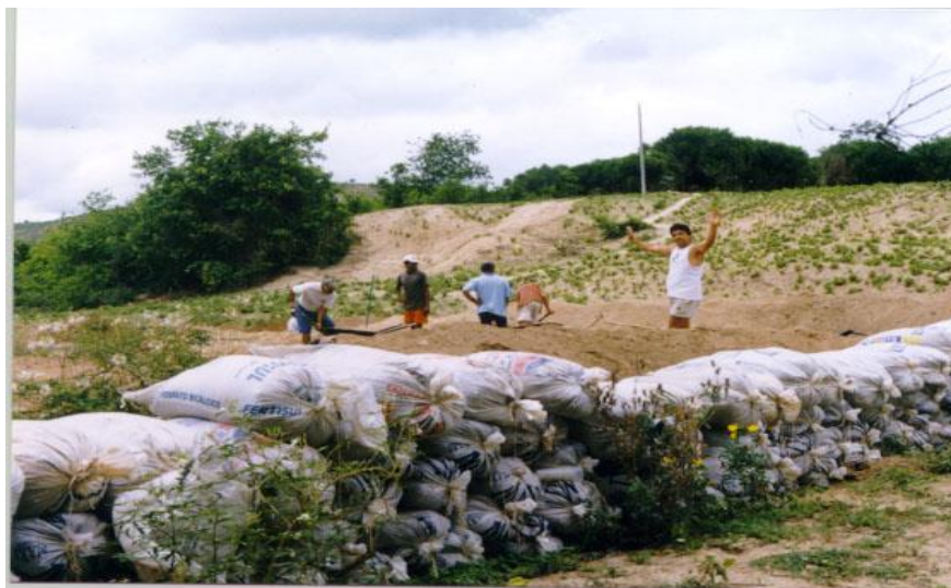
Figura 6.19 – Enrocamento com sacos de areia na barragem MIV (Mutuca- PE).
