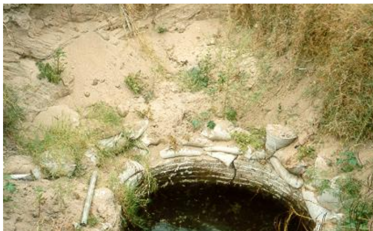
Figura 5.3 – Escavação a montante da barragem CI (Mutuca-PE).
