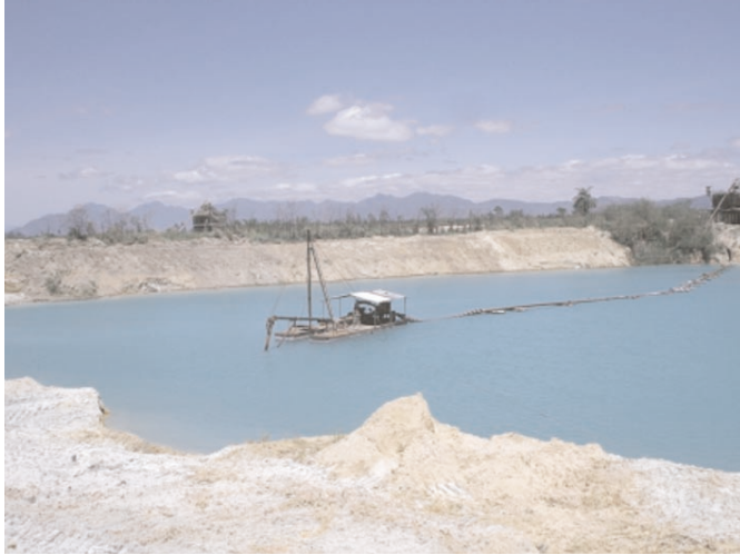
Figura 4 – Draga em funcionamento em uma das cavas.
