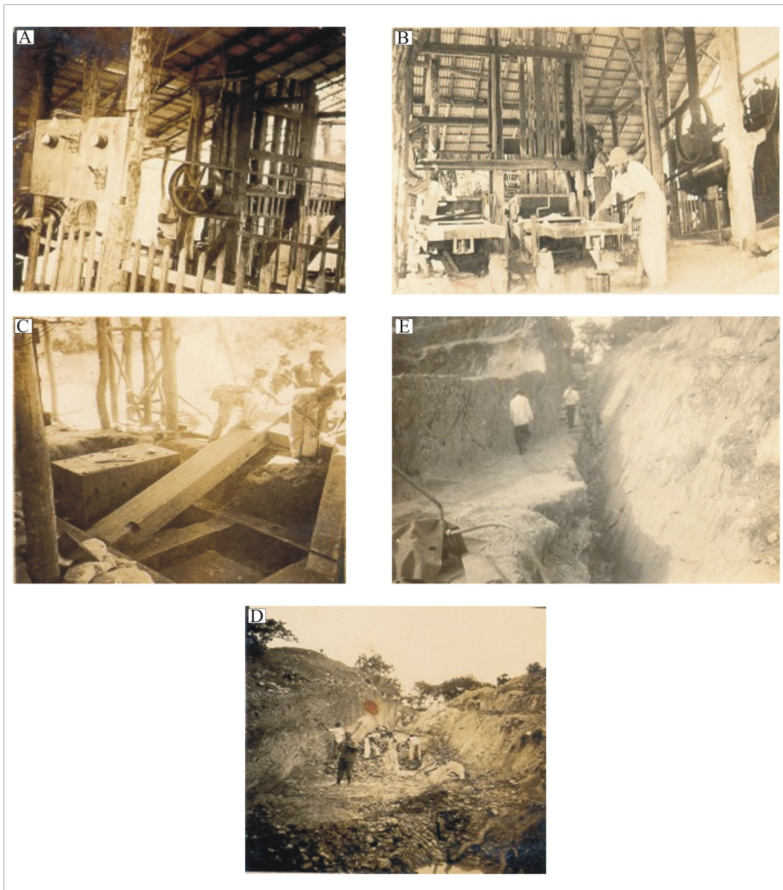
Figura 1.2 – Fotos ilustrativas do início dos trabalhos na região da mina de Aurumina. Destaques para: A e B) Mostram vistas internas do que era a casa de máquinas da usina primitiva. C) Aspectos da montagem do pilão californiano utilizado. D) Estado dos trabalhos em um dos principais veios, até fevereiro de 1951. E) Evolução dos trabalhos no mesmo veio que D, até fevereiro de 1953. Fonte: Parada, 1953.
