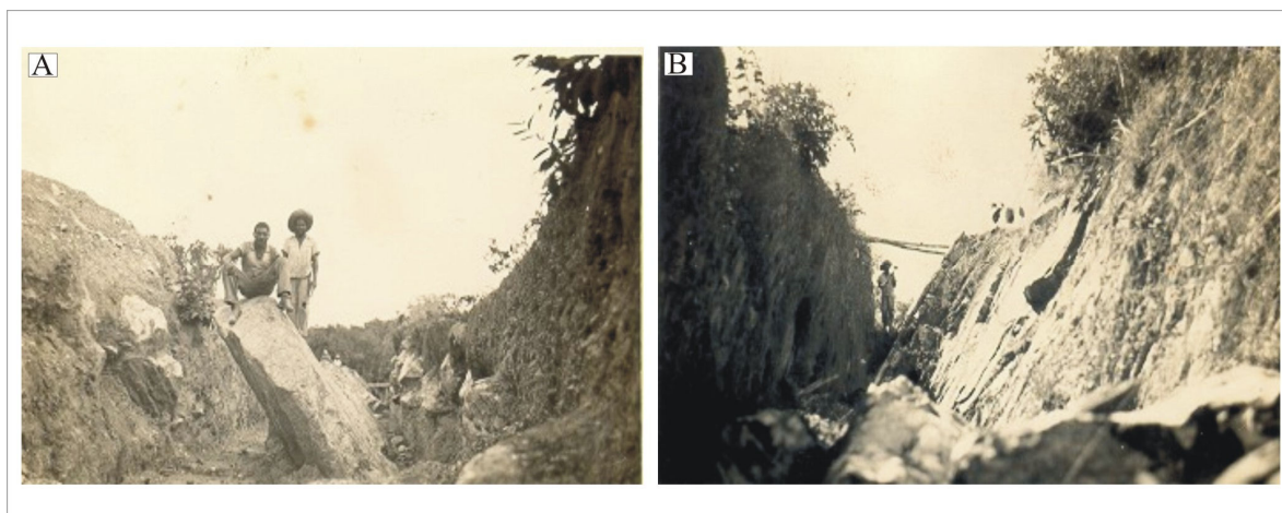
Figura 4.4 – Fotos do início dos trabalhos de exploração no VL 1.3, da Mina de Aurumina, na década de 1950. A) Início do VL 1.3 em seu extremo NE, destaque para o aumento gradual na largura do veio e a manutenção da direção do mesmo. B) Local onde o VL 1.3 atinge sua maior espessura, de até 1,2 metro. Fonte: Parada, 1953.
