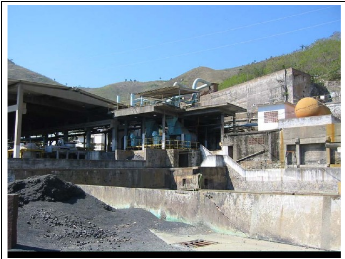
Figura 08 - Foto de parte das instalações da empresa Plumbum com empilhamento de escória.
