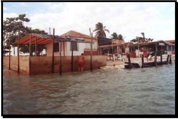
Figura 5.13 - Praia da Redinha sofrendo um intenso processo de erosão devido ao deslocamento do canal principal de navegação em direção a sua margem, provavelmente causado pela intensa acreção do Banco do 17° G.A.C, em consequência da construção e localização do espigão (Fotos: Frazão, nov. 2001)
