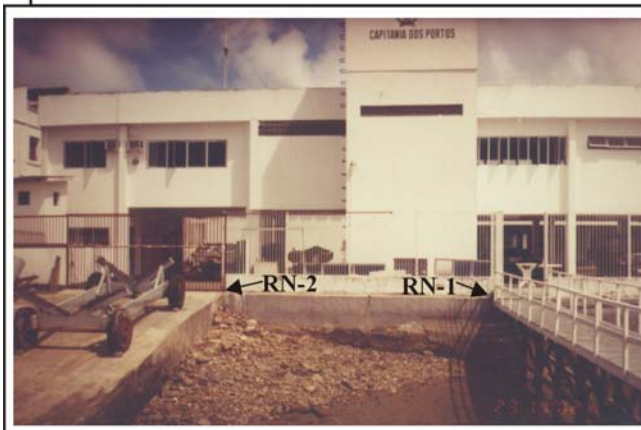
Figura 2.10 - Diagrama de nivelamento da estação maregráfica da Capitania dos Portos do Rio Grande do Norte (CPRN).
