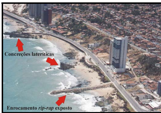
Figura 6.4 - Segmento 03 apresentando substrato com enrocamentos rip-rap expostos e plataforma exumada recoberta por concreções lateríticas - ISL 6 (Foto: Vital, nov. 2001).
