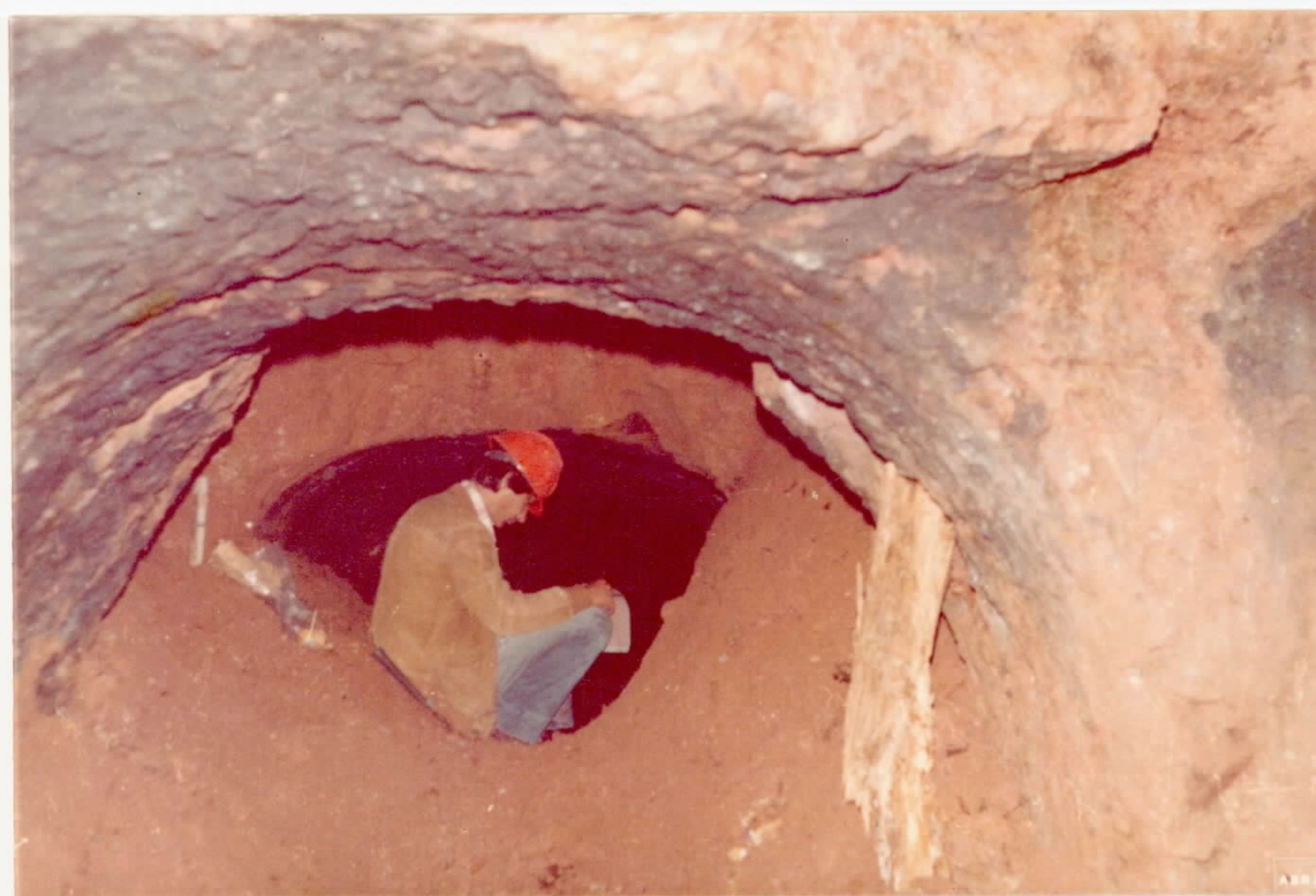
FOTO 4 - Técnico descrevendo o teto da galeria. Nota-se que neste local houve um soterra mento parcial da mesma.
