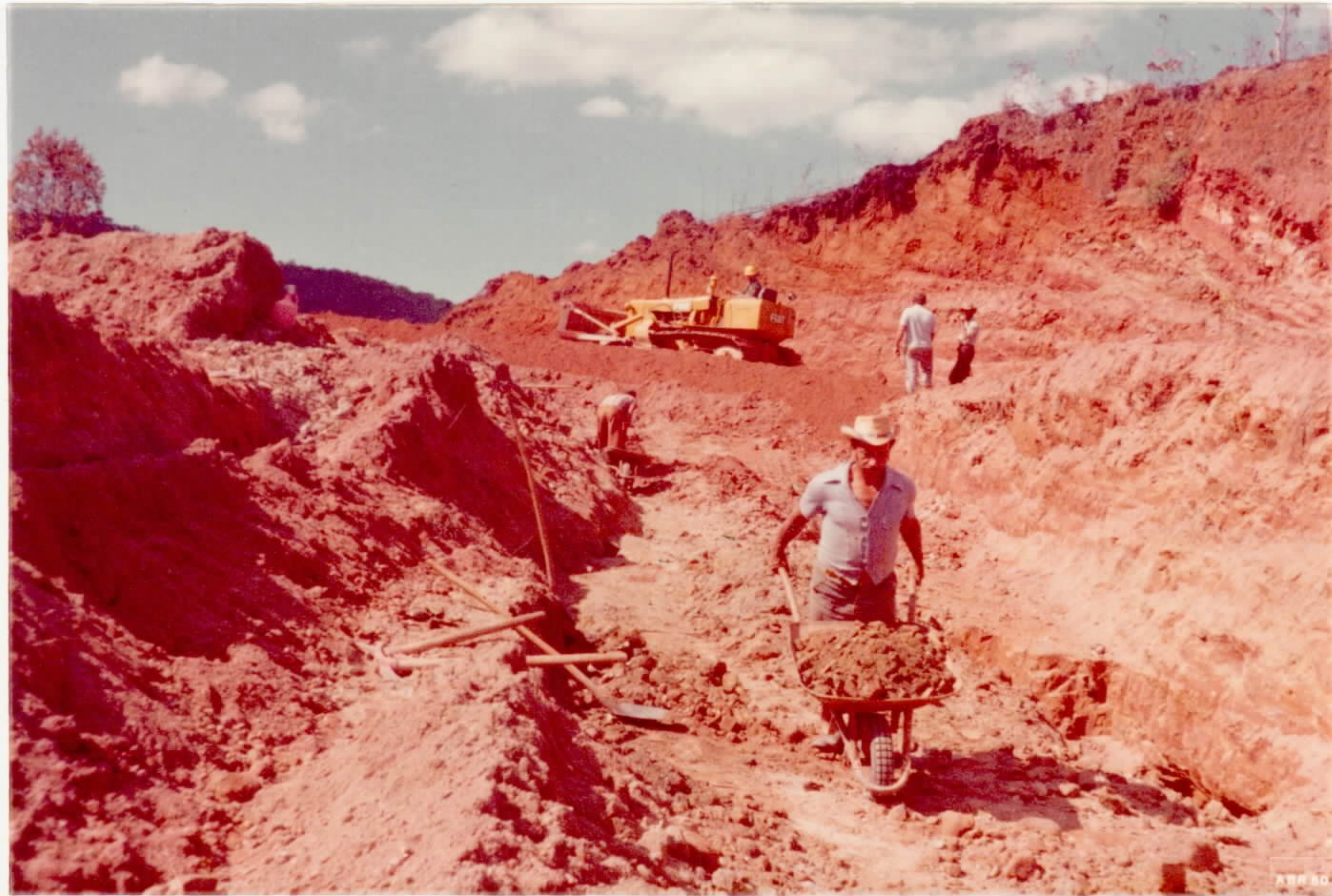
FOTO 5 - Trincheira direcional para lavra seletiva .
