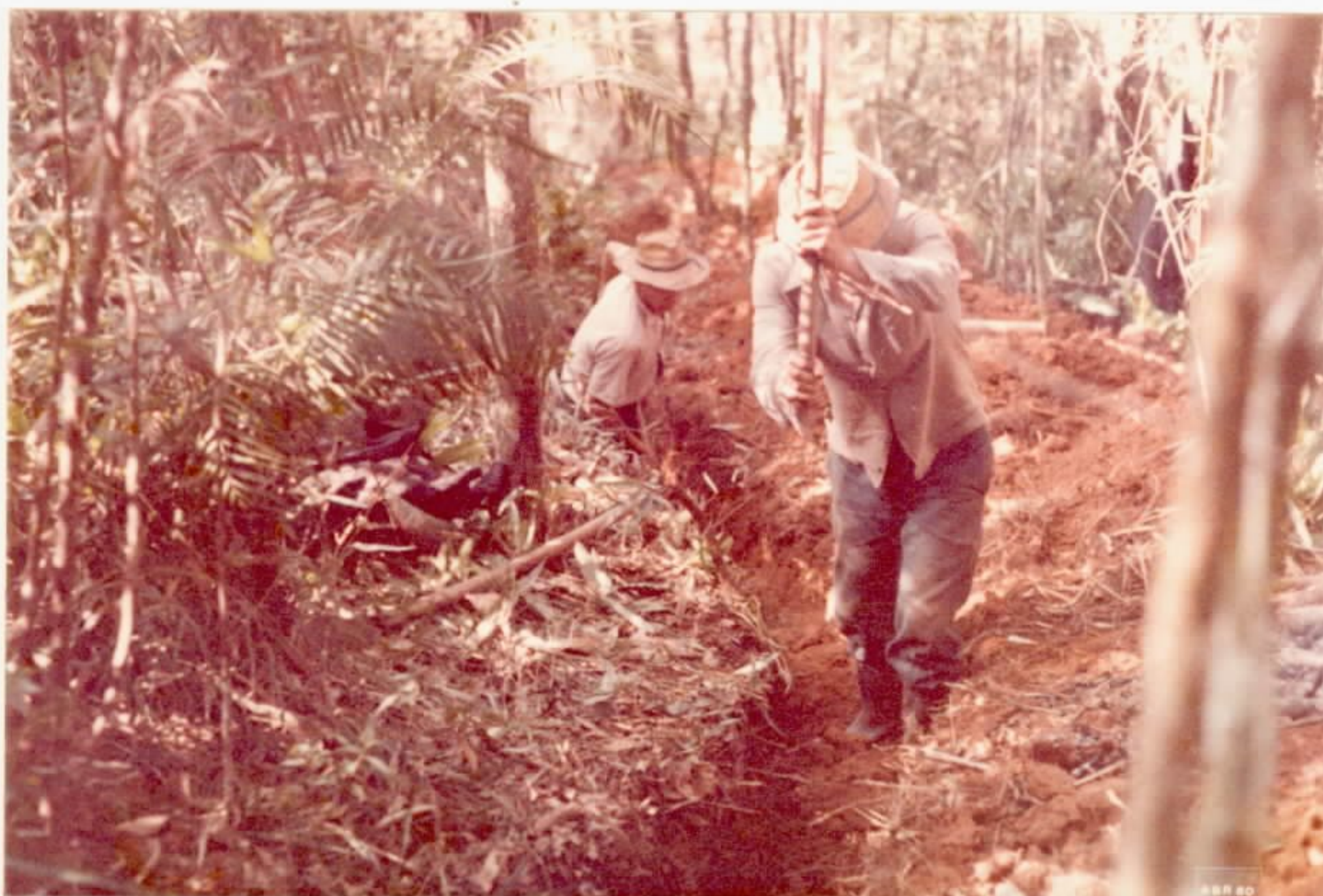
FOTO 16 - Trincheira de prospecção aberta manual- mente. Área da Catinga .
