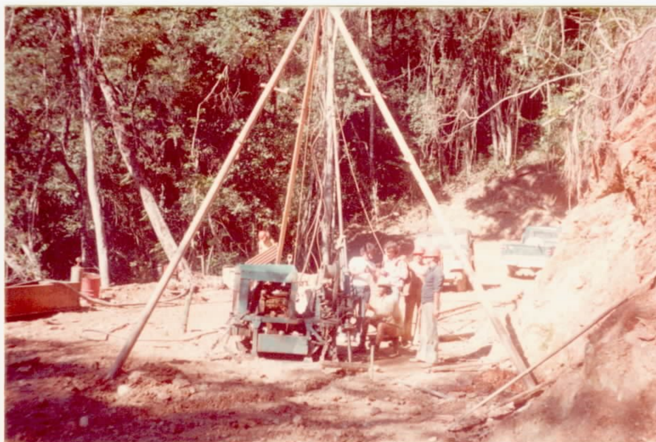
FOTO 22 - Sondagens. Área do Ribeirão do Russo . (RF-01-SC) .
