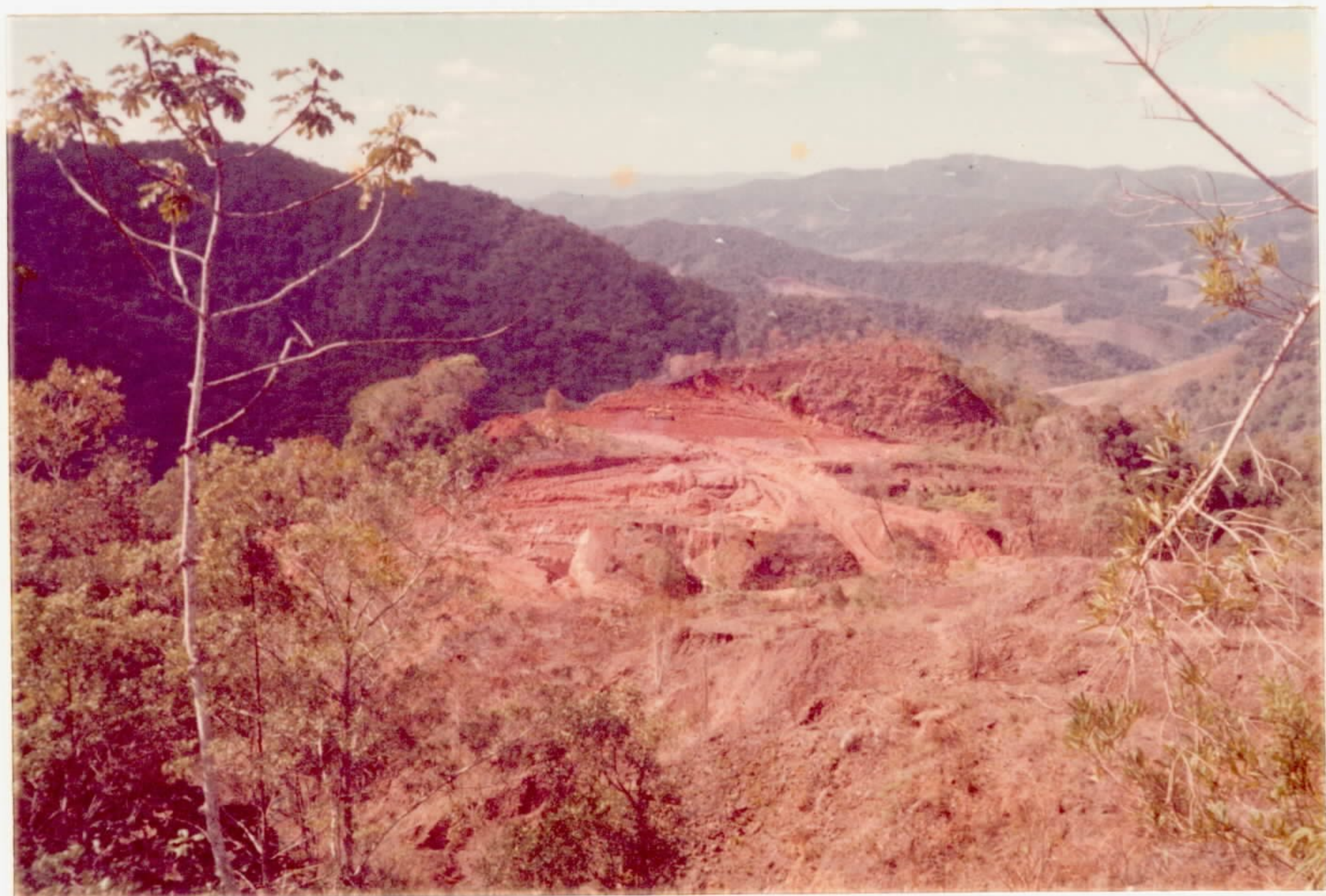
FOTO 2 - Preparação de uma frente de lavra na porção centro leste da mina (próximo ao perfil HH') .
