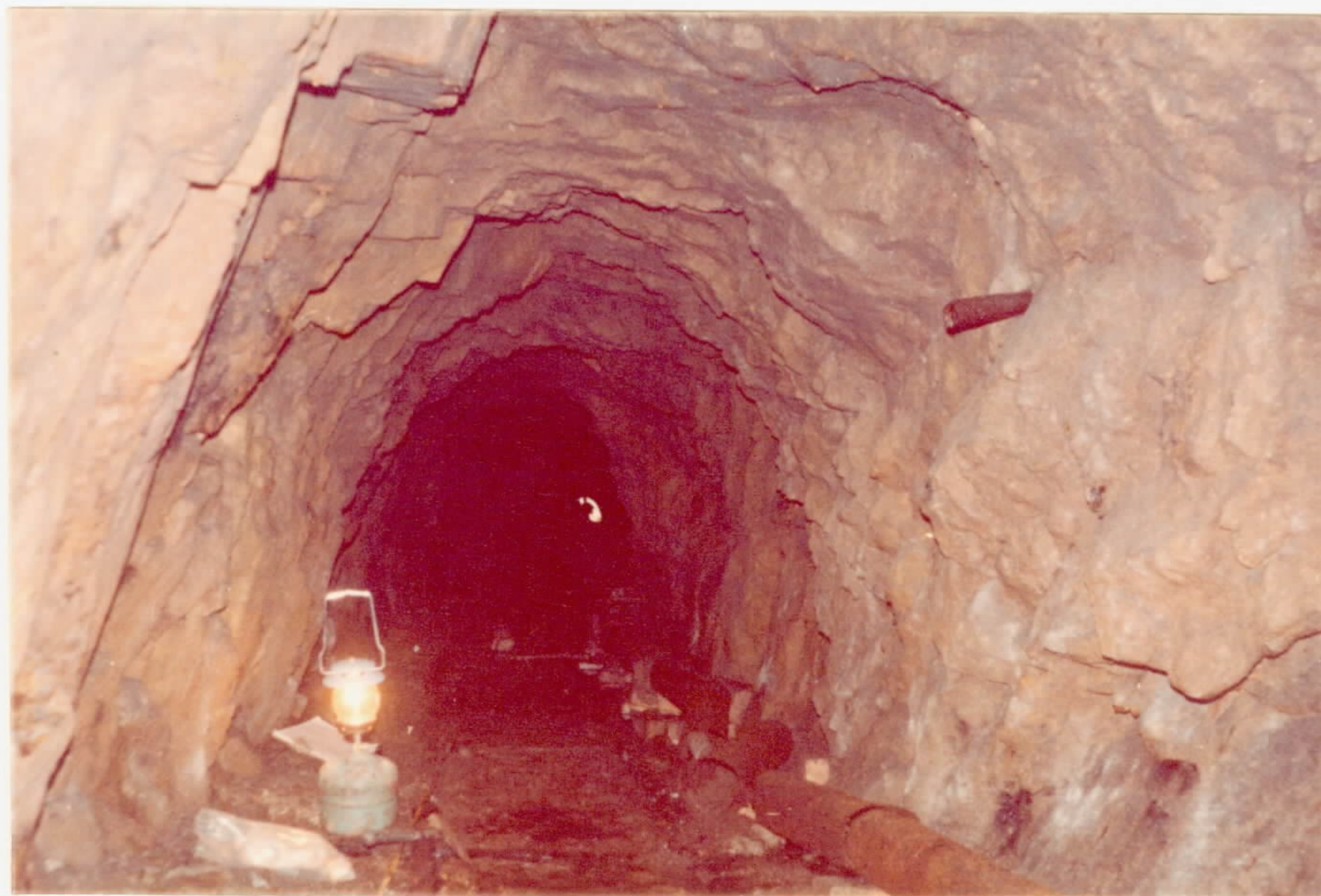
FOTO 6 - Galeria 26 (túnel). Embaixo à direita, antigos tubos para ventilação. Também pode-se observar antigos trilhos para utilização de vagonetas. Ao fundo a boca da galeria.
