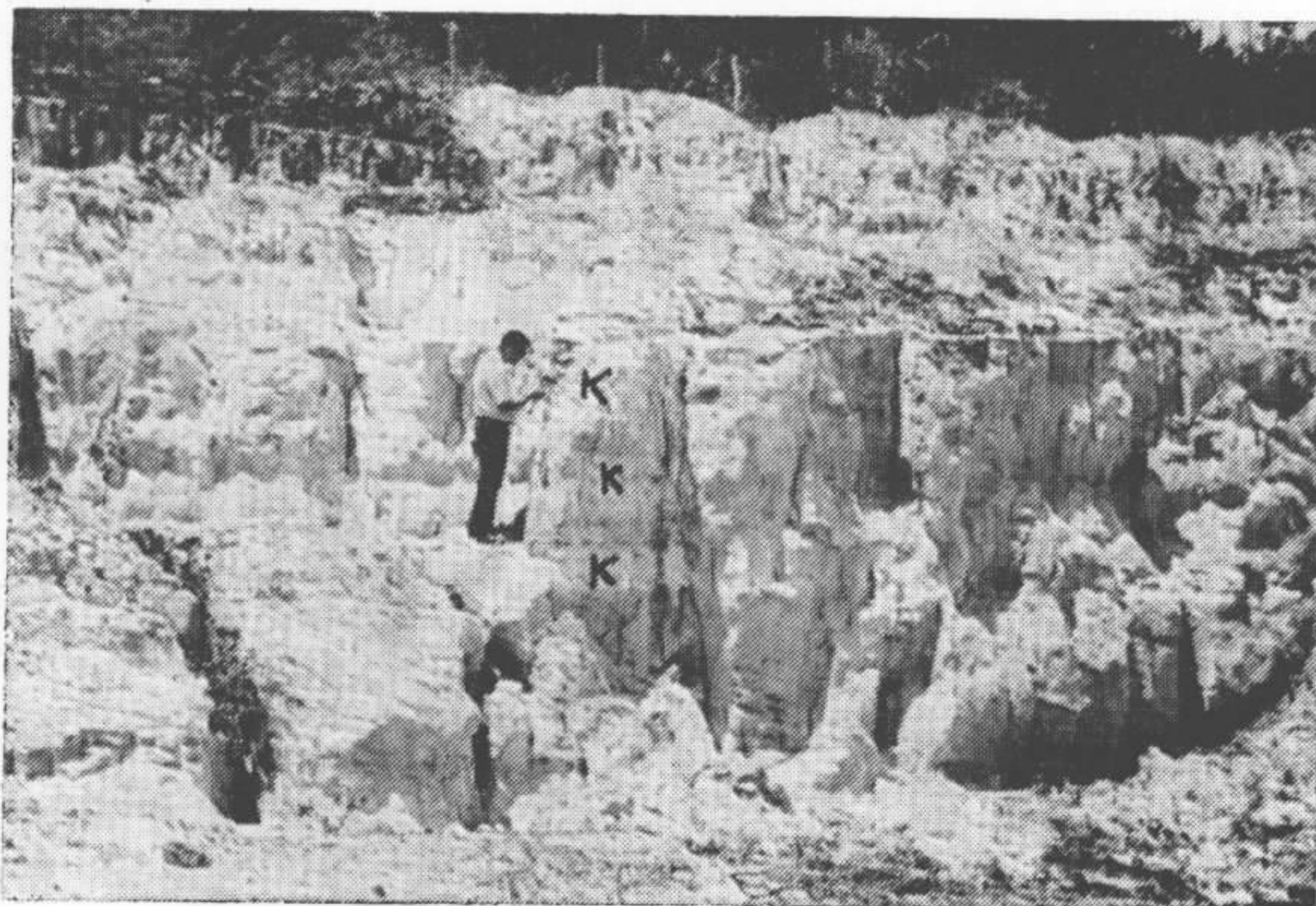
Foto 16 — Sedimentos areno-argilosos do Grupo Barreiras. Pode-se observar uma estratificação incipiente onde se denotam níveis caulínicos (K). Margem da rodovia BR-101, ao sul de São José do Mipibu.
