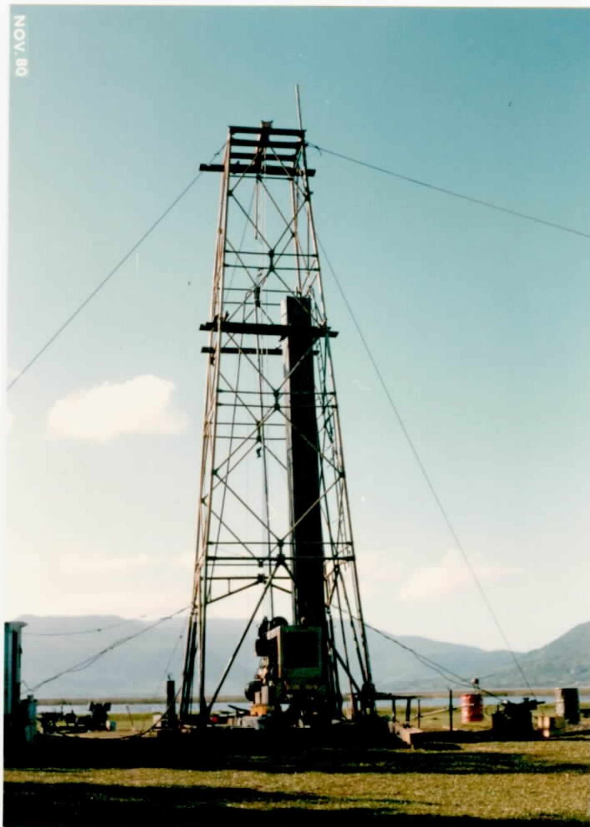
Aspecto do canteiro de sondagem da CPRM, sonda BBS-45, Bloco Banhado Grande, próximo a Lagoa do Peixoto, Santo Antônio da Patrulha, RS.
