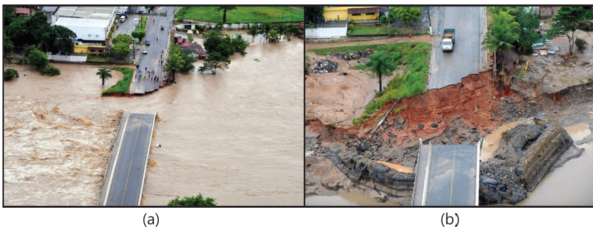
Figura 6 – Viaduto Profa. Lúcia Paiva em Palmares.
