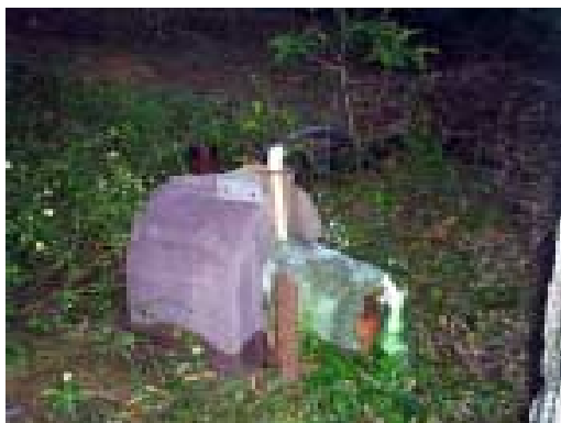
Fig. 35. Poço raso para abastecimento doméstico, com baixa vazão de água.
