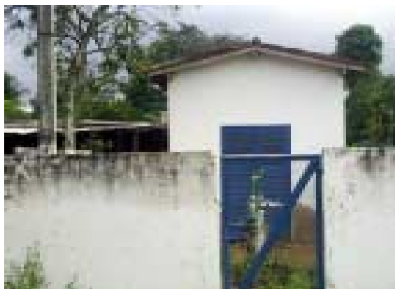
Fig. 27. Poço administrado pela empresa Águas do Paraíba no Distrito de Dores de Macabu, município de Campos, RJ.
