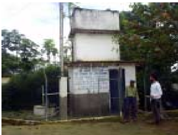
Fig. 25. Abastecimento de água tratada por poço perfurado pela Prefeitura de Carapebus, no Distrito de Conde de Araruama.
