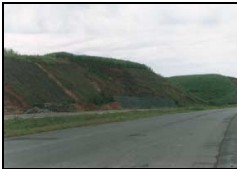
Foto 12 - Obra de contenção de encosta ao longo da duplicação da BR-101 Sul, município do Cabo de Santo Agostinho
