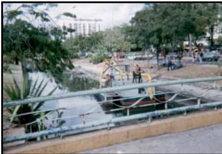
Foto 4 - Dragagem no canal Derby-Tacaruna - Recife.
