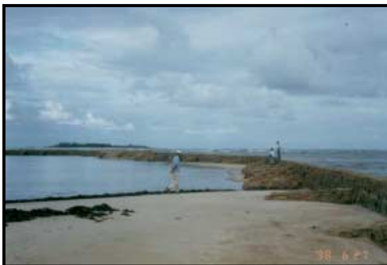
Foto 7 - Construção de espigões de pedra na desembocadura do Rio Sirinhaém.
