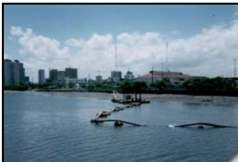
Foto 3 - Dragagem no rio Capibaribe – Recife.
