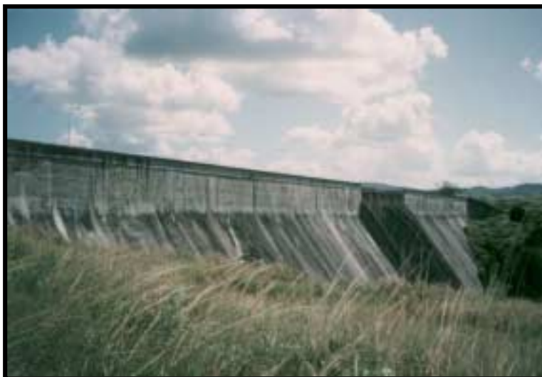
Foto 14 - Barragem de Tapacurá construída para amortecer As cheias do rio Capibaribe
