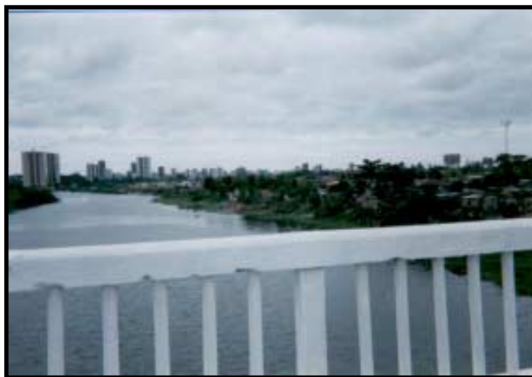
Foto 1 - Construção de favelas na margem baixa do rio Capibaribe - Recife (Vista sobre a ponte na BR-101).
