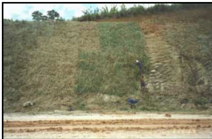
Foto 14 - Plantio de gramíneas para contenção de deslizamento. (Duplicação da rodovia BR-101).
