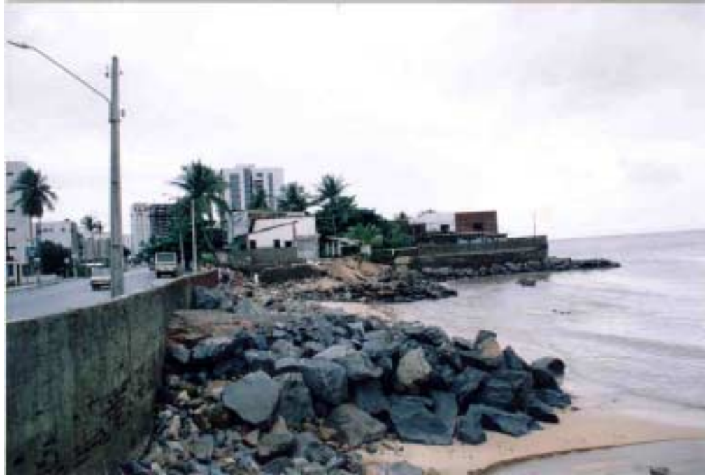
Erosão Marinha (Bairro Candeias)
