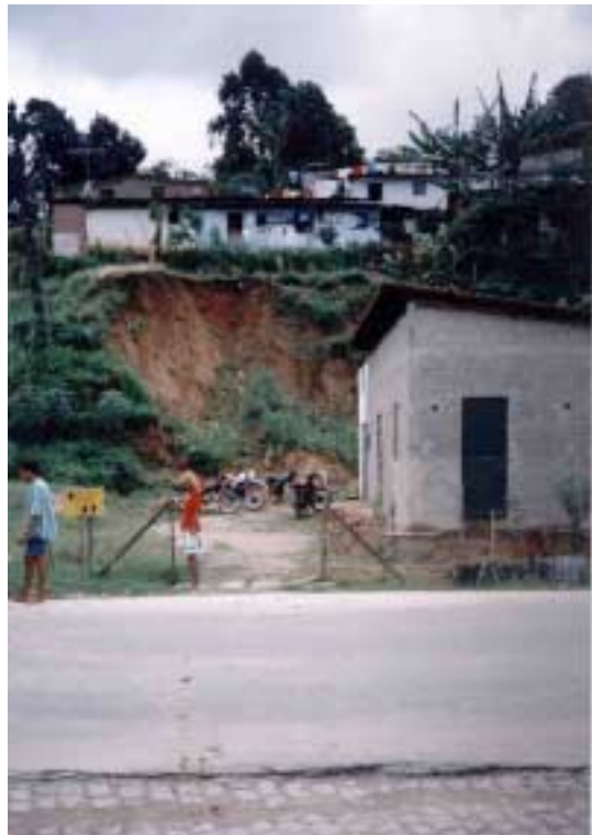
Deslizamento (Estrada da Luz)
