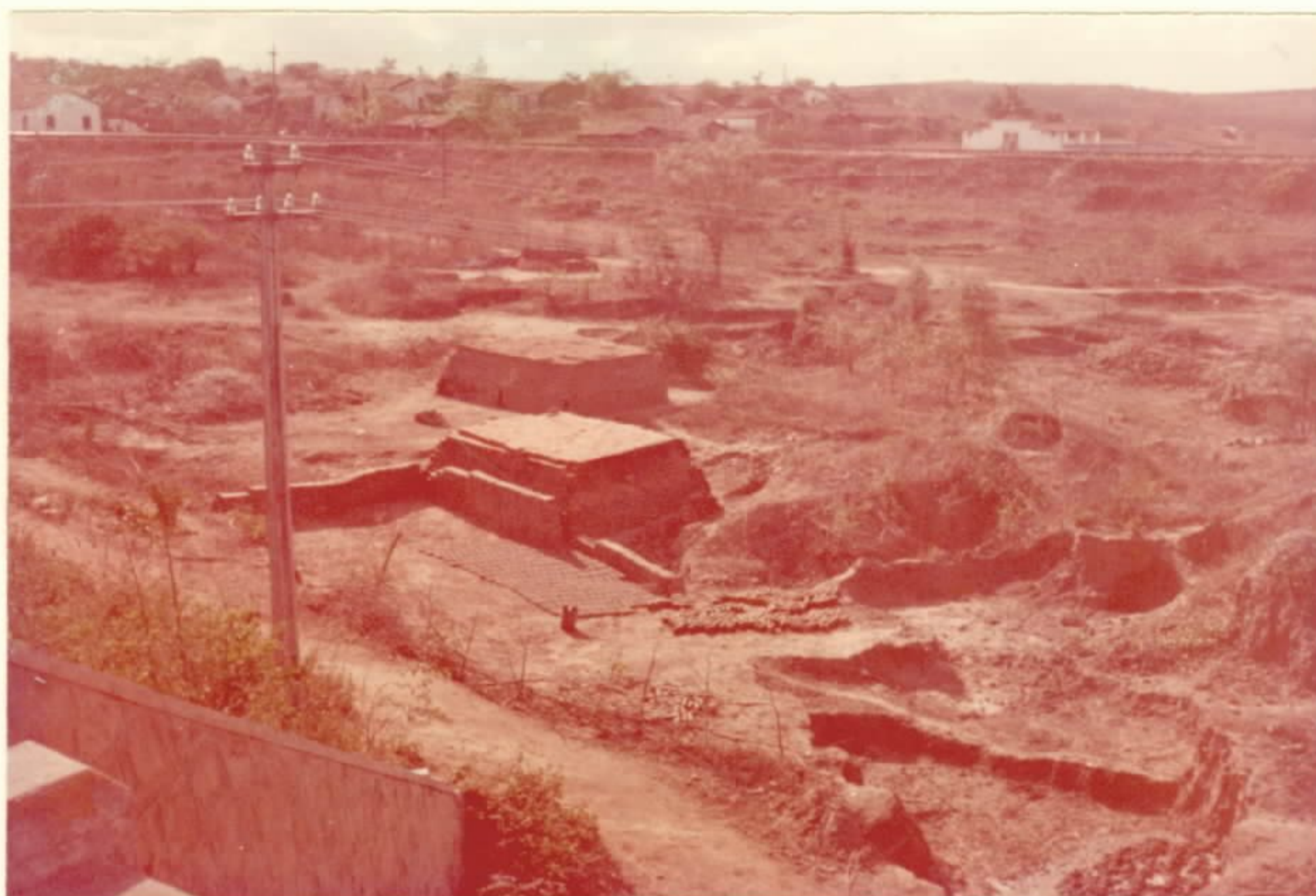
Foto 40 - Depósito de argilas do rio Curú; dois fornos formados pelo empilhamento dos próprios tijolos a serem queimados. Olaria Valdir Lima, mun. São Luiz do Curú, Ceará.
