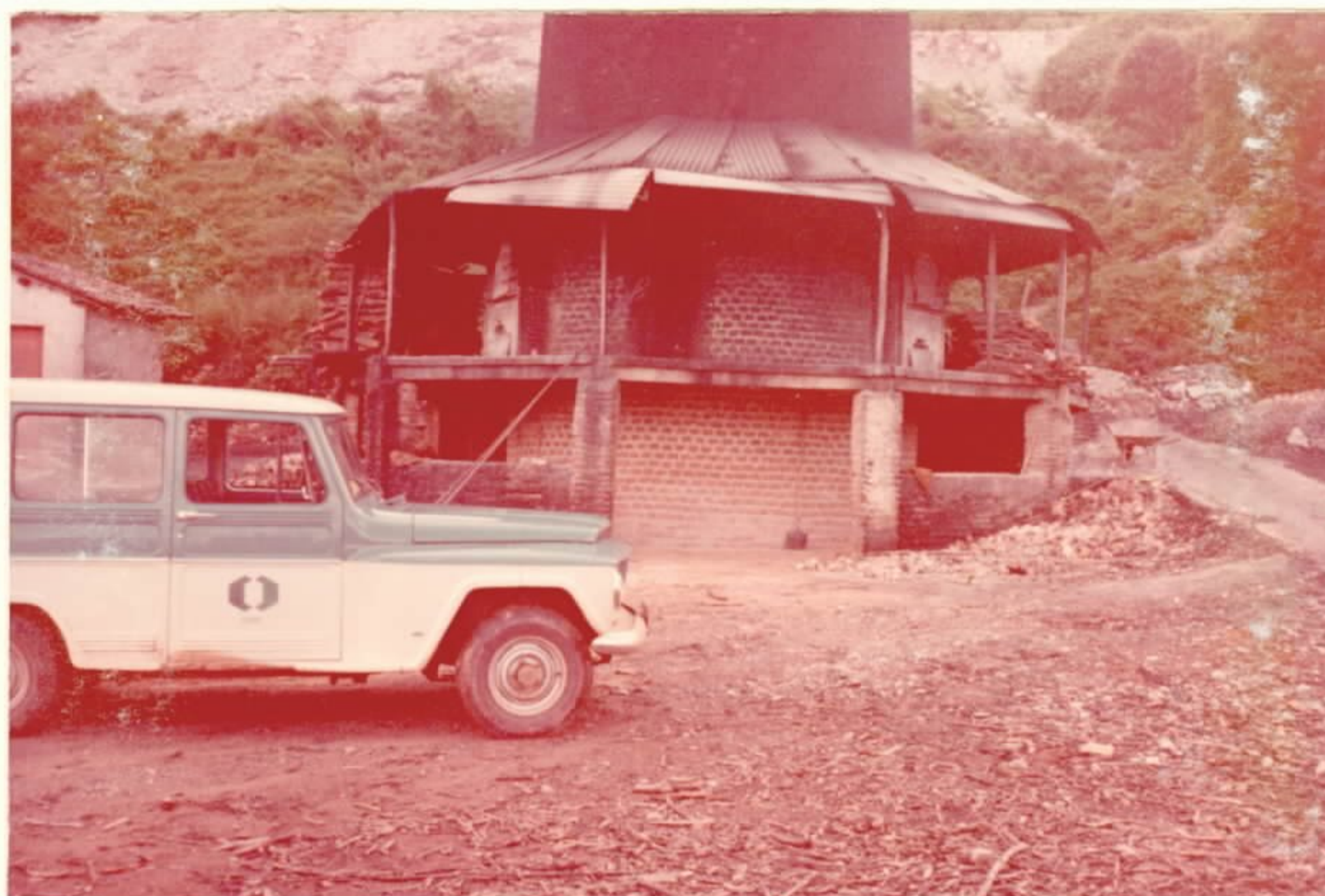
Foto 12 - Forno vertical contínuo, alimentado a lenha, para calcinação de magnesita. Mina Sítio Torto, Jucás, Ceará.
