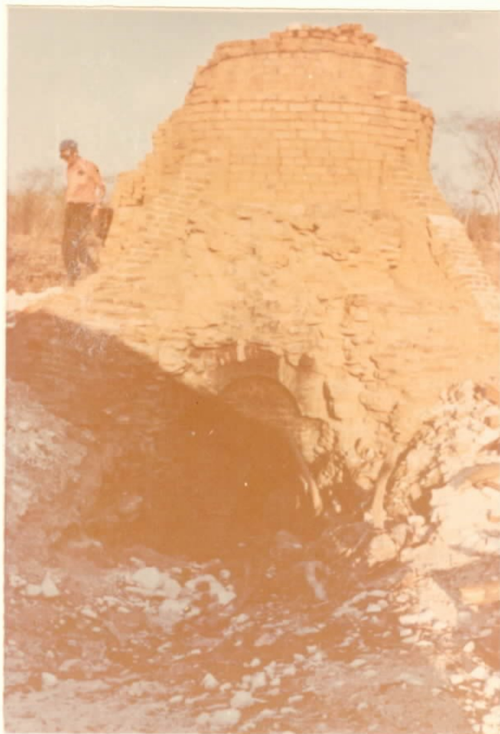
Foto 34 - Aspecto de um forno rudimentar para o fabrico de cal. Fazenda Estrela, mun. de Canin dé .
