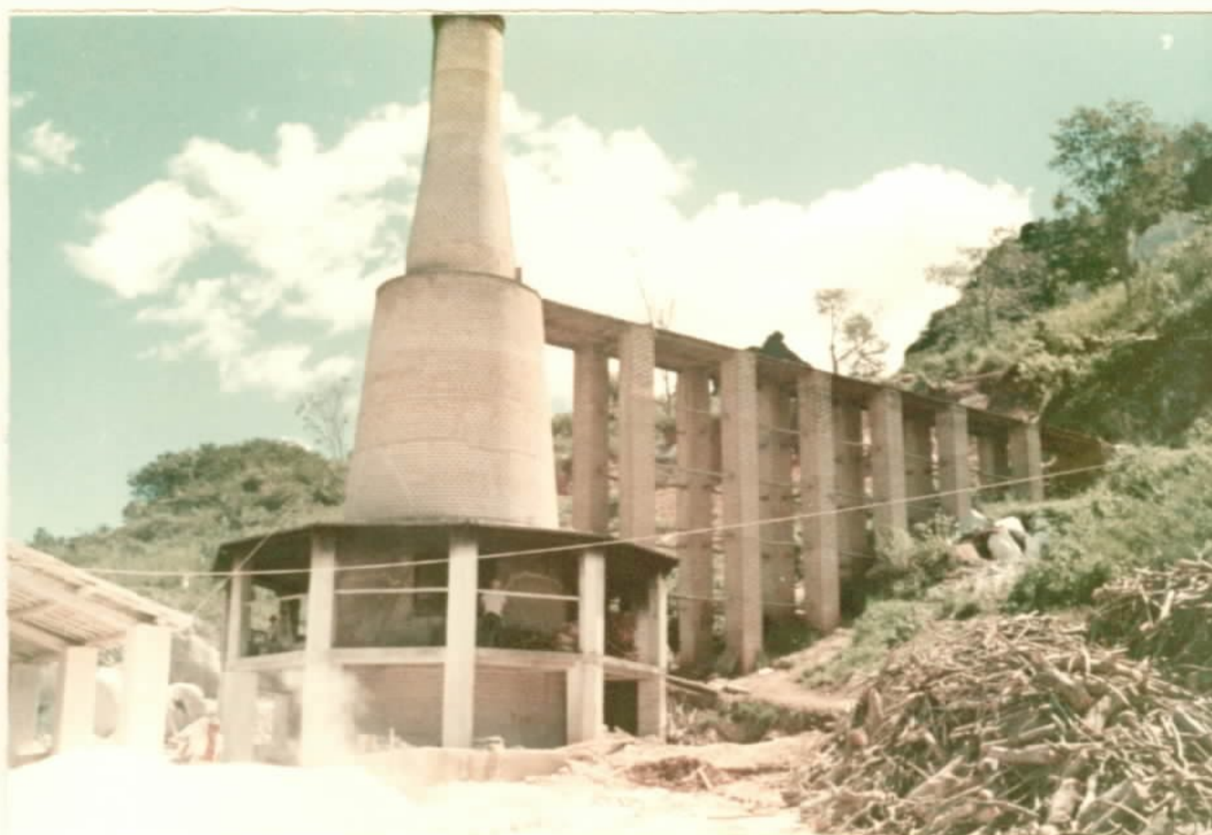
Foto 30 - Forno contínuo de calcinação do calcário dolomítico. Cantagalo, mun. Redenção, Ceará.
