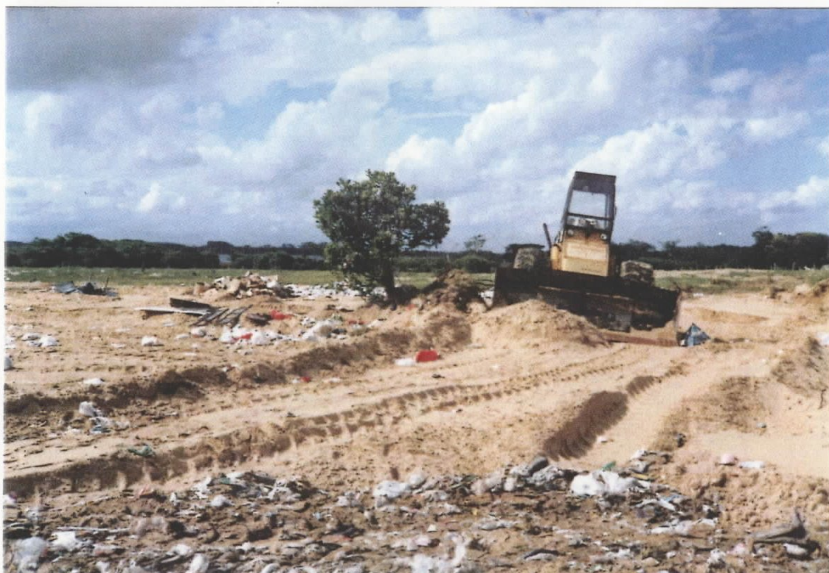
Foto 2 - Em geral os depósitos de lixo não dispõem de equipamento e, no caso da foto acima (Cidreira), é inadequado, uma vez que serve apenas para espalhamento e não realiza compactação.
