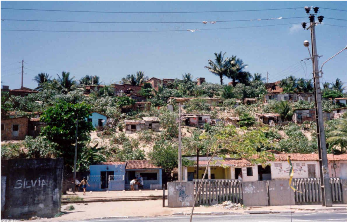
Foto 9: Ocupação de dunas por favelas, provocando a instabilidade das encostas. Morro do Castelo Encantado, bairro do Mucuripe – Fortaleza.
