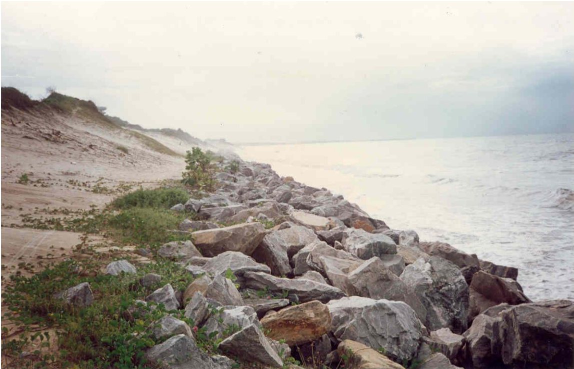
Foto 7: Estrutura de proteção contra o avanço do mar (erosão costeira). Praia de Iparana, município de Caucaia.
