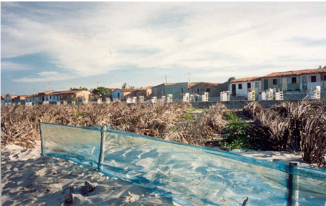
Foto 4: Telas de nylon e palhas de coqueiro utilizadas para deter o avanço das areias em direção às casas. Bairro de Serviluz, Fortaleza.
