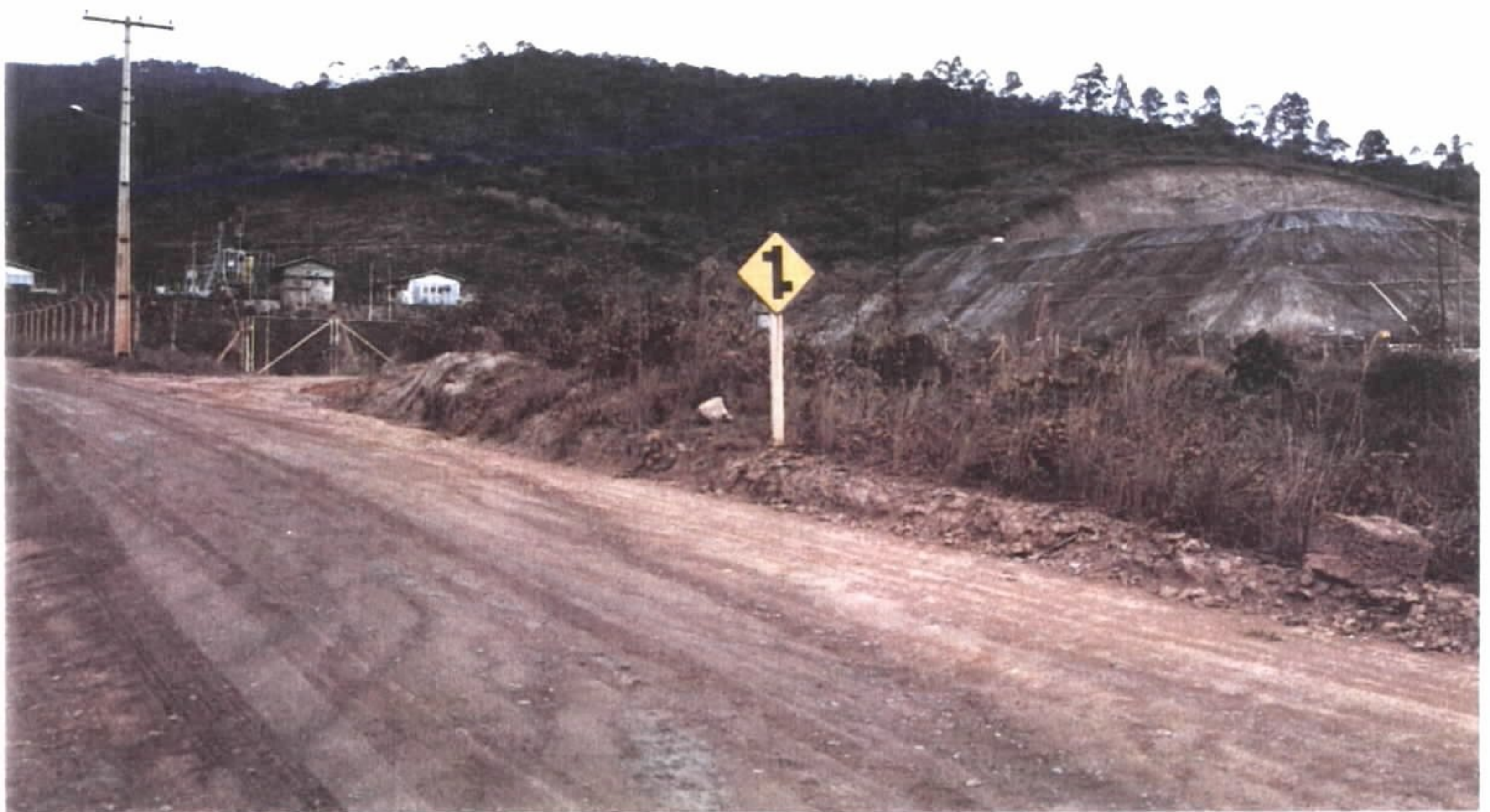
FOTO 2 : VISTA DA USINA DE TRATAMENTO E PILHAS DE LIXIVIAÇÃO
