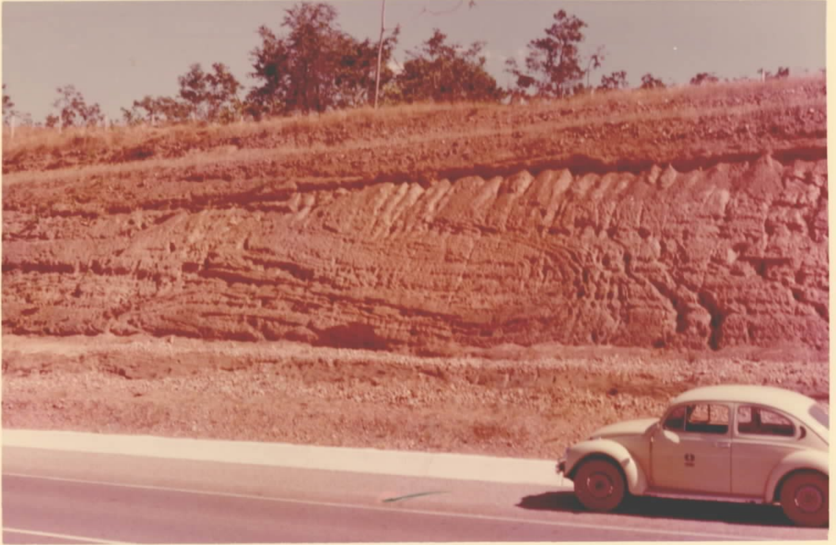
FOTO 11 – Corte da rodovia BR-153, pouco a norte de Campinorte, onde se observam os granada-clorita xistos da Unidade III (p \mathcal{C} III) dobrados em isoclinais bastante apertadas e deitadas, com planos mergulhando suavemente para a direita.
