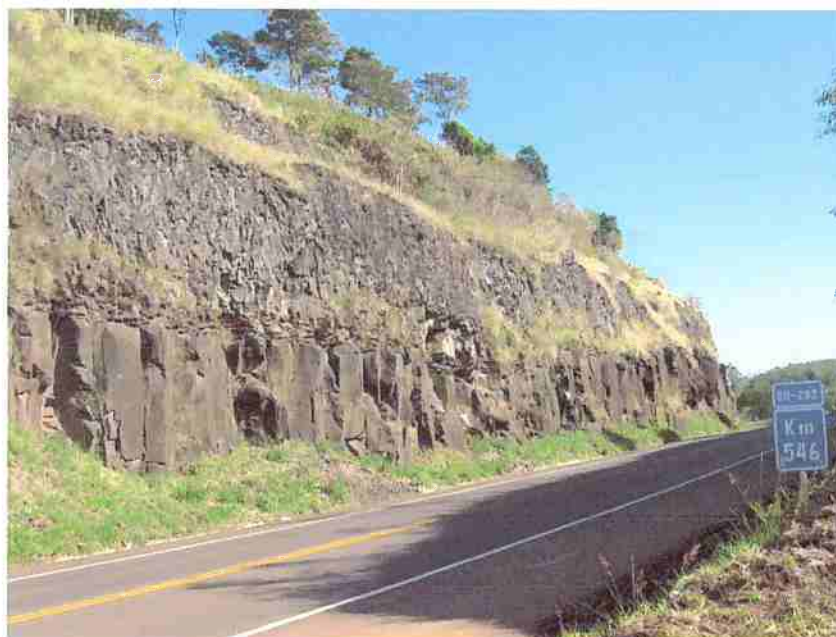
VC-54 – Corte na BR-282, Km 546. Limite entre dois derrames vulcânicos, provavelmente do fácies Cordilheira Alta. O derrame inferior apresenta disjunção colunar, enquanto que o superior possui fraturamento irregular. Entre os dois há uma zona com forte padrão de fraturamento tabular.
