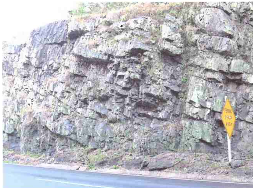
EG-64 – Corte na BR-373, imediações de Segredo. Basalto de granulação muito fina, cor preta com disjunção colunar estreita em leque e disjunções tabulares inclinadas com espaçamento maior. Presença de vesículas milimétricas. Magma tipo Pitanga, fácies Nova Laranjeiras.
