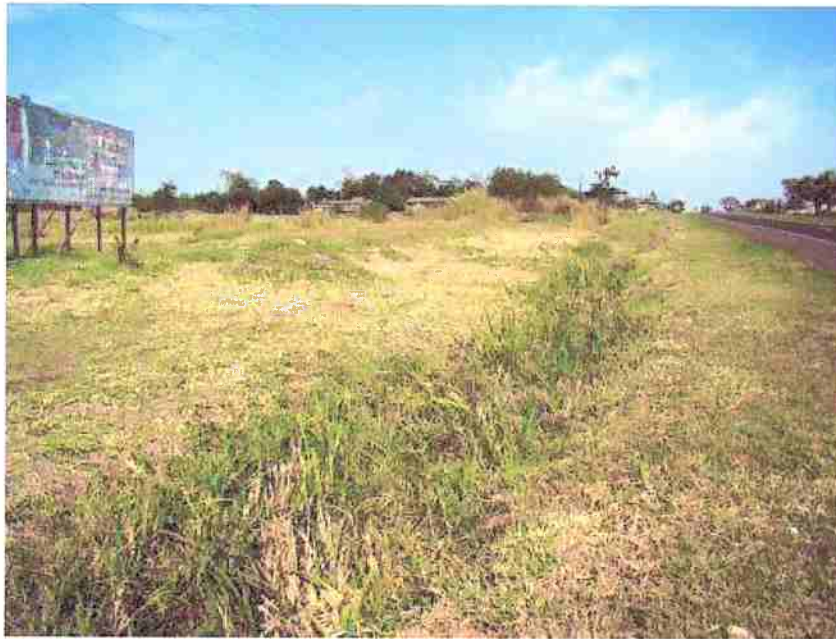
Foto 2.20: Terreno muito plano às margens da rodovia BR277, na zona de expansão de Foz de Iguaçu, onde, devido a problemas de escoamento superficial, valas foram abertas para melhorar a drenabilidade. Uma prática não recomendável, uma vez que estas áreas úmidas têm grande importância ambiental e hídrica e são geotecnicaamente bastante problemáticas. Nas zonas urbanas áreas como estas devem ser transformadas em parques ecológicos.
