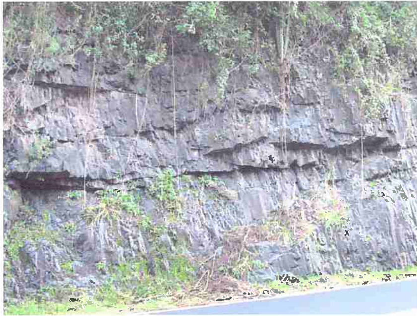
EG-64 – Detalhe da disjunção colunar em leque muito pouco espaçada e do fraturamento tabular com espaçamento bastante grande.
