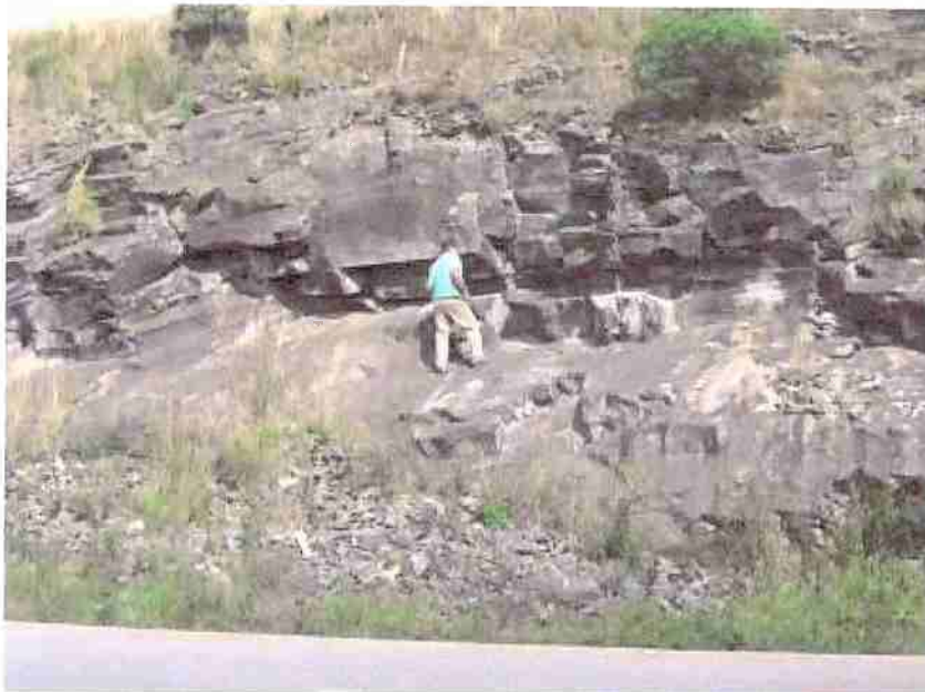
VC-33 – BR-280, Parque Eólico de Palmas. Carneiro. Destaque para o padrão tabular do fraturamento.
