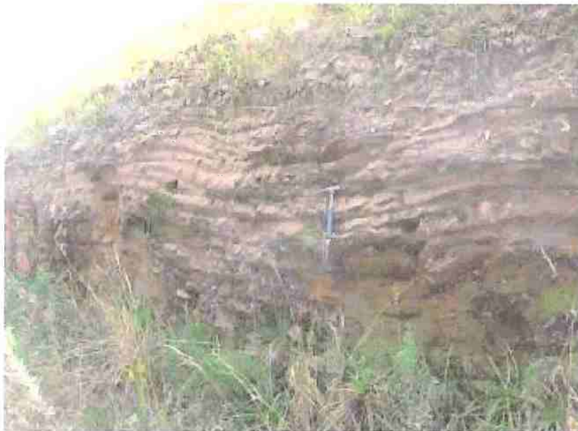
VC-32 – Corte na BR-280, sentido Gen. Carneiro. Basalto cinza castanho, com forte padrão de fraturamento tabular e arqueamentos de fluxo de lava.
