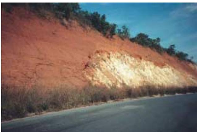
**Foto 15** - Exposição de sedimentos argilosos da subzona 4A, recobrimdo em perfil irregular, solos residuais de migmatitos da zona 1. Talude da rodovia permitral da cidade de Sete Lagoas.
