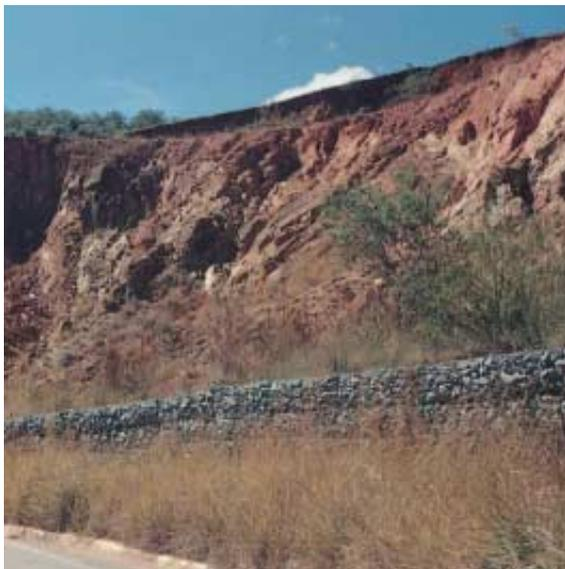
**Foto 17** - Deslizamento em talude construído em solos residuais de metapelitos da subzona 3b. Gabiões de contenção construídos para proteção da rodovia de acesso a Serra de Santa Helena. Município de Sete Lagoas.
