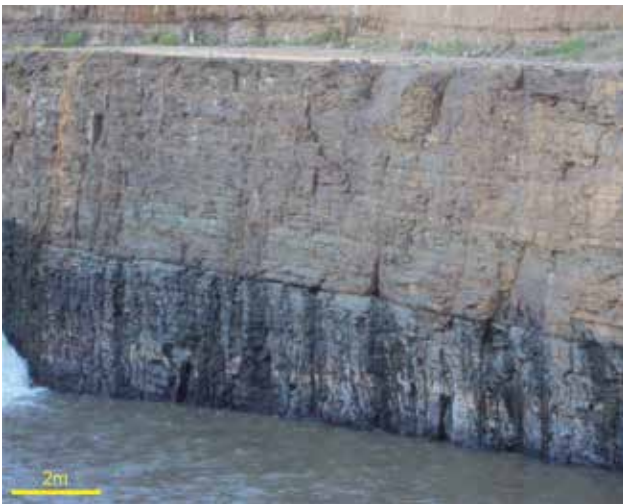
Figura 7.4 - Paredão de siltito no canal da UHE Retiro Baixo (MK 1422 – 523210 / 7912842).
