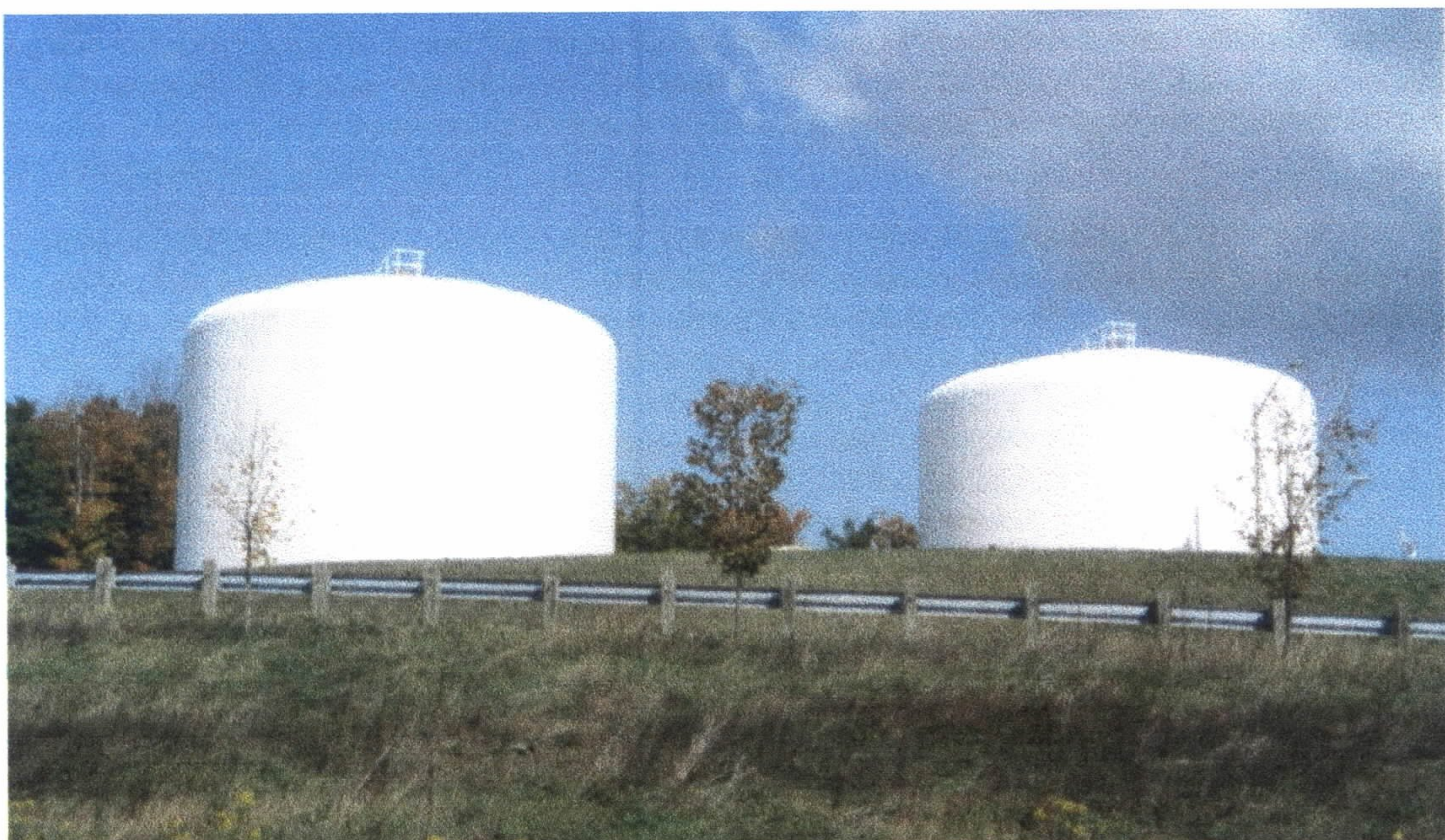
Armazenamento de água – Manheim
