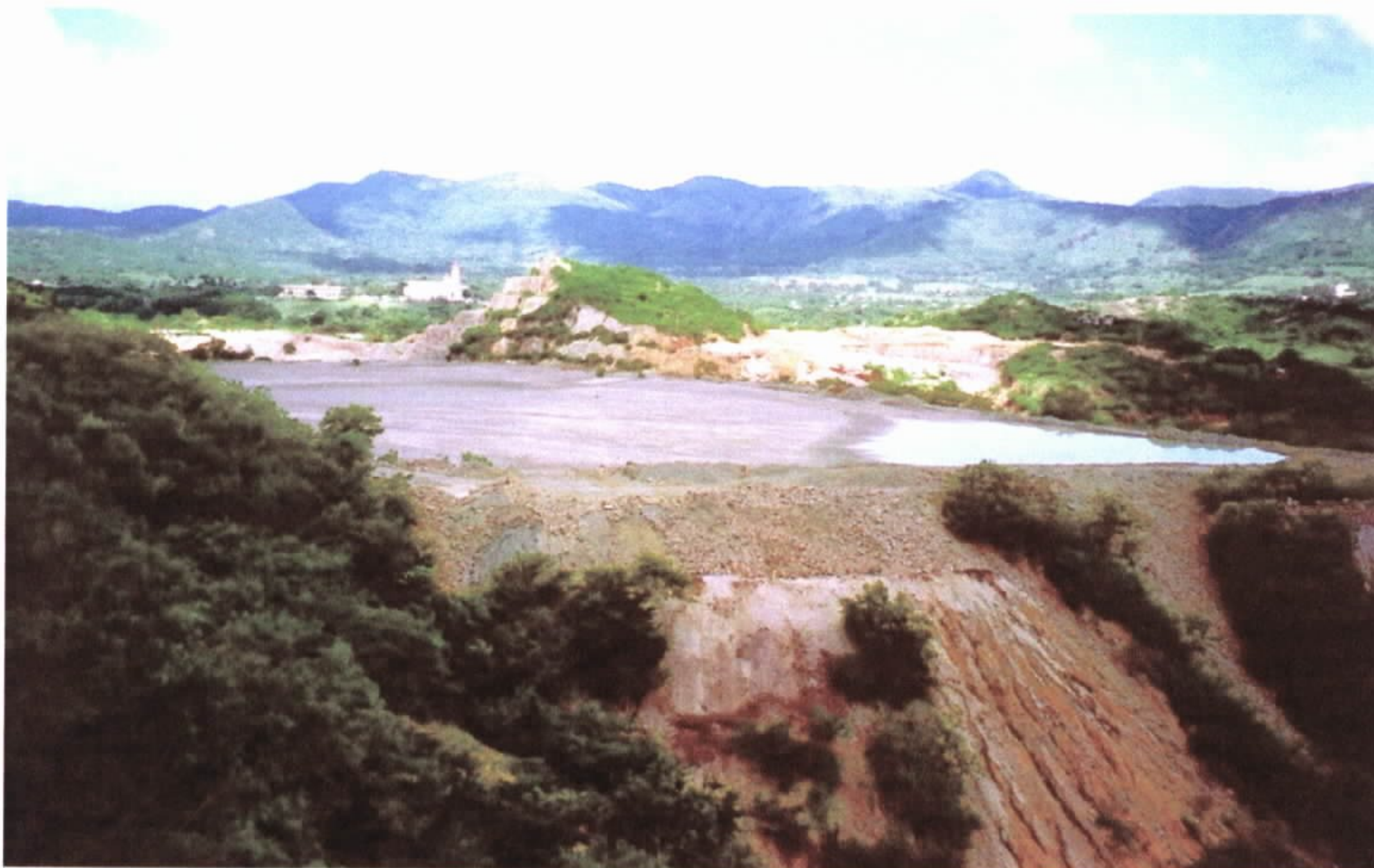
Foto 09 – Depósito de Rejeito (Cola C4), oriundo do processo de concentração do minério de cobre
