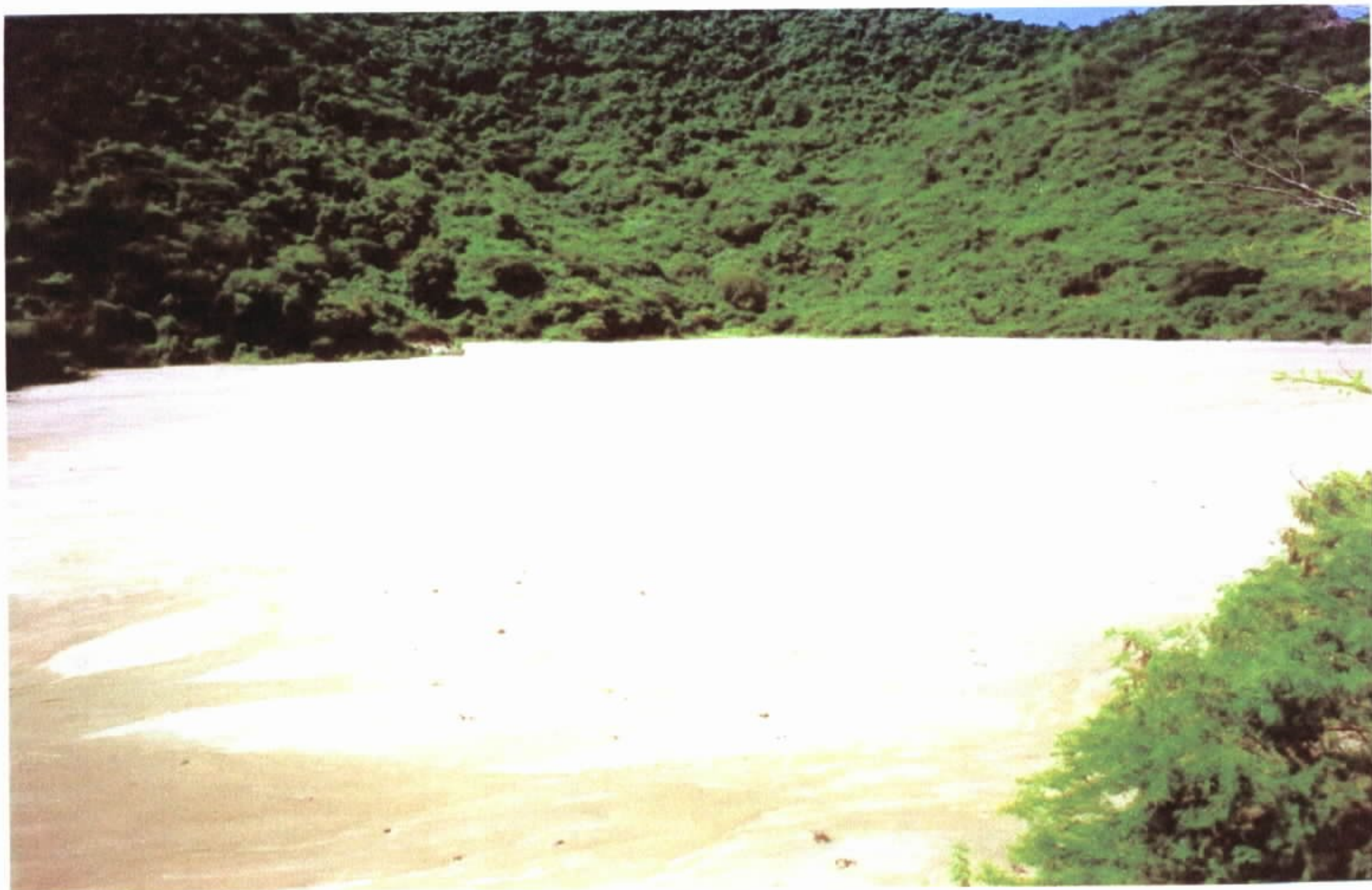
Foto 08 – Depósito de Rejeito (cola C1), oriundo do processo de concentração do minério de cobre
