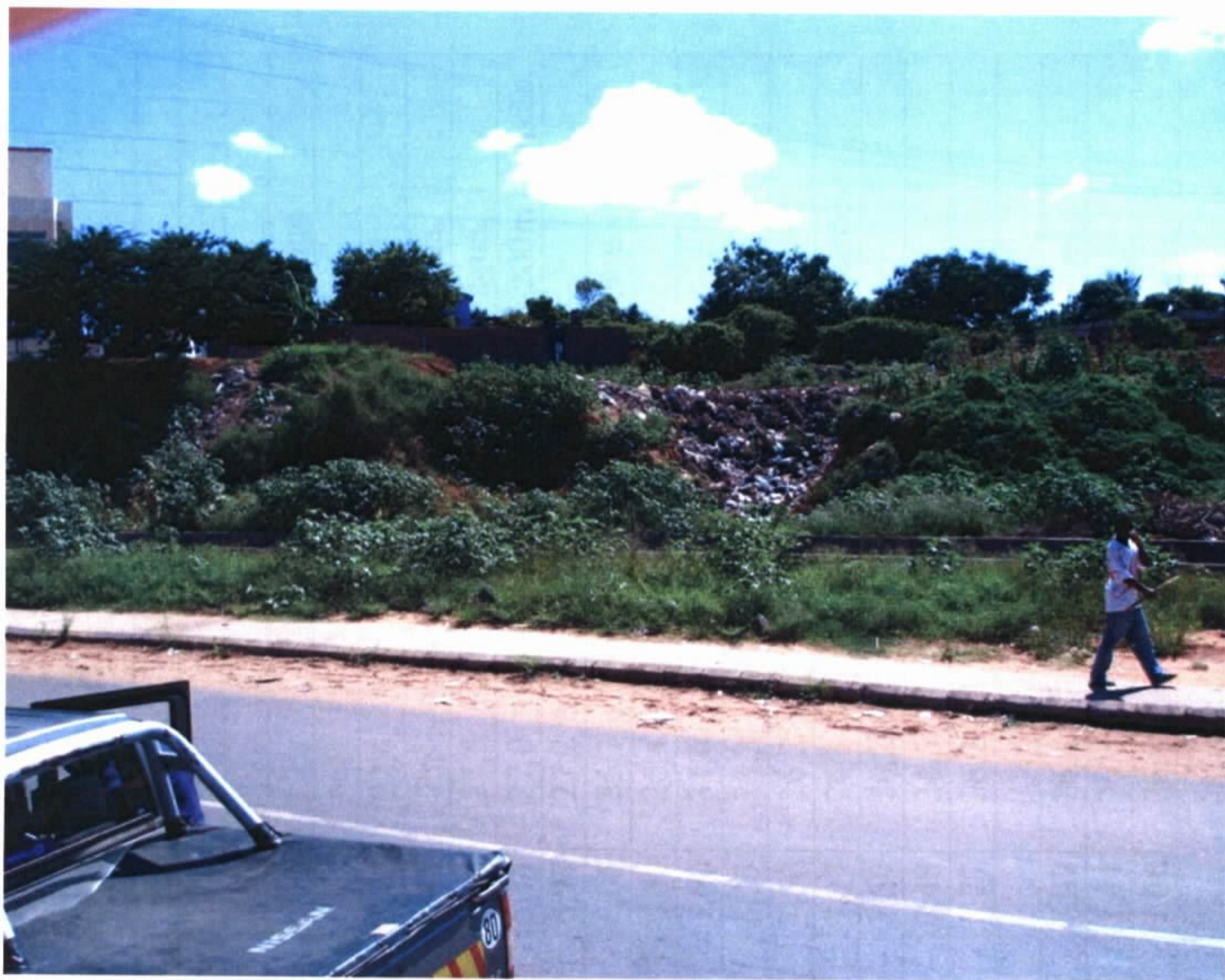
Fotografia 33 - Porção final da voçoroca.
