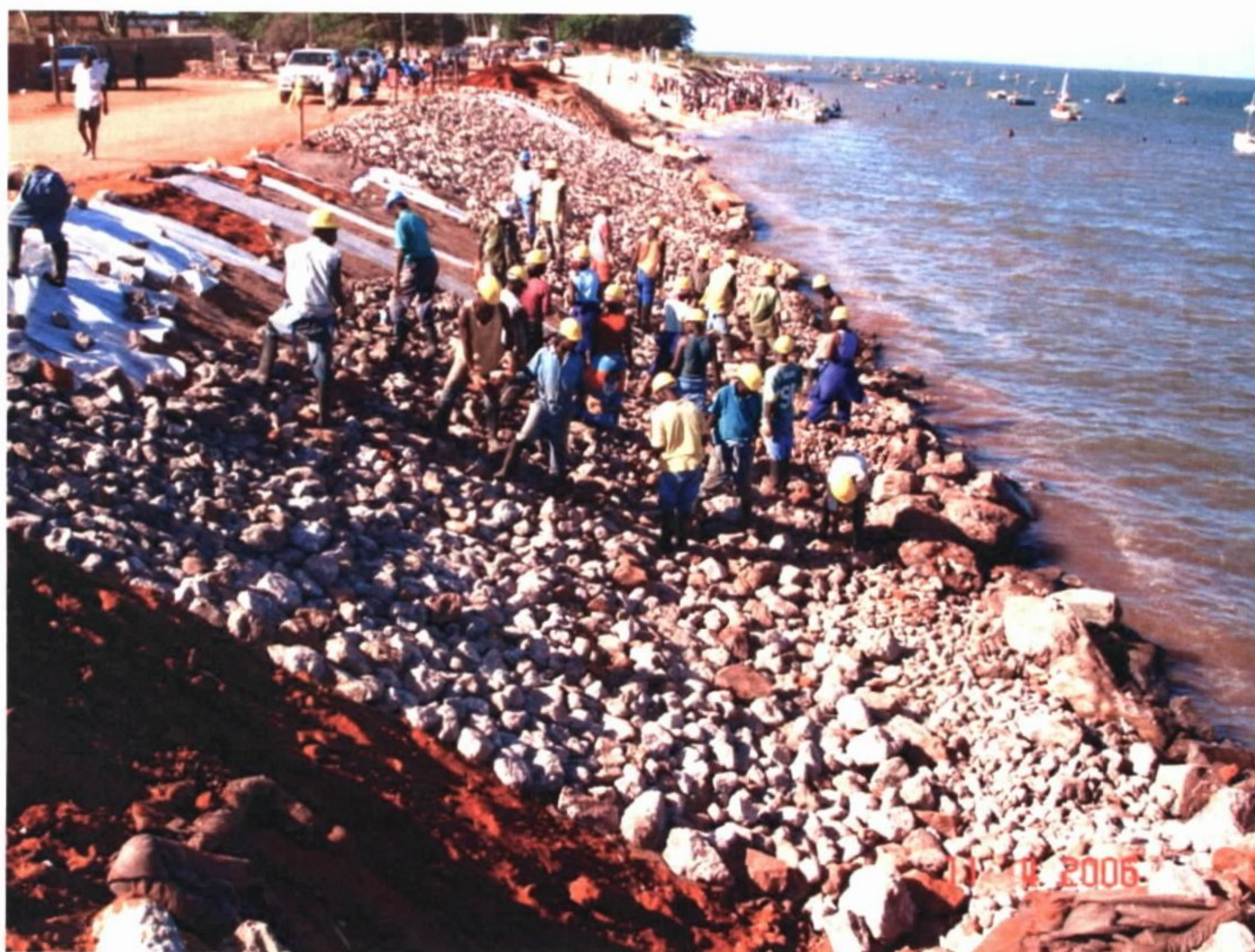
Fotografia 31 - Construção de obra de contenção.
