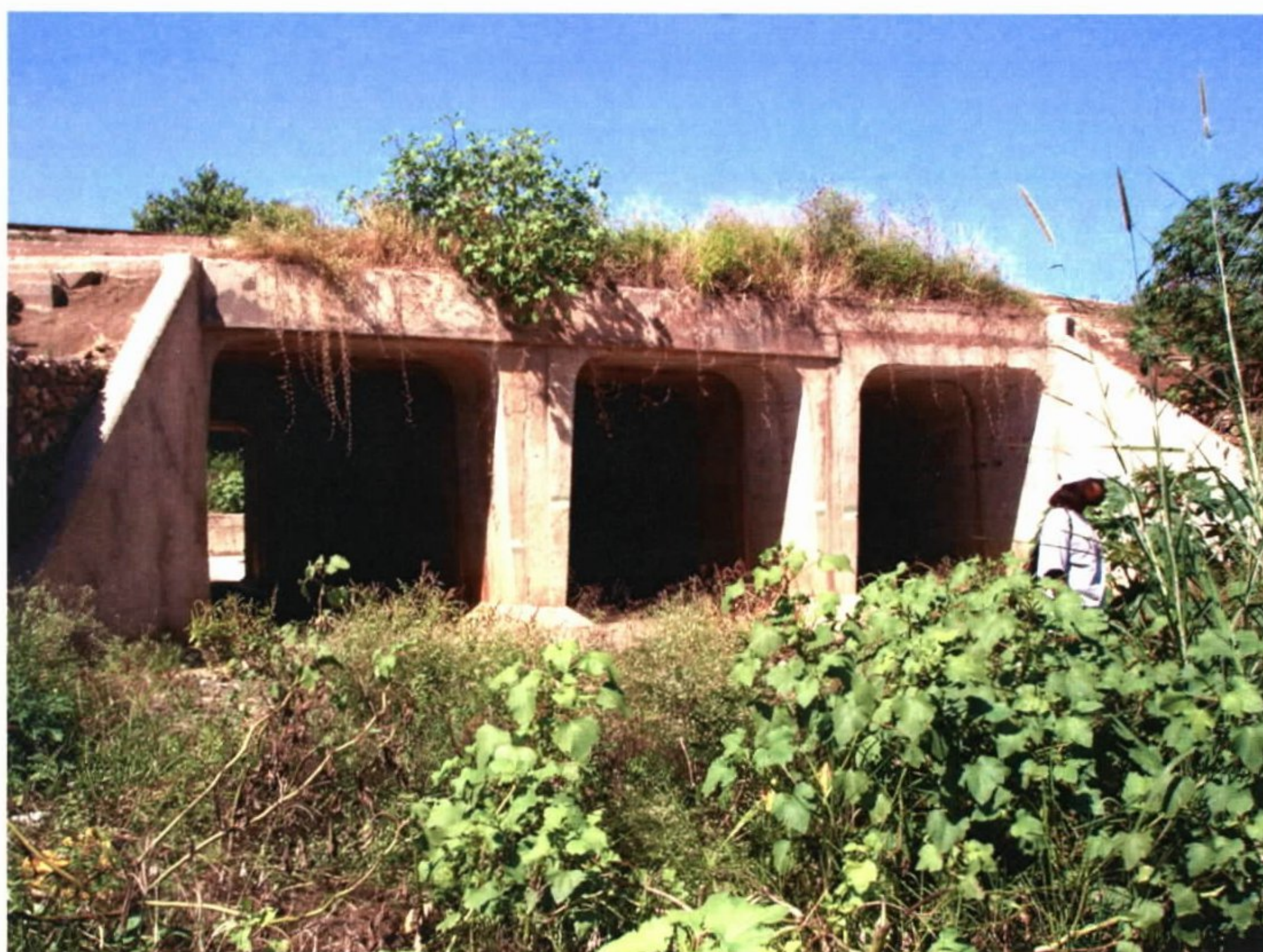
Fotografia 4 - Bueiro construído sob a estrada de ferro para escoamento das águas nas enchentes
