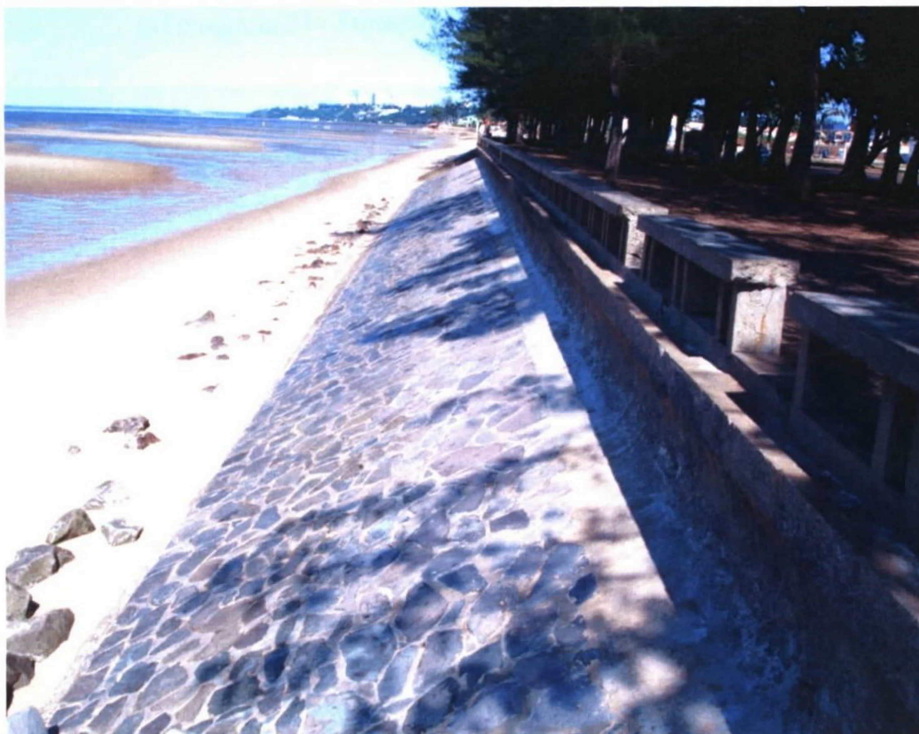
Fotografia 22 - Detalhe do calçadão e estrutura de contenção.
