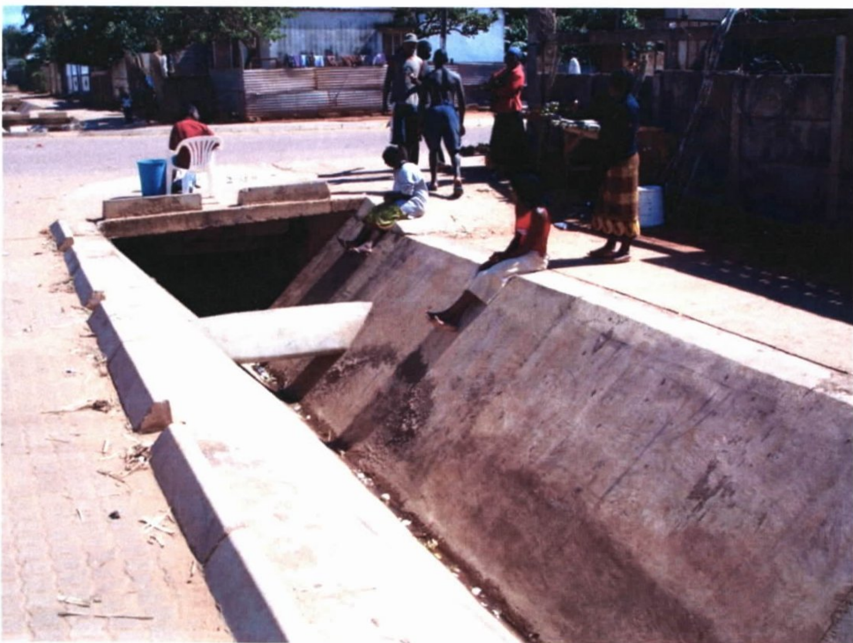
Fotografia 14 - Obras de contenção em concreto.
