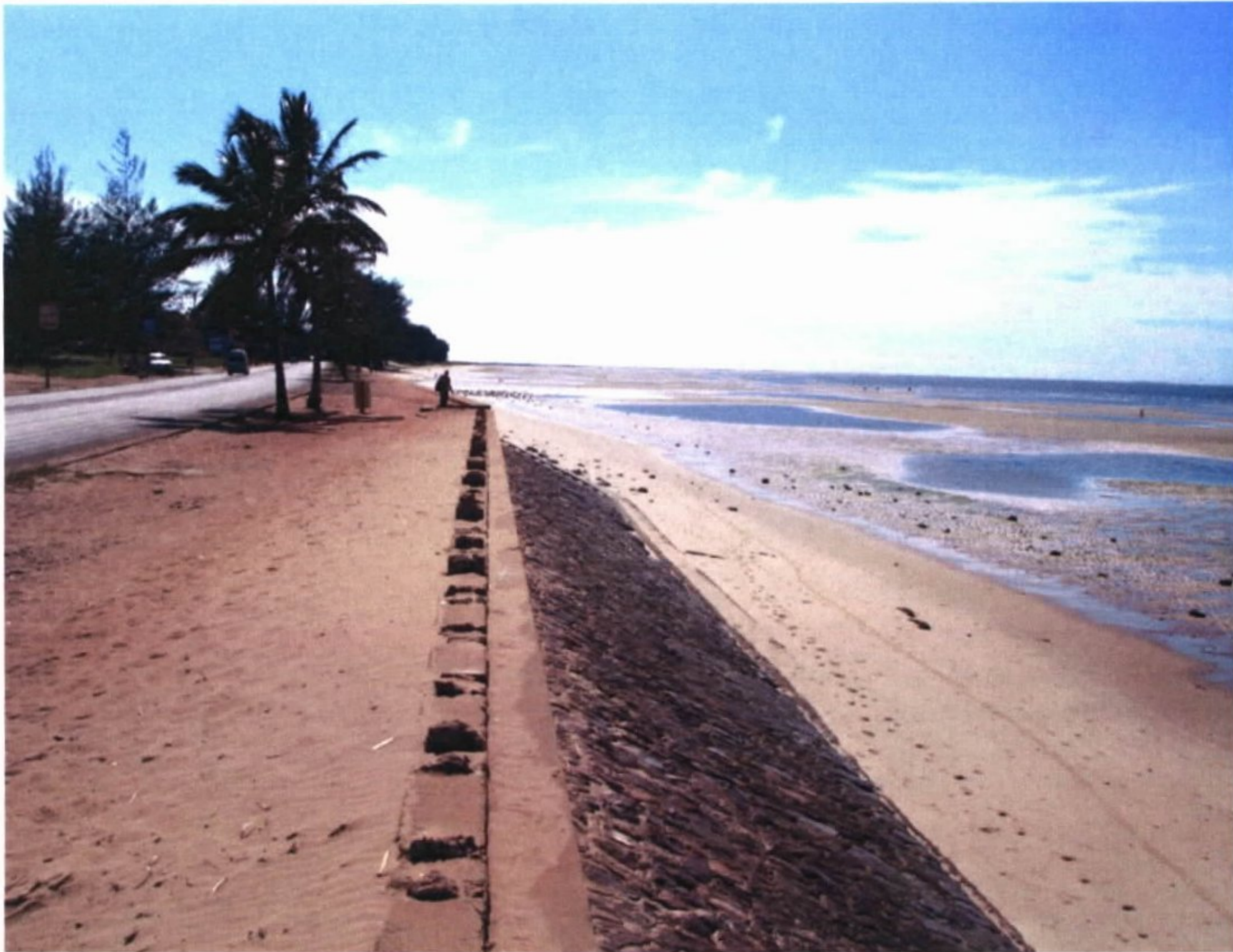
Fotografia 25 - Destruição de bancos por ação das ondas.
