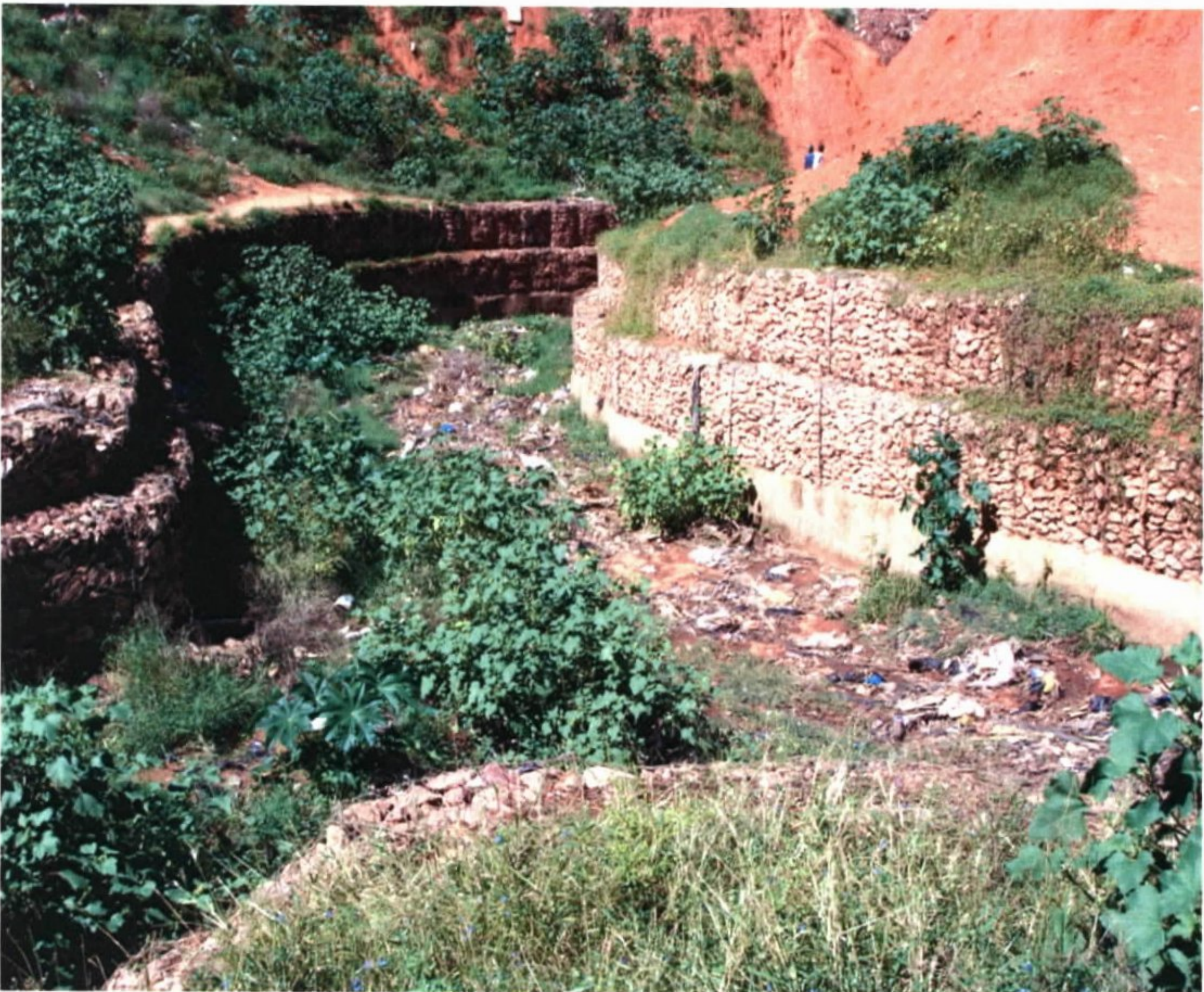
Fotografia 8 - Drenagem com as margens protegidas por gabiões
