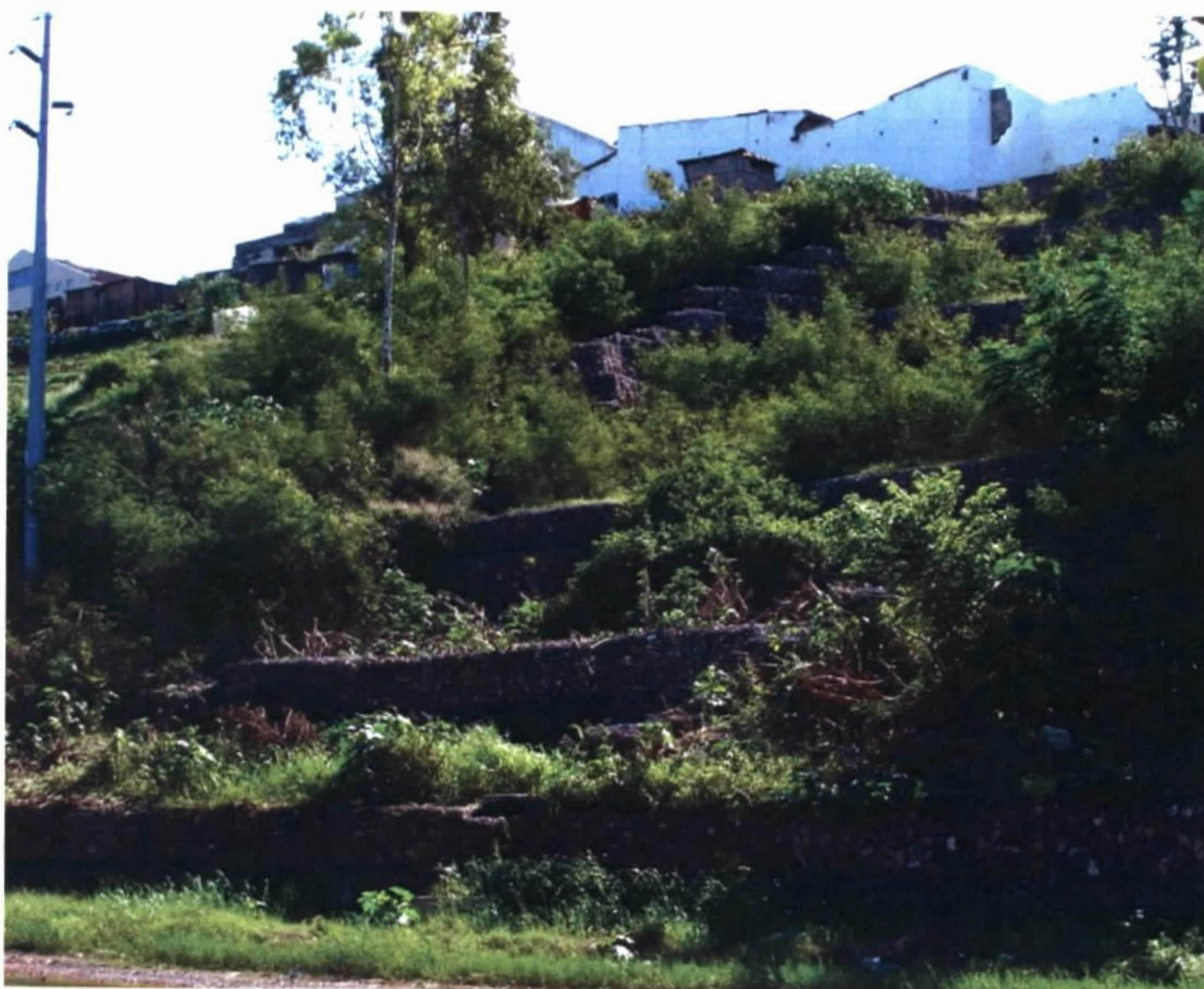
Fotografia 11 - Gabiões construídos após os deslizamentos de 2000/2001.
