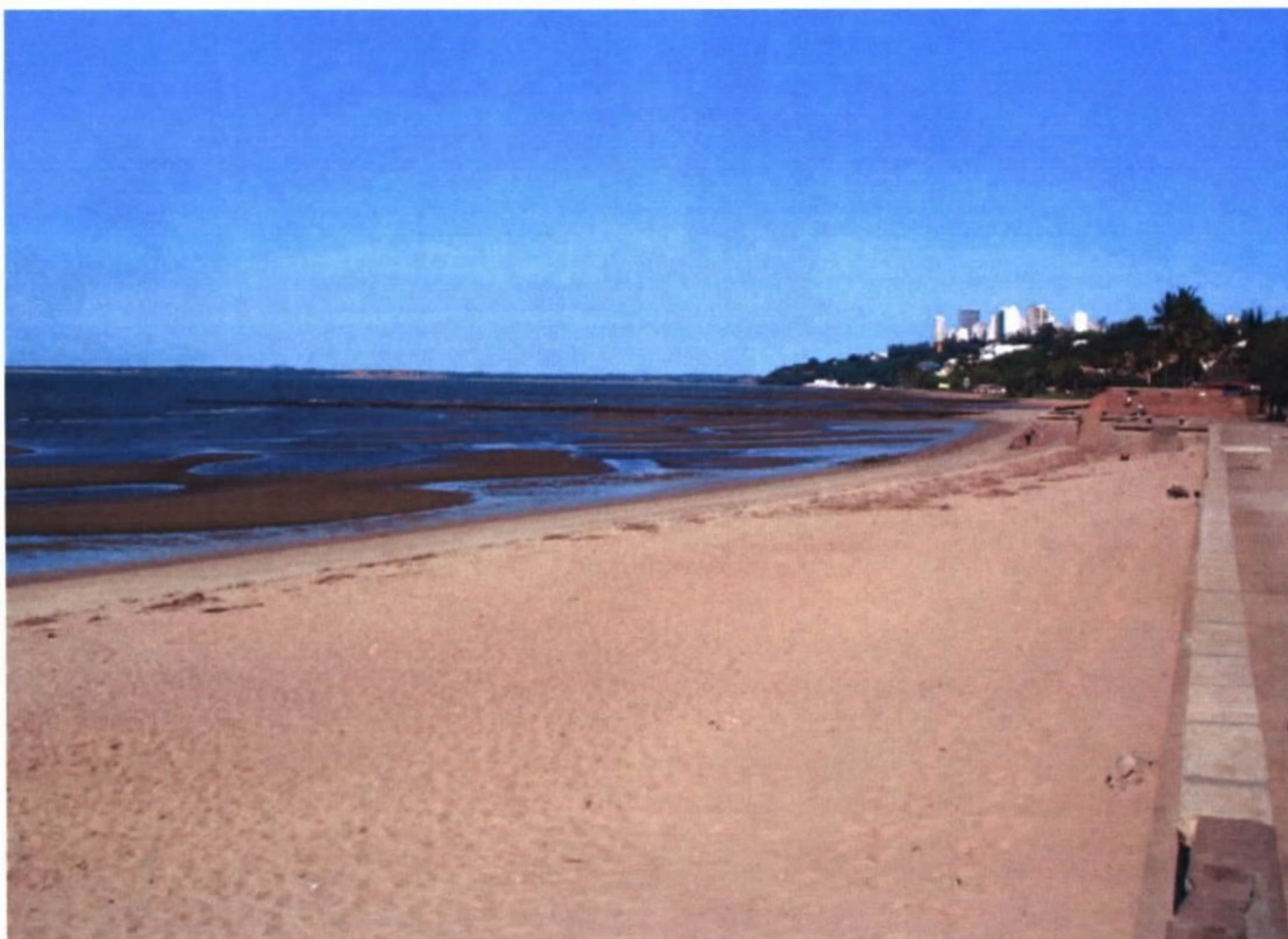
Fotografia 21 - Terceiro e segundo diques transversais à costa.
