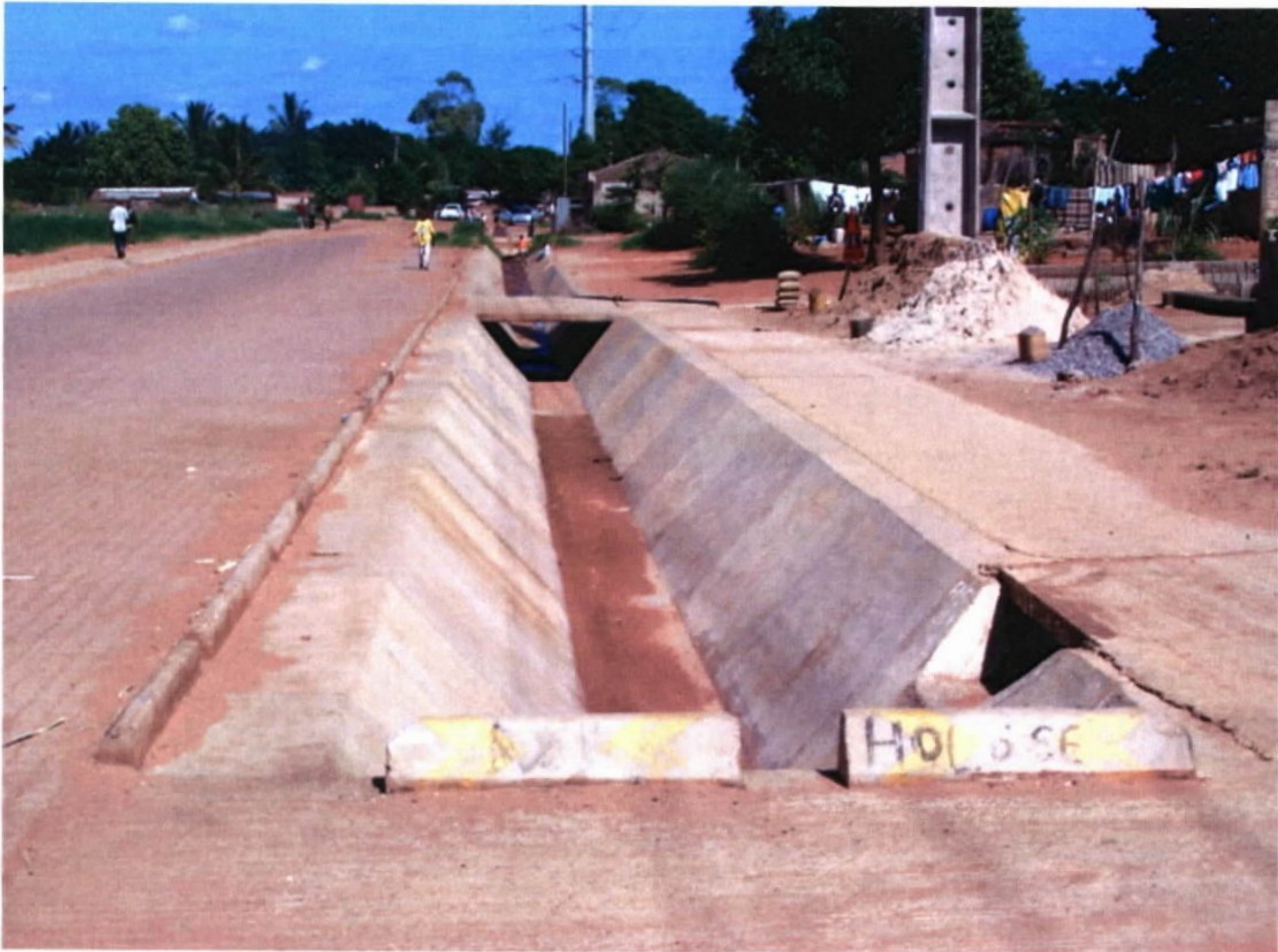
Fotografia 7 - Canal de drenagem em concreto
