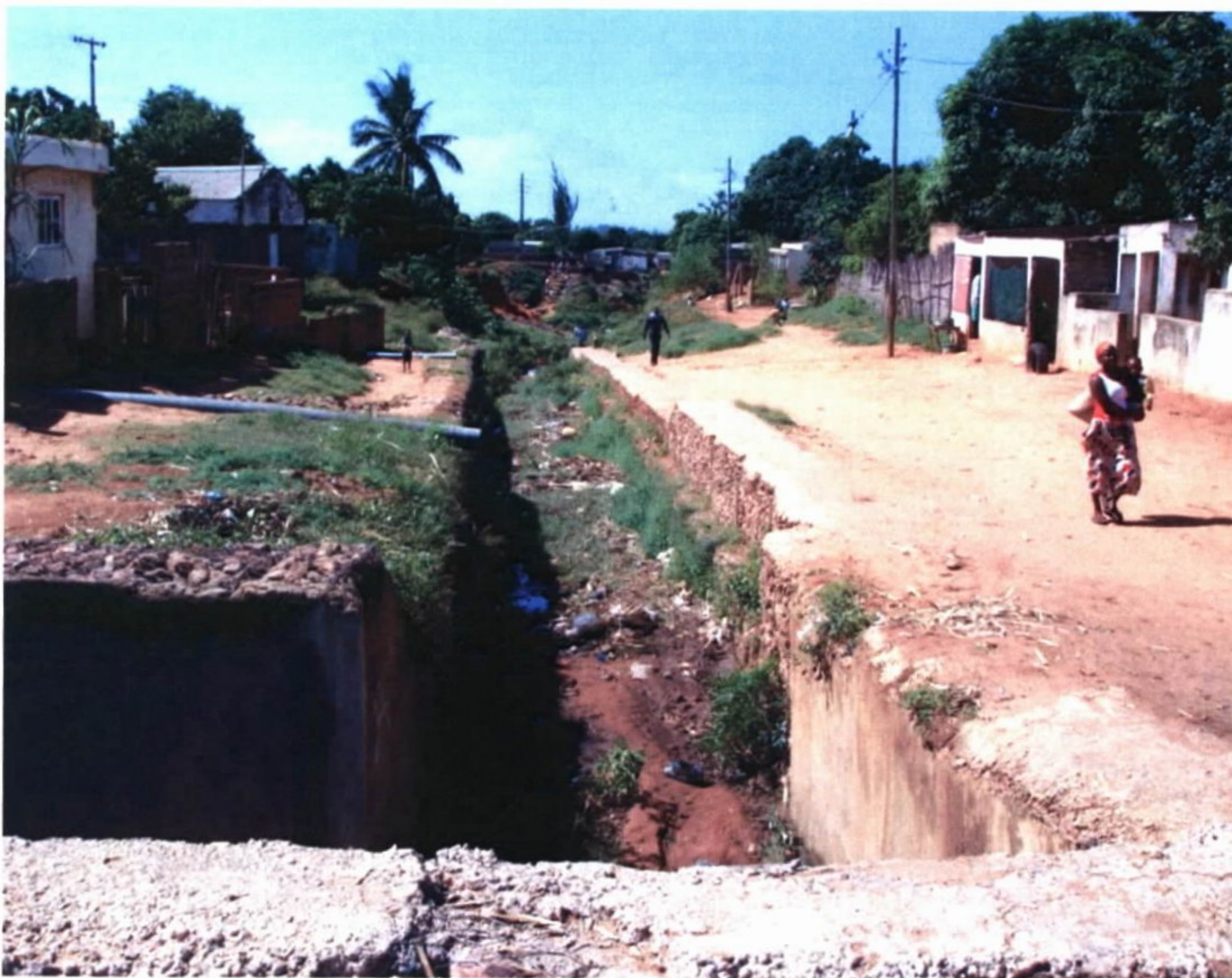
Fotografia 15 - Canal de gabiões.
