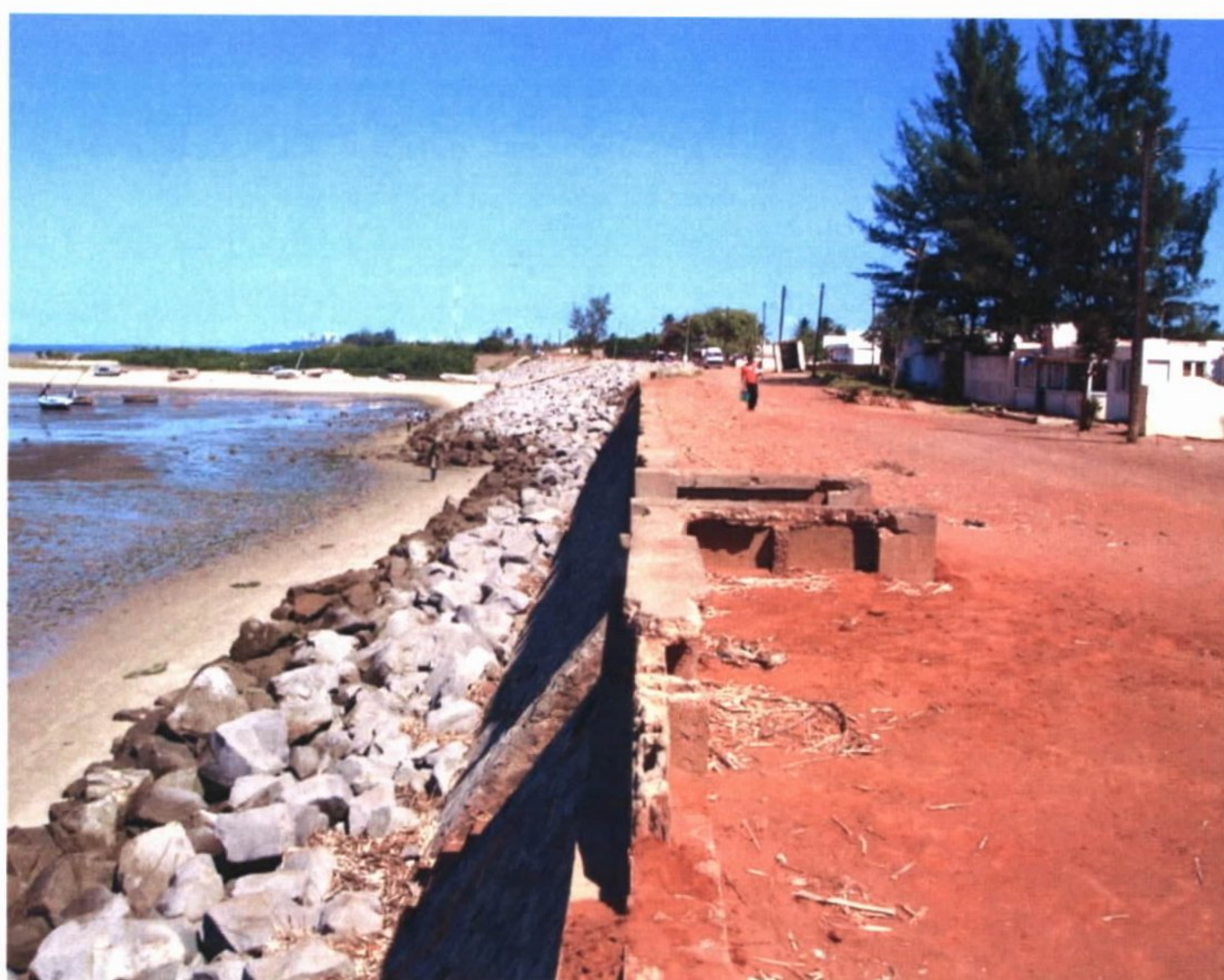
Fotografia 32 - Obra de contenção.
