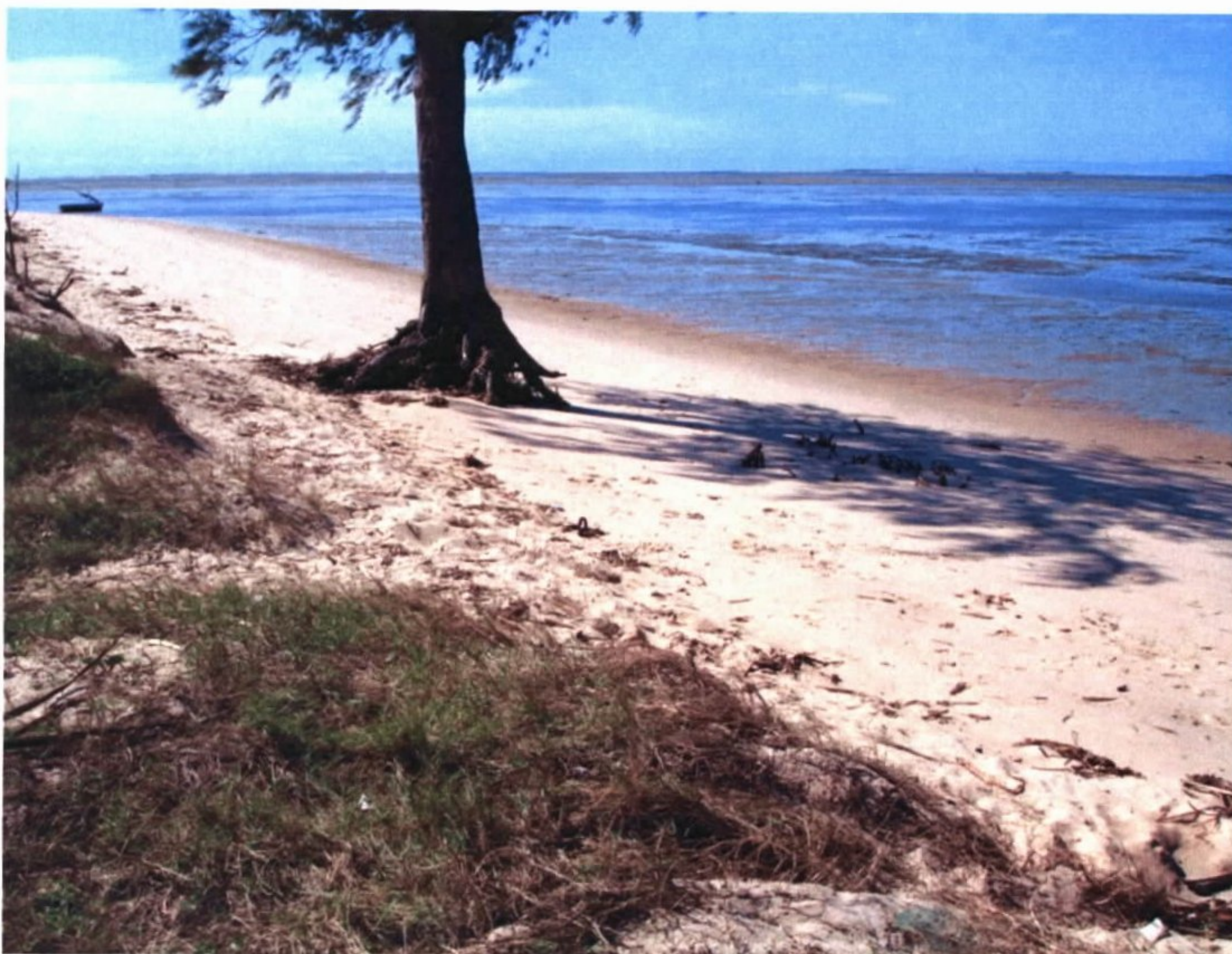
Fotografia 29 - Processo erosivo incipiente.
