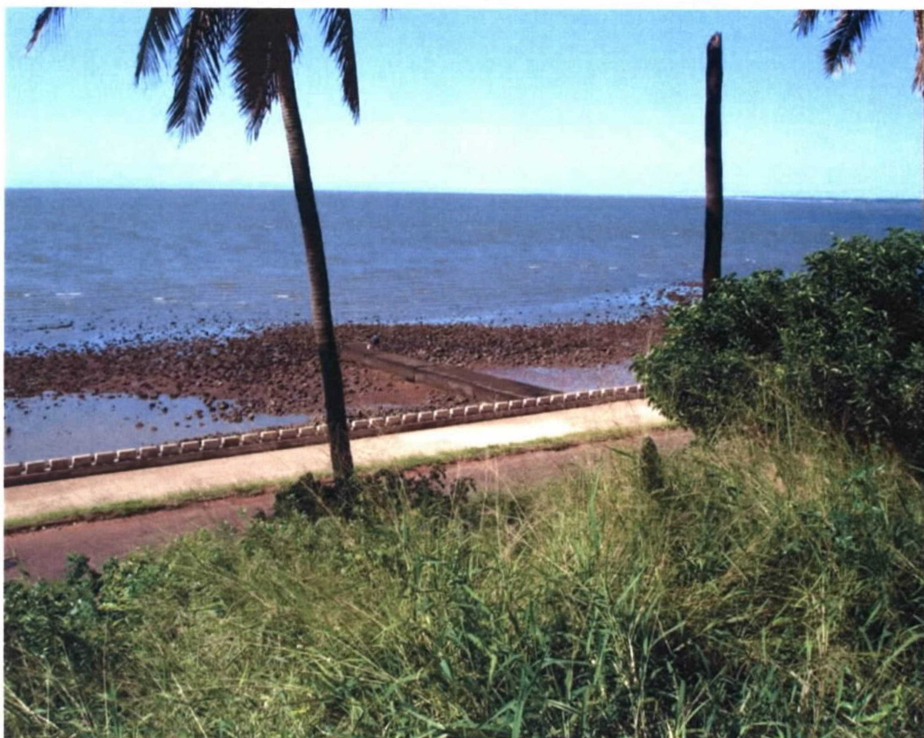
Fotografia 19 - Primeiro dique transversal à costa.
