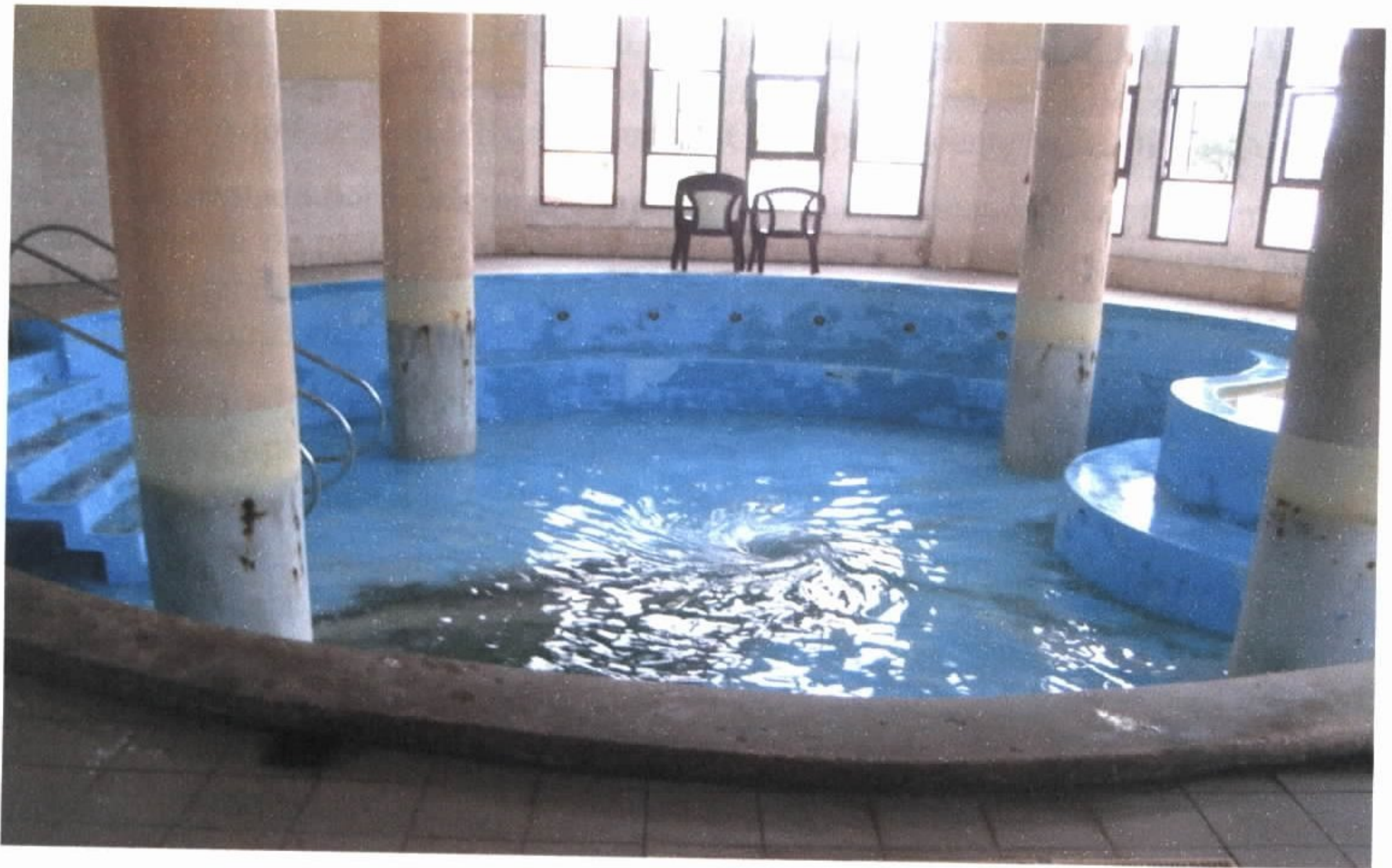
Foto 19 – Piscina térmica das novas instalações
