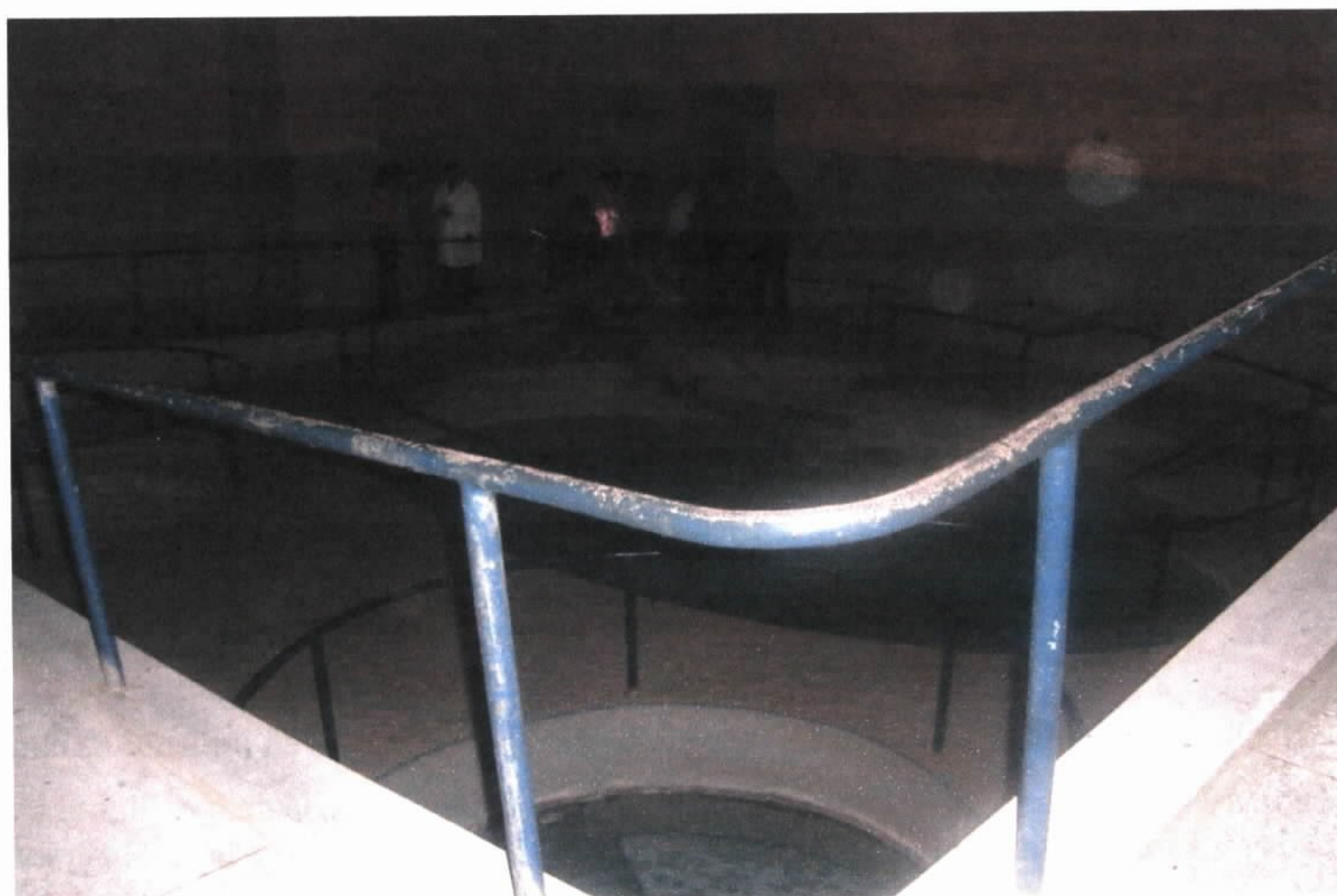
Foto 9 – Vista geral das piscinas
