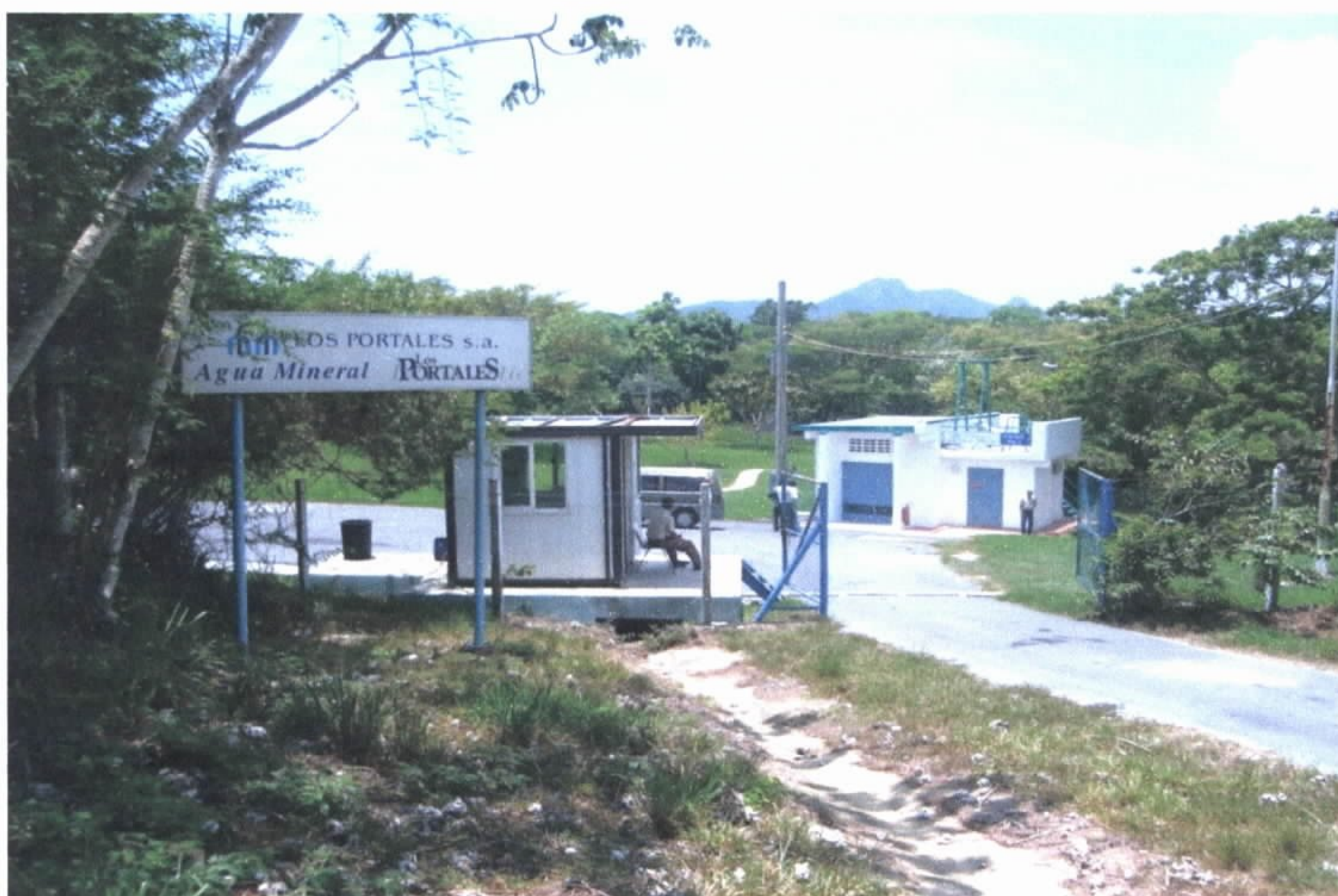
Foto 3 – Vista geral da captação
