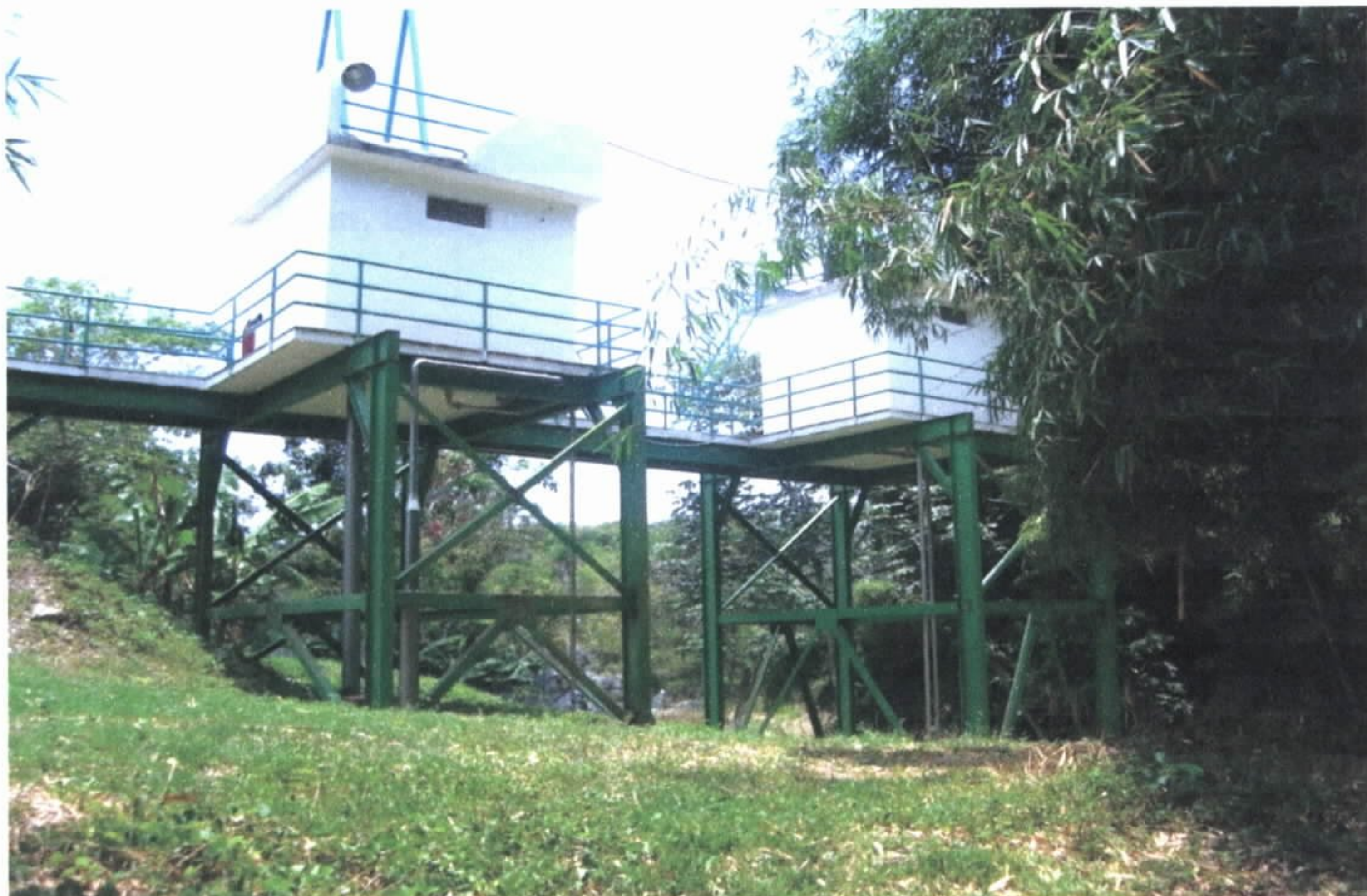
Foto 6 – Vista dos poços 2 e 3 com suas estruturas de elevação
