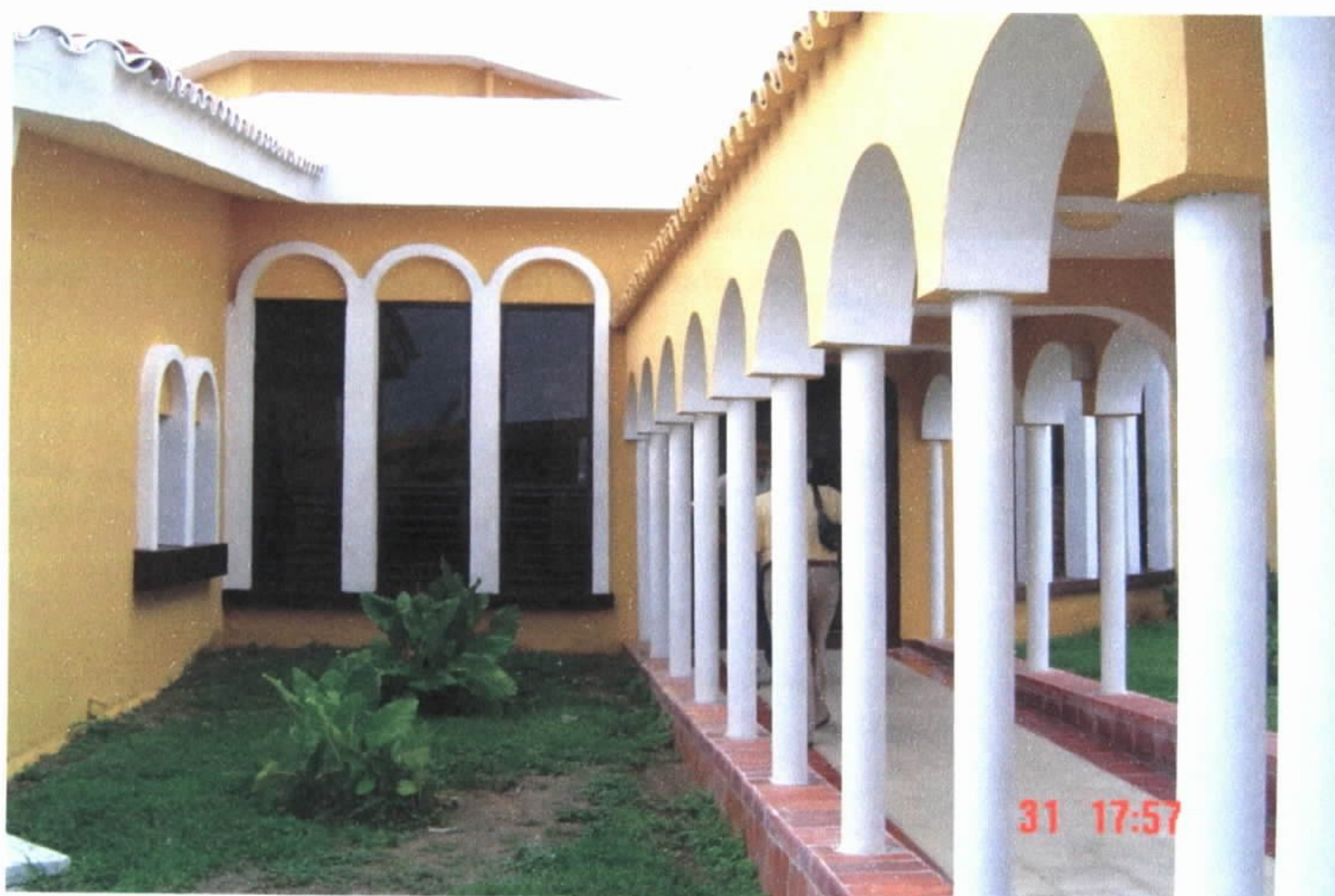
Foto 18 – Vista das instalações internas
