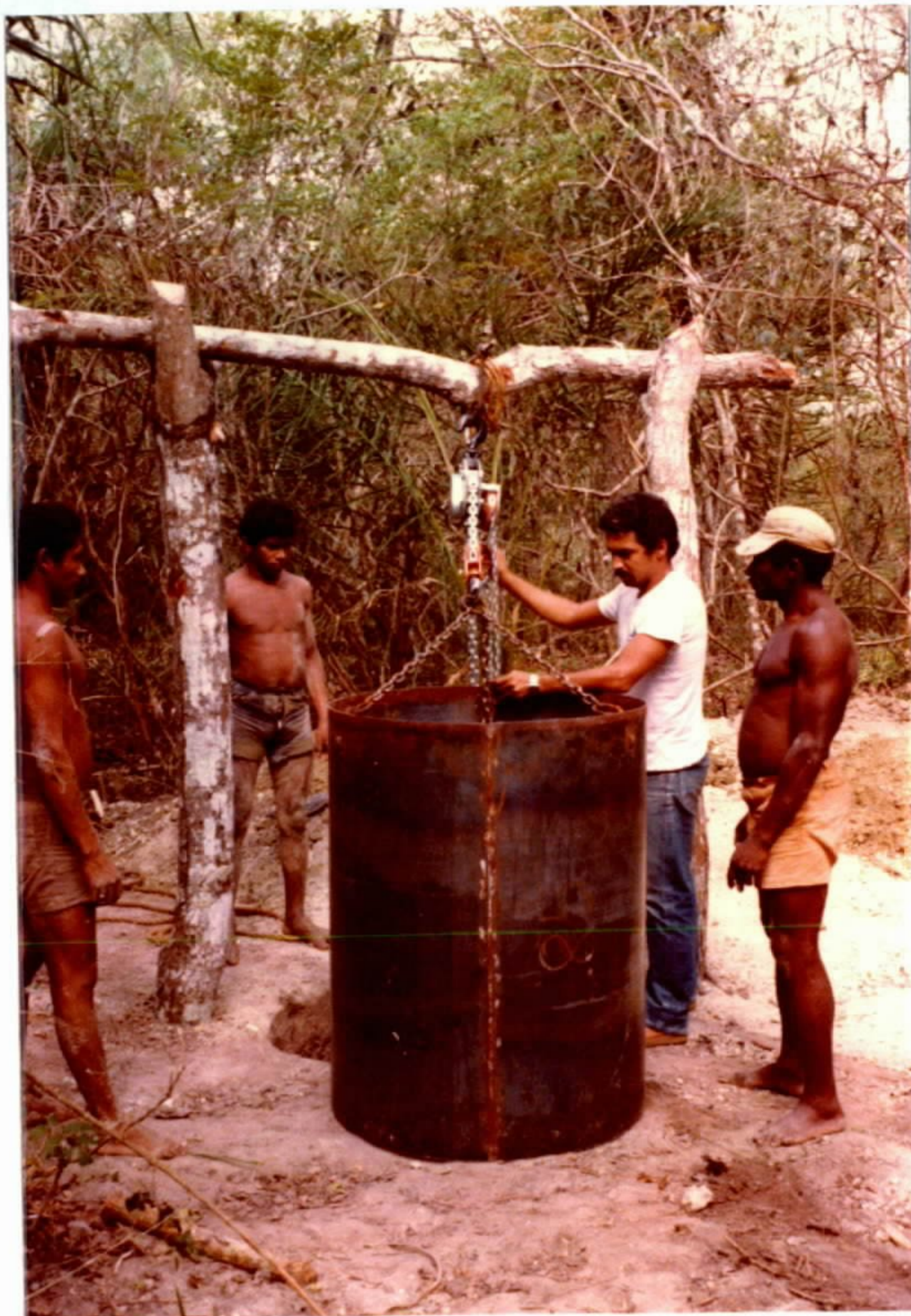
FOTO 06 - Anel de Entivação ("cavelage") utilizado para re vestimento das paredes dos poços, observando-se, ainda, a talha empregada durante as operações.
