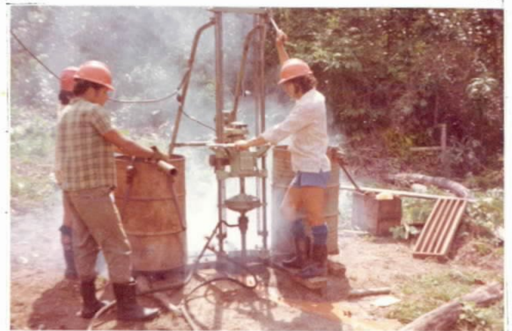
Operação com a sonda rotativa Winkie GW-15.
