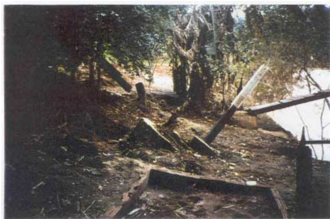
Estação de Velho da Taipa (40330000) – Apoio do cabo permanente de medição danificado pela cheia
