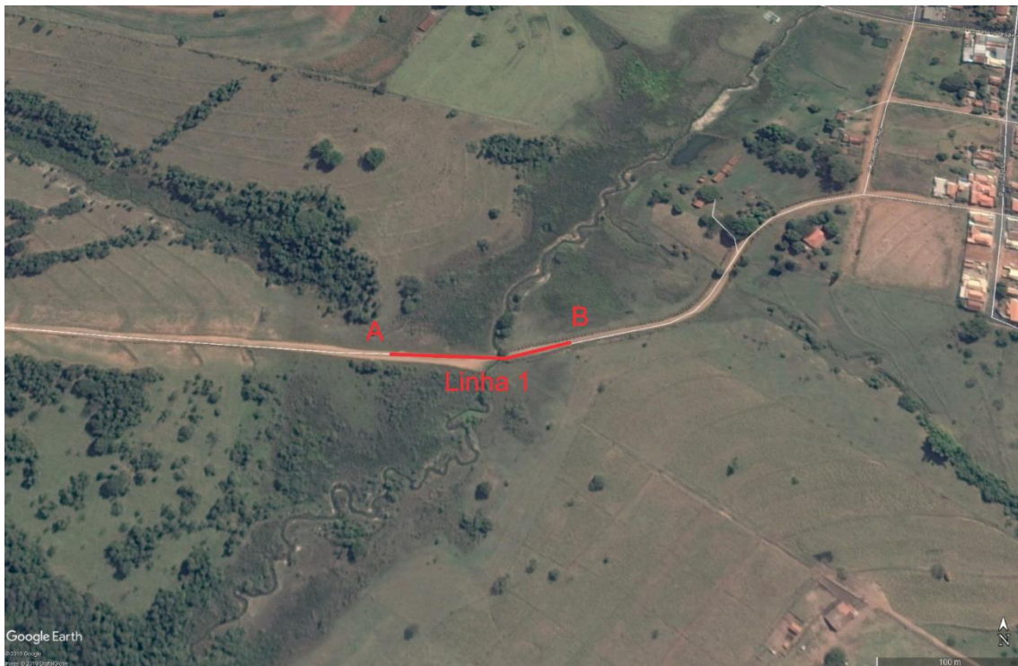
Figura 5 – Área de execução da Linha 1.
