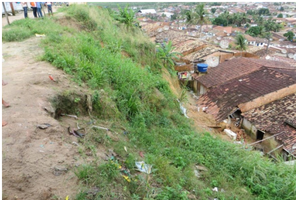
Na vista de perfil, a porção de solo deslocado mostra o volume de massa que pode atingir as moradias abaixo
