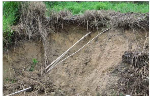
Os escorregamentos deixam à mostra a malha de tubos de ligações clandestinas para abastecimento.
