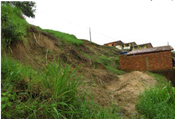
Moradores escavaram canaletas de drenagem aleatoriamente na face da encosta, tentando desviar o fluxo descendente das águas pluviais e transferindo o problema para outros vizinhos
