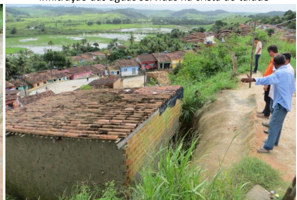
Moradia incrustada na crista do talude: risco alto de tombamento em caso de ruptura. As águas pluviais escorrem da rua para a base do imóvel
