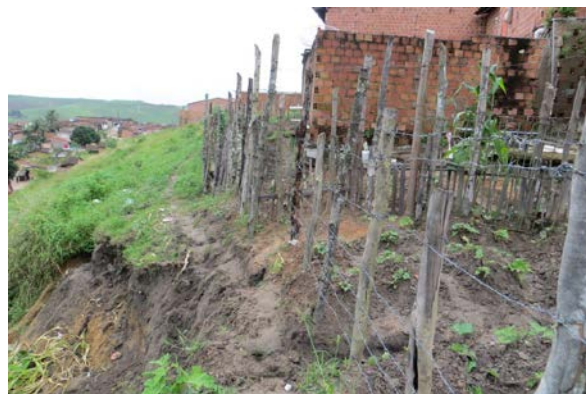
Solo arenoargiloso favorecendo a formação de ravinas e voçorocas: a área não poderia ser ocupada sem infraestrutura de drenagem e obras de contenção
