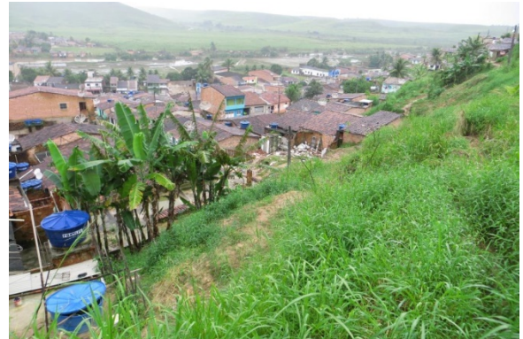
Identificamos valas escavadas na face da encosta, que desviavam as águas pluviais na direção da moradia destruída (abaixo), podendo ser uma das causas do escorregamento
