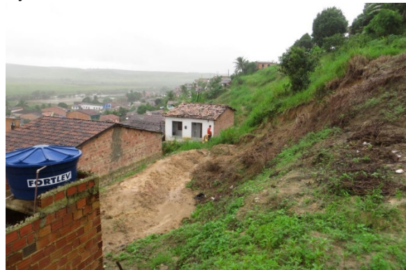
Moradores escavaram canaletas de drenagem aleatoriamente na face da encosta, tentando desviar o fluxo descendente das águas pluviais e transferindo o problema para outros vizinhos
