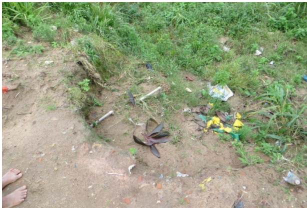
No mesmo trecho da encosta, outra trinca com degrau de abatimento evidencia a iminência de escorregamento: tragédia anunciada e marcada no terreno
