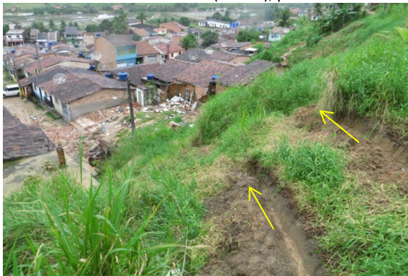
Identificamos valas escavadas na face da encosta, que desviavam as águas pluviais na direção da moradia destruída (abaixo), podendo ser uma das causas do escorregamento
