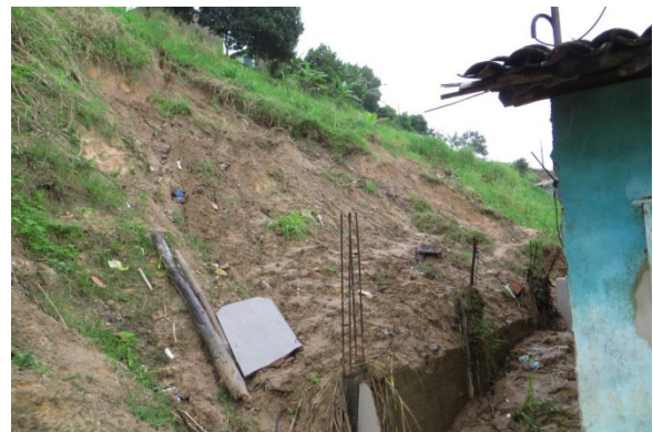
Cicatrizes marcam a ocorrência de vários escorregamentos na encosta, que se encontra saturada e com vegetação rala. A proximidade das moradias à base da encosta, e a ausência de drenagem de crista e base da encosta, são fatores que potencializam o grau de risco na área
