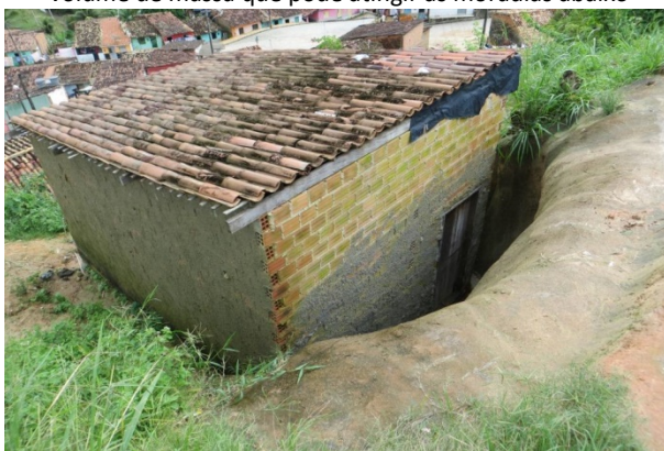
Moradia incrustada na crista do talude: risco alto de tombamento em caso de ruptura. As águas pluviais escorrem da rua para a base do imóvel
