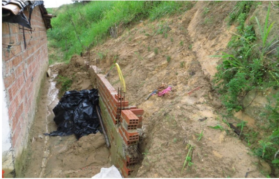
À direita, moradores, na ausência de orientação técnica, constroem muros de arrimo com tijolos, adquirindo uma falsa sensação de proteção da moradia
