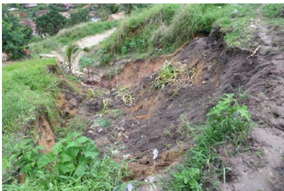
Solo arenoargiloso favorecendo a formação de ravinas e voçorocas: a área não poderia ser ocupada sem infraestrutura de drenagem e obras de contenção
