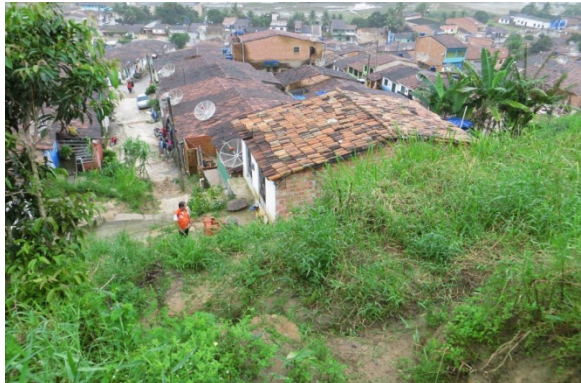
Identificamos valas escavadas na face da encosta, que desviavam as águas pluviais na direção da moradia destruída (abaixo), podendo ser uma das causas do escorregamento
