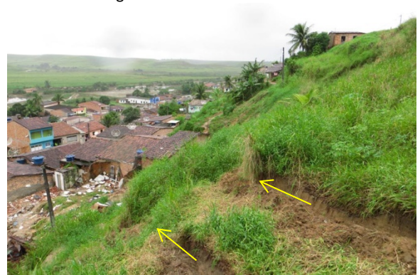
Identificamos valas escavadas na face da encosta, que desviavam as águas pluviais na direção da moradia destruída (abaixo), podendo ser uma das causas do escorregamento
