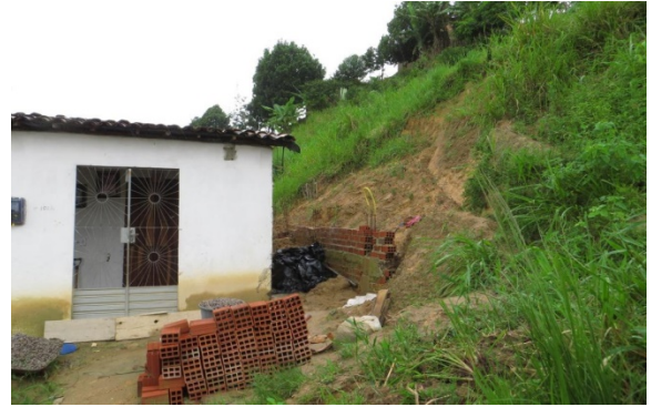
À direita, moradores, na ausência de orientação técnica, constroem muros de arrimo com tijolos, adquirindo uma falsa sensação de proteção da moradia
