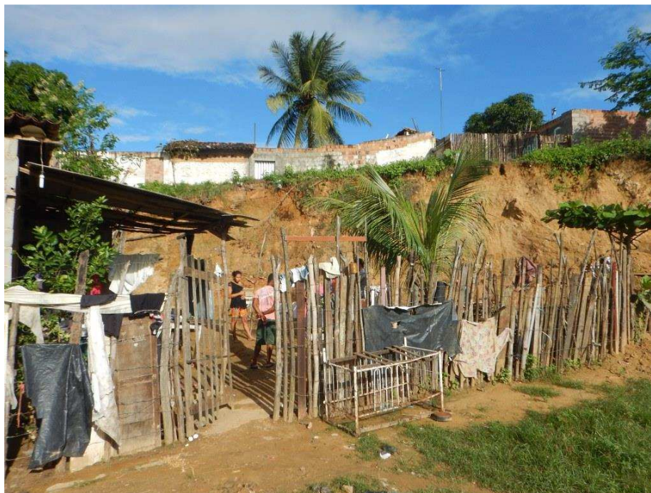
Foto 3 – Visão geral da encosta. Notar a parte dos fundos das casas na parte superior do talude.
