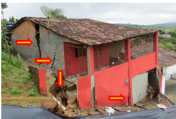
As setas horizontais mostram as rachaduras provocadas pela movimentação do solo sobre a rocha. A seta vertical mostra a trinca no terreno
