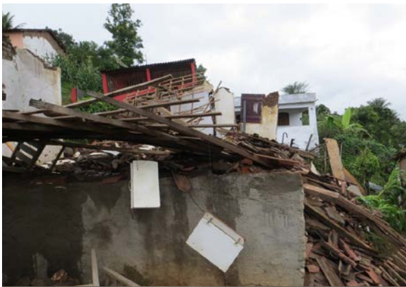
A casa destruída: trincas disseminadas no solo e seu efeito na edificação
