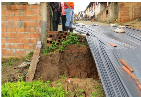
Rejeito vertical provocado pela ruptura e movimentação do solo sobre a rocha
