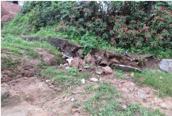
Ruptura da sarjeta por compressão
