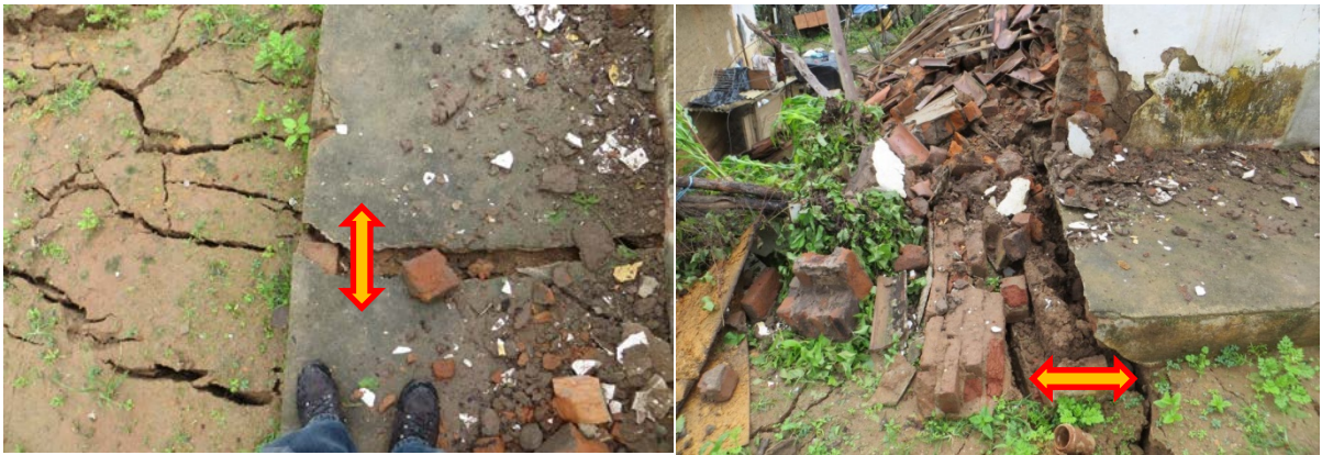
A casa destruída: trincas disseminadas no solo e seu efeito na edificação
