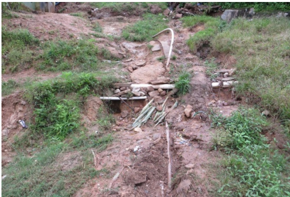
A compressão provocada pelo escorregamento solo-sobre-rocha provocou a deformação da tubulação adutora da rua
