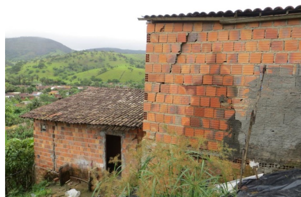
Sentido do movimento do solo na área da trinca. No lado esquerdo da foto, duas das casas destruídas
