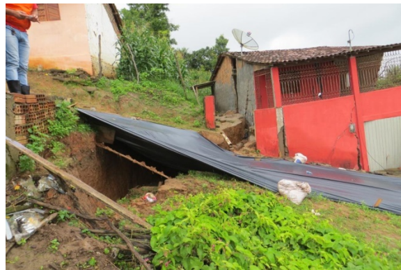
Perfil da trinca: o degrau de abatimento formado expôs tubulações e a rocha subjacente. A casa vermelha sofreu afundamento lateral e torção estrutural que provocou rachaduras em todo o imóvel
