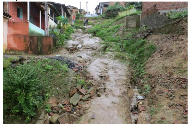
No trecho sem drenagem ou calçamento, as águas traçaram seu caminho, tornando a rua intransitável.
