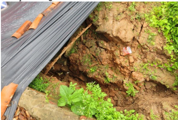
Perfil da trinca: o degrau de abatimento formado expôs tubulações e a rocha subjacente. A casa vermelha sofreu afundamento lateral e torção estrutural que provocou rachaduras em todo o imóvel
