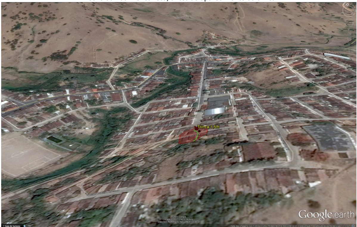
Vista de perfil da Rua Frei Caneca: o polígono vermelho indica a área de influência da trinca.
