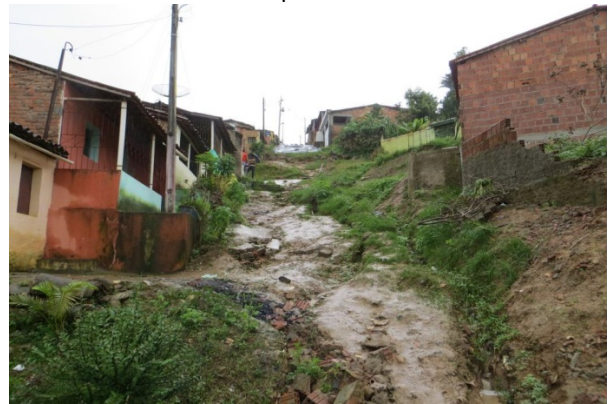
No trecho sem drenagem ou calçamento, as águas traçaram seu caminho, tornando a rua intransitável.
