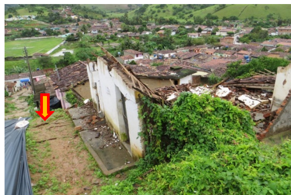
Continuidade lateral da trinca no terreno, com formação de degraus de abatimento e ramificações visíveis, que destruíram por completo uma moradia de qualidade construtiva inferior às mostradas acima
