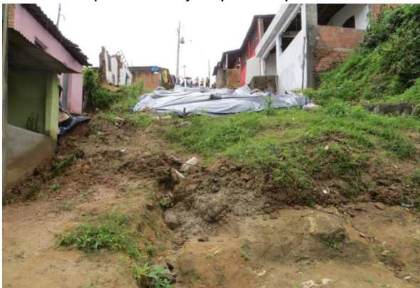
Ruptura da sarjeta por compressão
