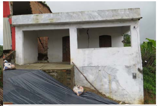
A casa destruída: trincas disseminadas no solo e seu efeito na edificação
