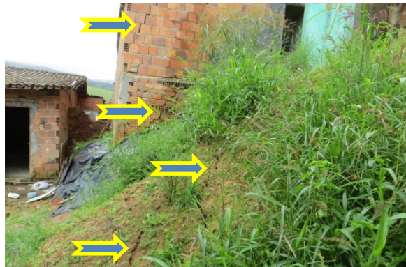
Trincas no terreno e paredes
