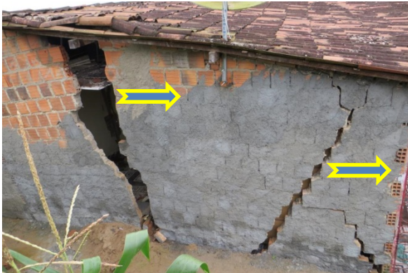
O imóvel sofreu afundamento lateral e frontal. As setas indicam a direção do movimento da estrutura
