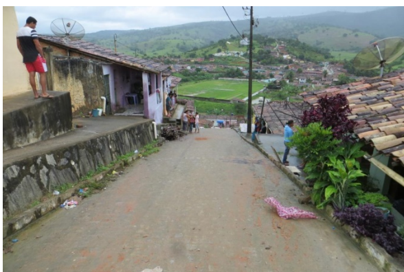
Trecho calçado da Rua Frei Caneca, com declividade média de 12°. A rua recebe águas pluviais de duas outras ruas a montante
