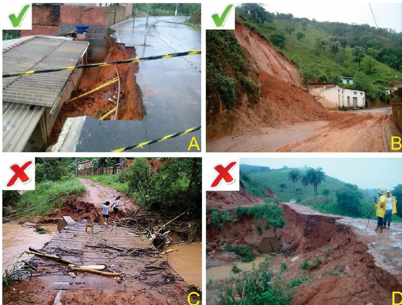
Figura 01 - Situações que são e que não são objeto de análise das setorizações de áreas de risco geológico. As fotos A e B apresentam instabilizações em taludes de rodovias, cujas margens são habitadas, e, portanto, são consideradas áreas de risco geológico. A foto C ilustra um caso de comprometimento de via de acesso por danos causados a uma ponte e a foto D mostra instabilizações em rodovia com margens não habitadas (não caracterizam áreas de risco geológico). Fotos: acervo SGB-CPRM.
