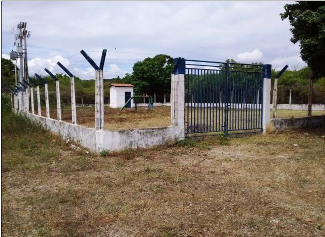
Foto 18: Estrutura de integração do poço Caburé II ao sistema de abastecimento da EMBASA, Euclides da Cunha – BA.
