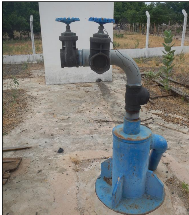
Foto 34: Poço Lagoa do Canto, tubo de saída e duas válvulas para controle de captação de água.
