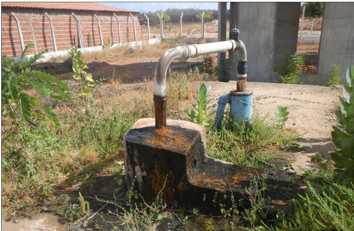
Foto 38: Poço Bairro Valdir Leite em funcionamento com nova bomba instalada. Não foi possível identificar o destino da água extraída e nem a potência da nova bomba.
