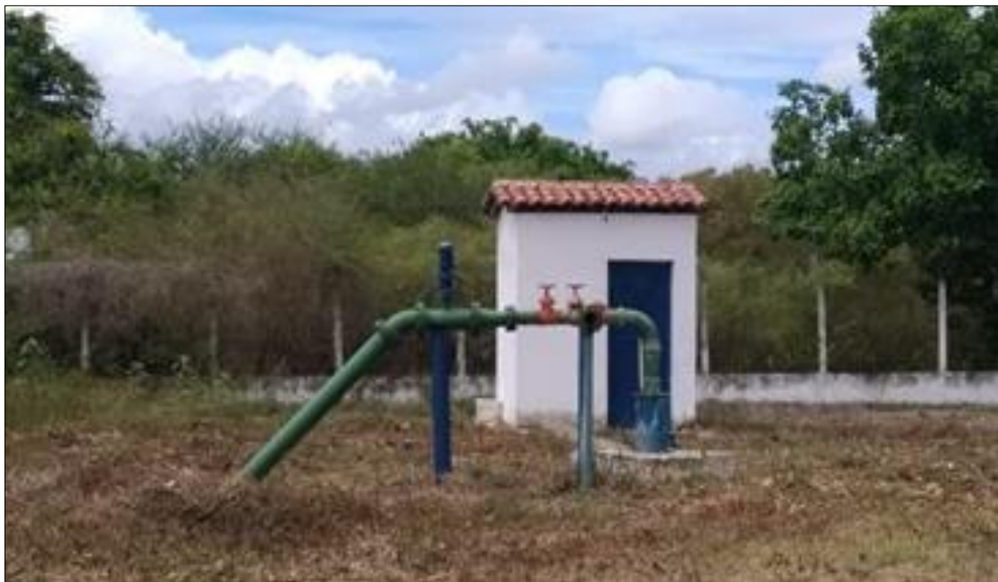
Foto 26: Instalações e tubulação de adução em bom estado de conservação.
