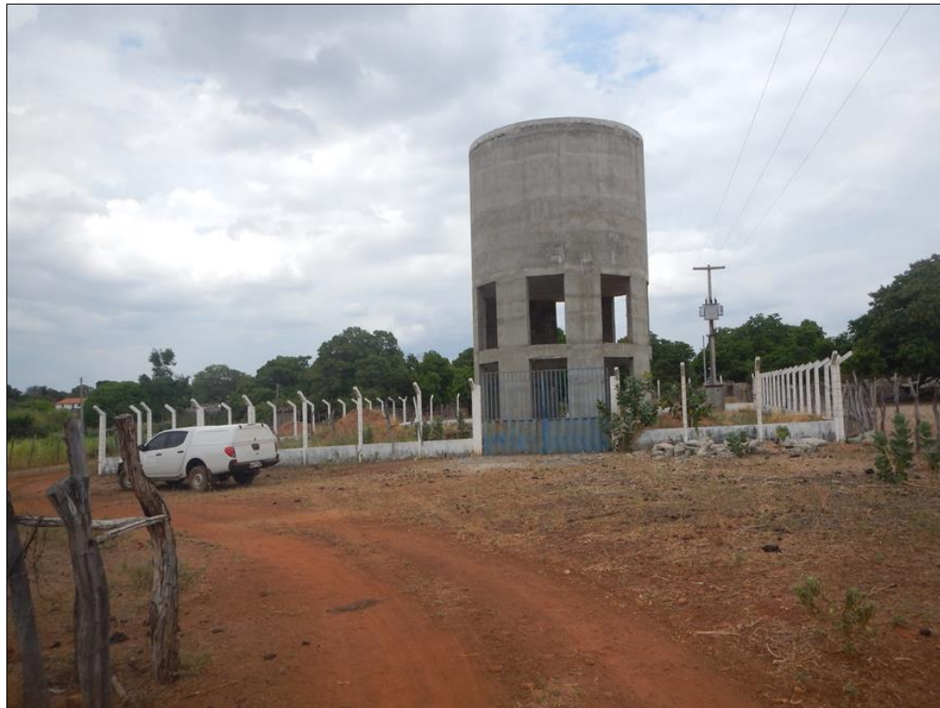
Foto 32: Vista geral do poço Lagoa do Canto, mostrando a área de urbanização.
