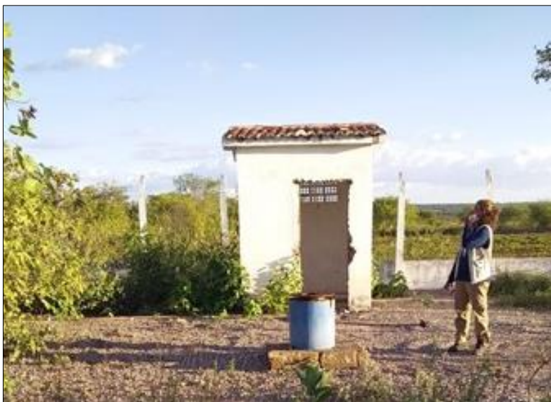
Foto 23: Estrutura de instalação do Poço Sítio Ervanso, Mirandiba.
