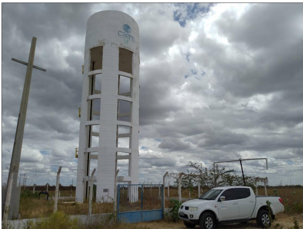
Foto 2: Poço Siagas-2600054924 na localidade de Juremal, Baraúnas – RN.
