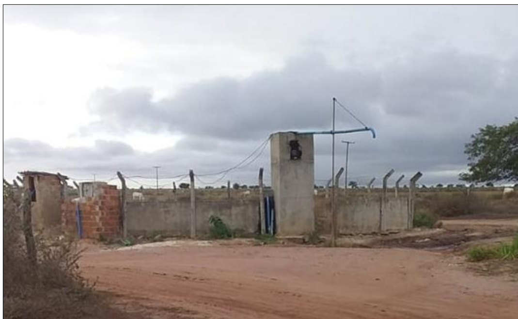
Foto 16: Estrutura externa de captação de água do poço do assentamento Porto Seguro.
