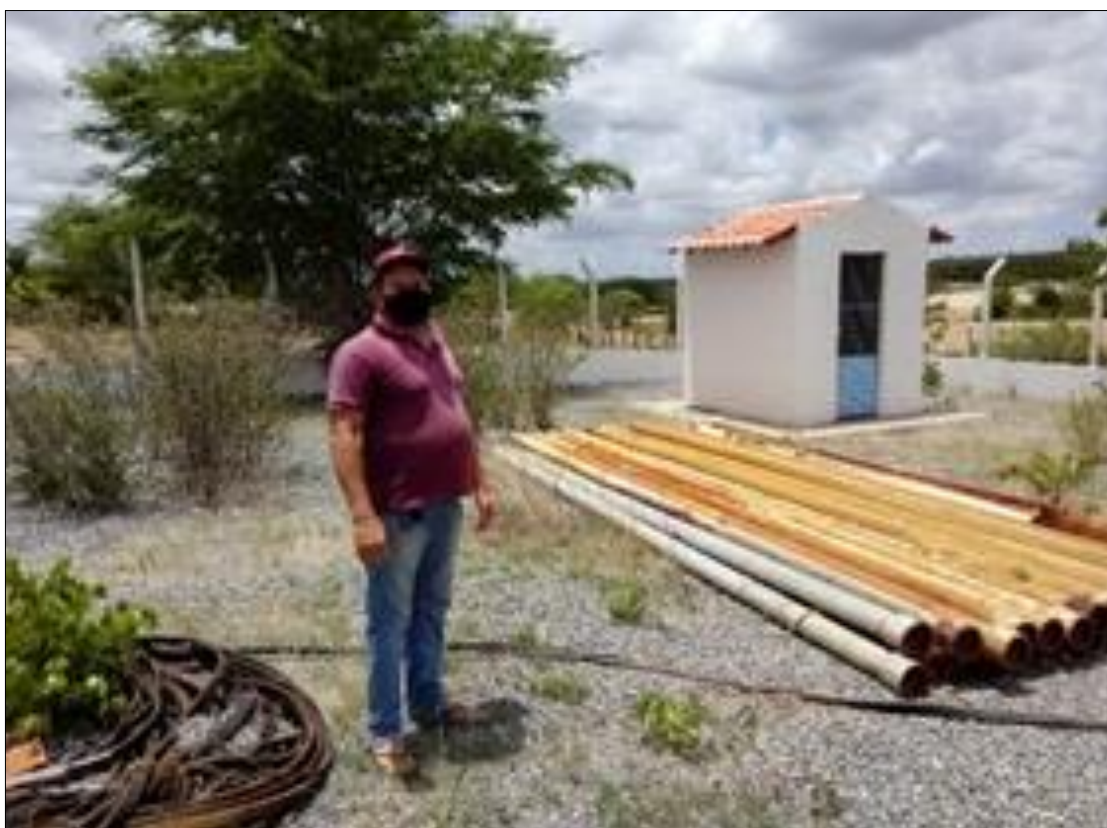
Foto 27: Tubulação de educação em bom estado de conservação sacada do poço
