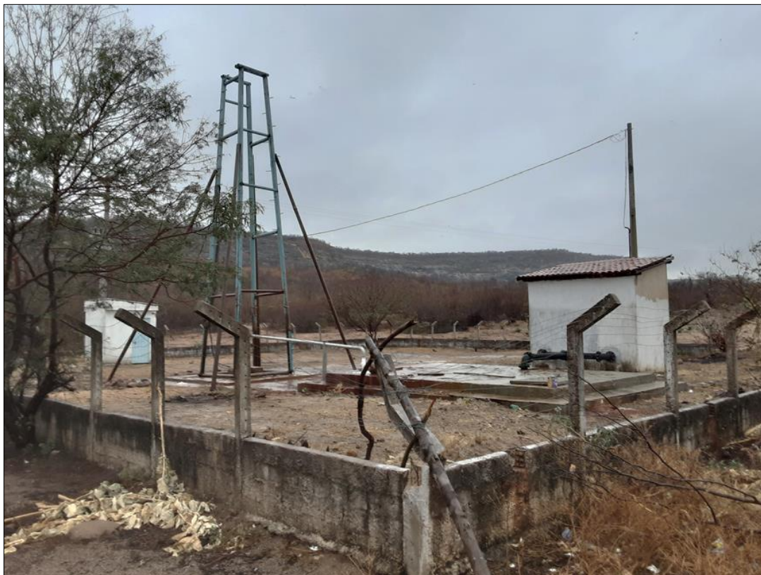
Foto 41: Vista geral da área do poço do Baixão do Bate, São Braz do Piauí.
