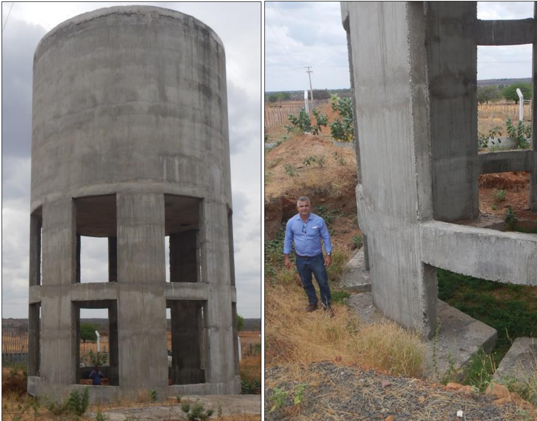
Foto 33: Detalhe do reservatório elevado e das sapatas expostas do poço Lagoa do Canto (técnico da SEDEC/MDR integrante da equipe de visita).
