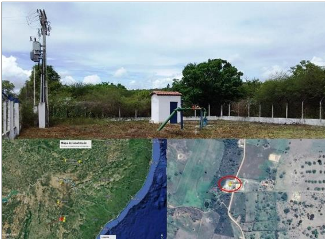
Foto 17: Localização do poço Caburé II, Euclides da Cunha – BA.
