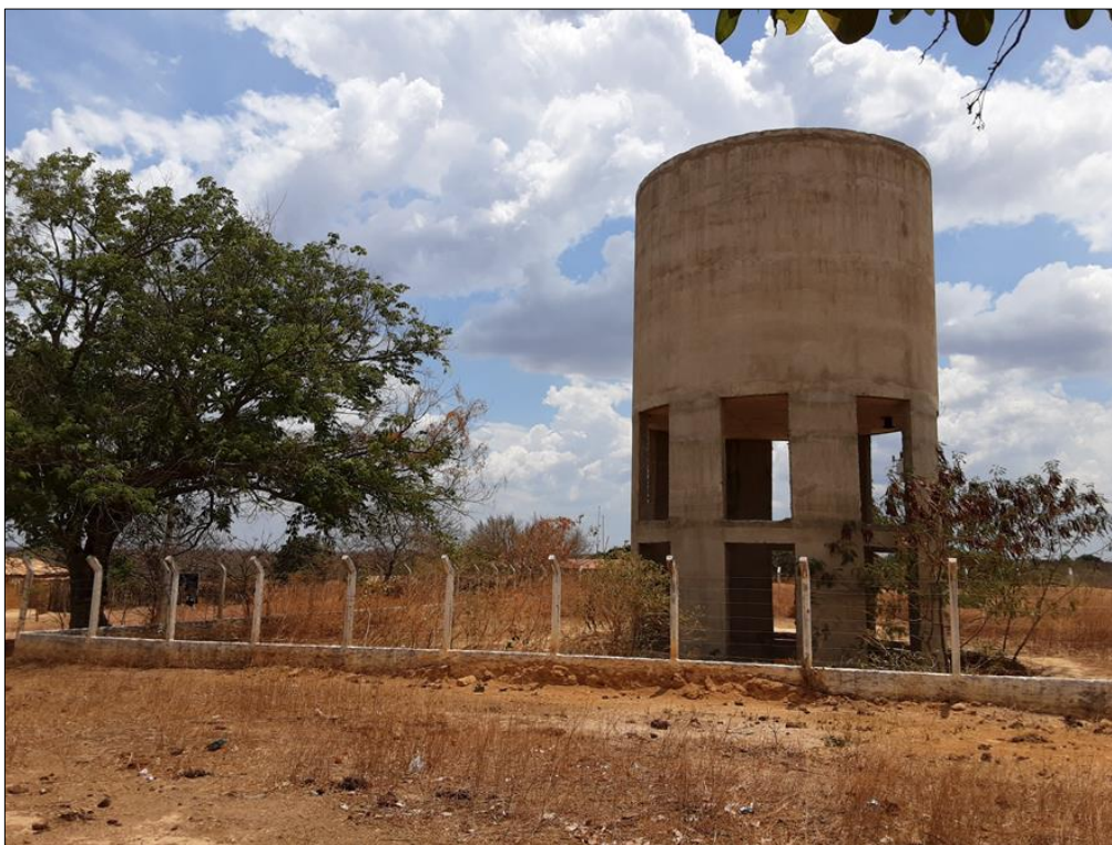
Foto 28: Vista geral do poço Povoado Estevão com bastante vegetação seca sugerindo má conservação do espaço. Existência de um reservatório elevado no local.
