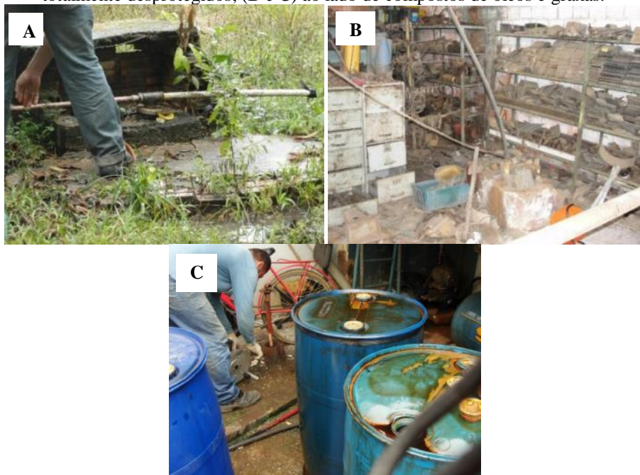
Figura 32 – Exemplos de poços na área em estudo: (A) Poços que apresentam construções precárias e totalmente desprotegidos; (B e C) ao lado de compostos de óleos e graxas.
