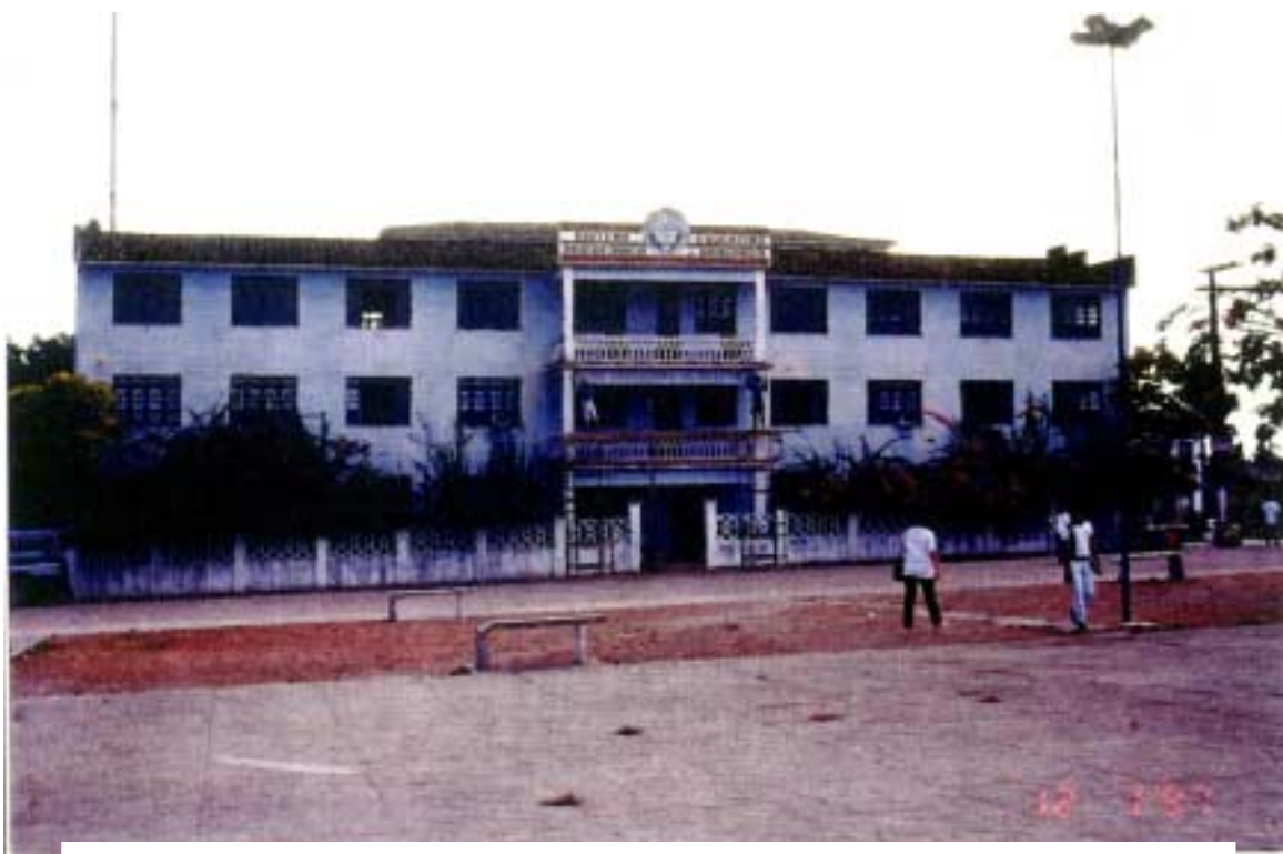
Foto 64 – Bragança - Prédio da Rádio Educadora e das futuras instalações da TV Educadora.
