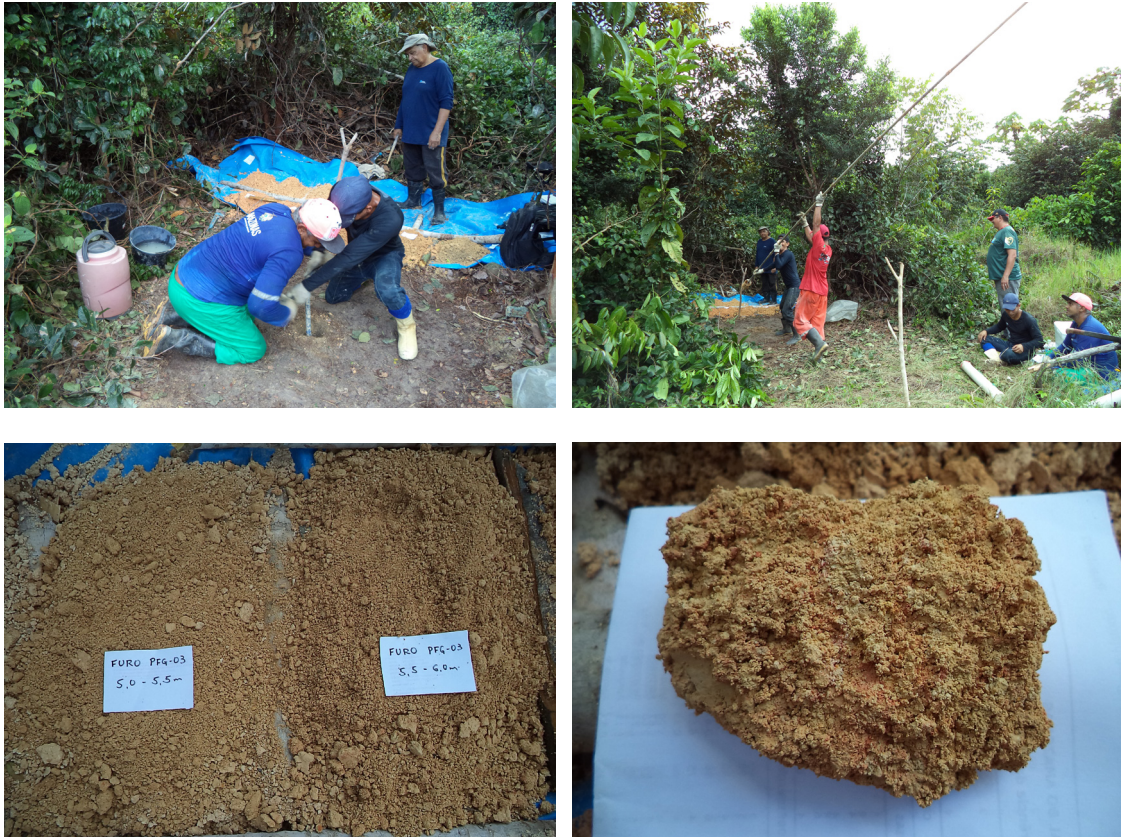
Figura 11 - Aspectos da perfuração do furo PFG-03 e do solo compacto silto-argiloso, amarelado com manchas róseas, existente na profundidade de 4,90 a 6,30m, com detalhe do mesmo.
