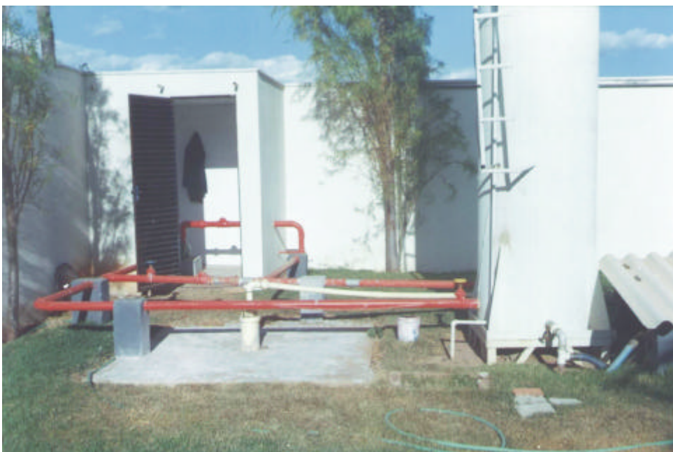
Foto 12 - Poço bem concluído, apresentando proteção sanitária maior que 1m 2 , reservatório e abrigo do painel elétrico em bom estado de conservação. Apresenta risco baixo de contaminação. Município de Montes Claros.
