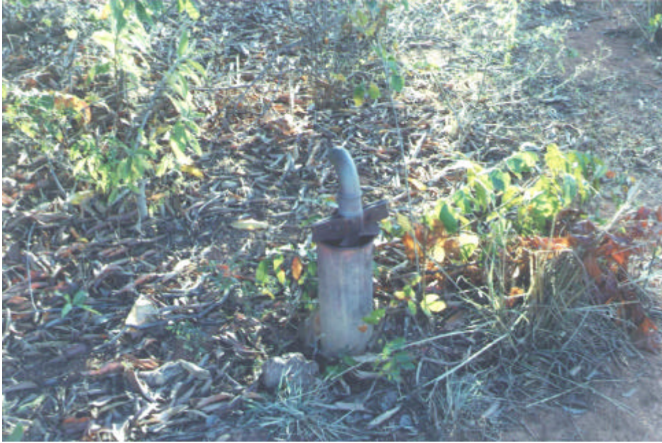
Foto 15 - Poço abandonado, encontrando-se entupido. Utilização de tampa não apropriada. Município de Montes Claros.
