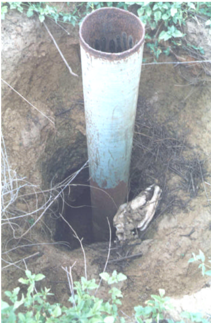
Foto 9 - Poço apresentando risco potencial muito alto de contaminação, evidenciado pela ausência de tampa, não preenchimento do espaço anelar e não confecção da laje de proteção sanitária. Nota-se abatimento da parede do poço e carreamento de resíduo orgânico e inclusive ossada de animal para dentro do furo da perfuração. Município de Verdelândia.
