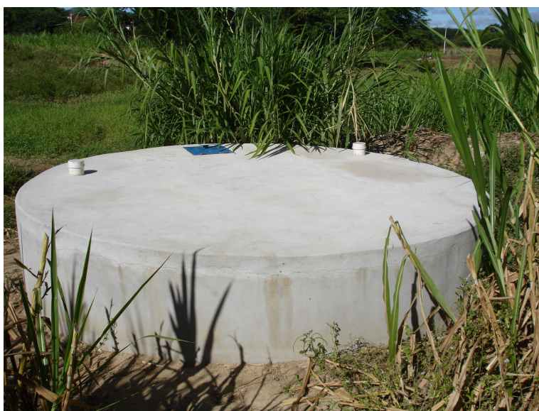
Figura 4.43 – Poço amazonas em construção, Serra Talhada - PR
