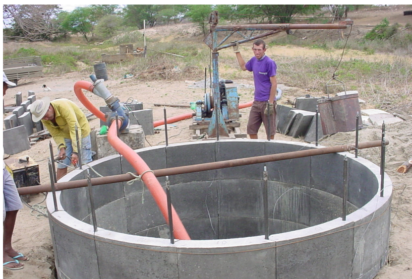
Figura 4.36 – Obras de construção de poço radial
