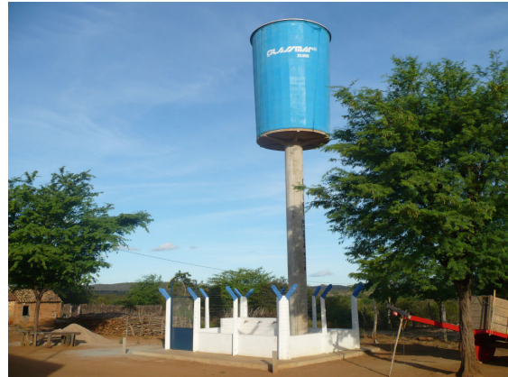
Figura 7.5 – Chafariz em construção, Serra Talhada - PE
