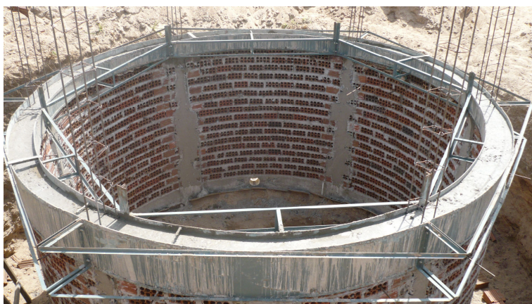
Figura 4.41 – Poço amazonas em construção, Serra Talhada – PE
