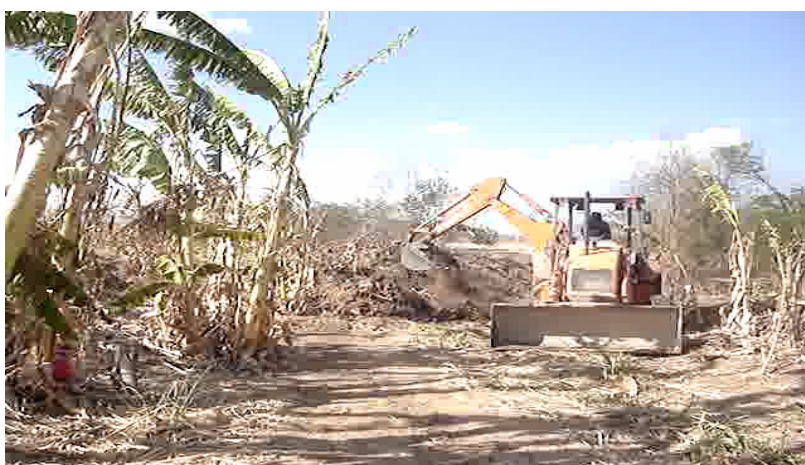
Figura 4.16 – detalhes da construção da barragem subterrânea
