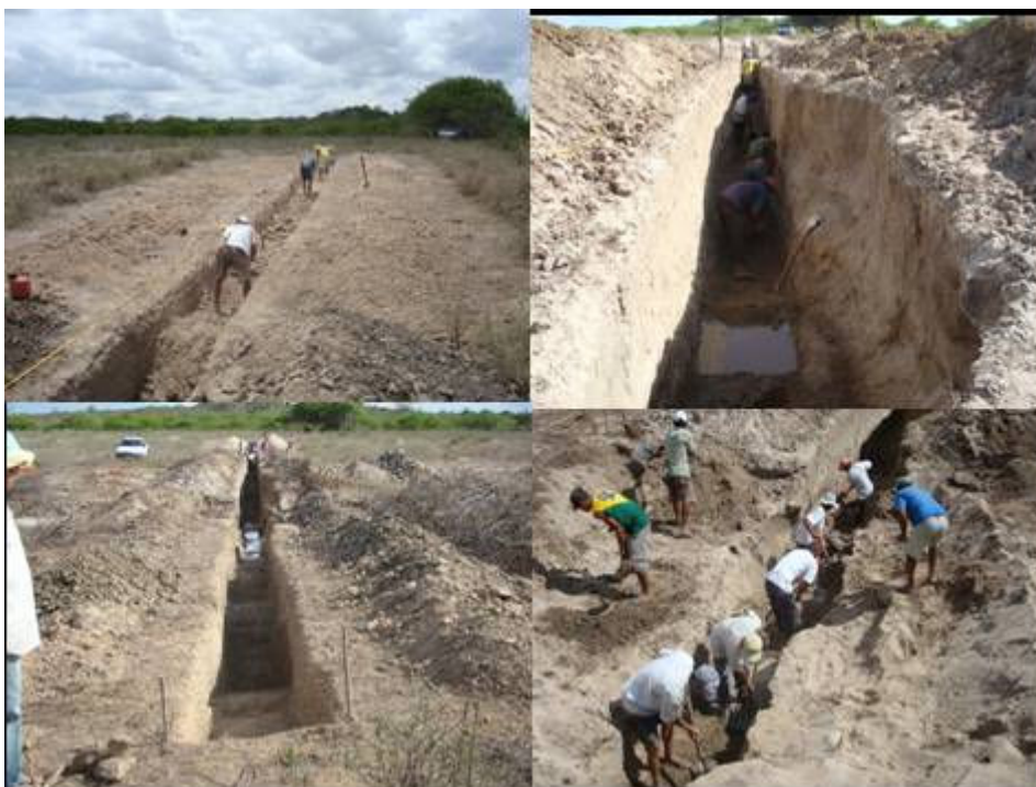
Figura 4.40 – Escavação do eixo da barragem subterrânea CPRM_ZW-1
