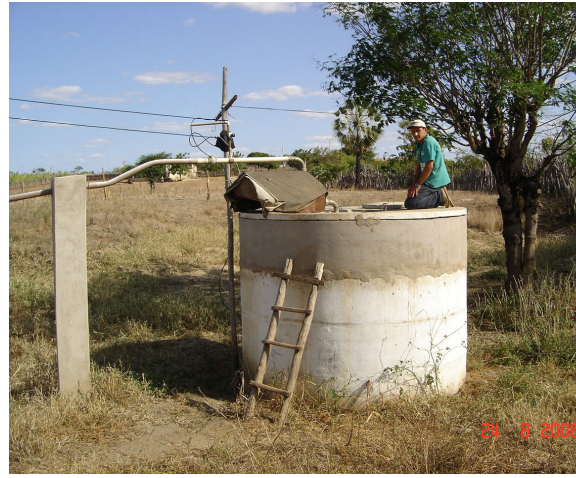
Figura 2.12 – Poço amazonas, em colapso por baixa produção, riacho Caraúnas.
