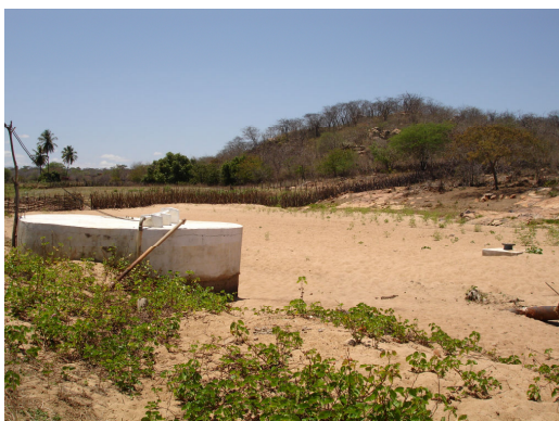
Figura 2.38 - Poços amazonas (P56-C5) e tubular desativado (P58-PT), próximos à localidade indicada para a barragem subterrânea.
