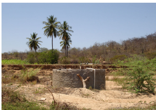
Figura 2.36 – Poço amazonas, com drenos radiais, Betânia/PE.
