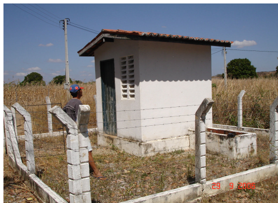
Figura 2.6 - Poço AT 38, abastecimento comunidade de Patos
