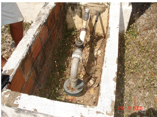
Figura 2.5 – Poço AT 38, abastecimento comunidade de Patos
