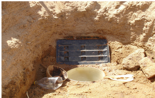
Figura 2.32 – Poço escavado (P49-A1), localizado no leito do rio Moxotó,
