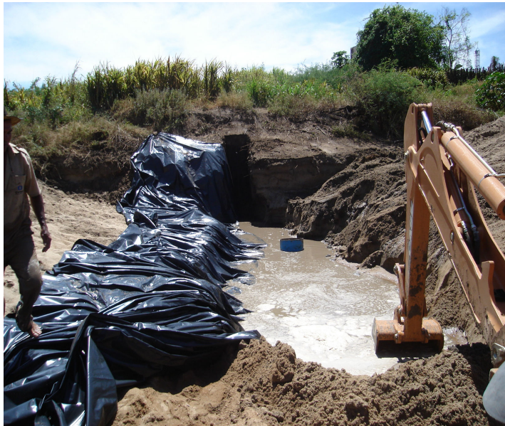
Figura 4.29 - Instalação de lona plástica
