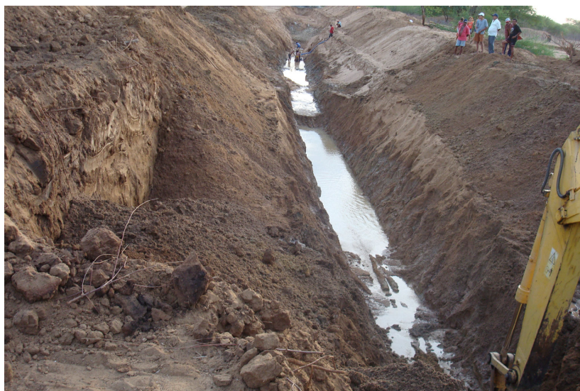
Figura 4.22 – Escavação com escavadeira hidráulica
