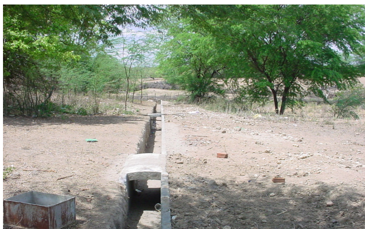
Figura 4.34 - Calha para desvio de águas superficiais
