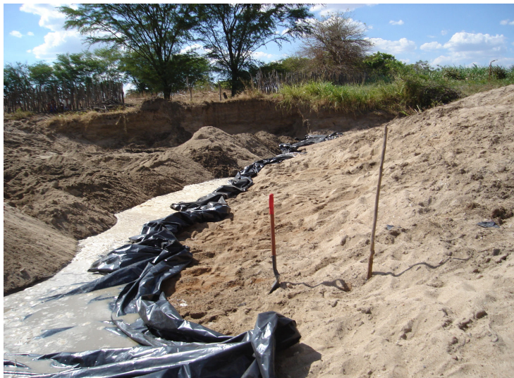
Figura 4.30 - Instalação de lona plástica
