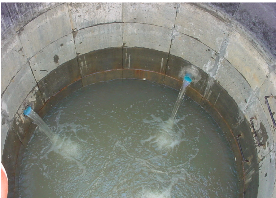
Figura 4.38 – Produção por drenos radiais
