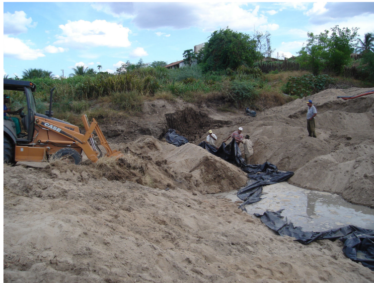
Figura 4.32 - Reposição de material escavado
