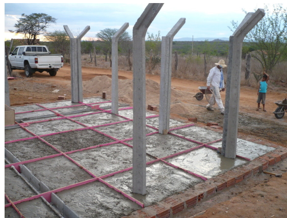
Figura 7.3 – Chafariz em construção, Serra Talhada - PE
