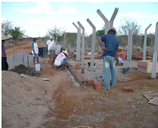
Figura 7.2 – Chafariz em construção, Serra Talhada - PE
