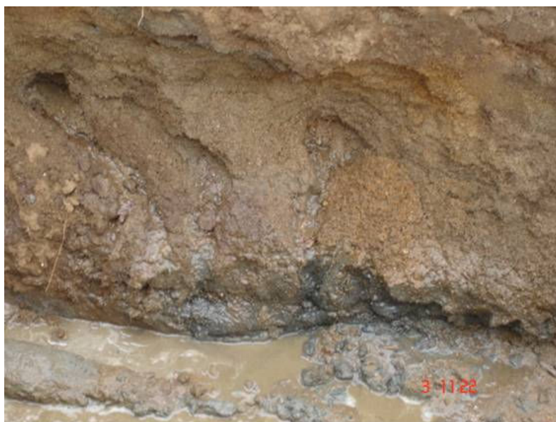
Figura 2.51 - Material aluvial com percolação de água em perfil de trincheira durante período construtivo das barragens.
