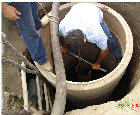
Figura 2.10 – Poço em construção para finalização em tubos PVC de 6", Ipueiras.
