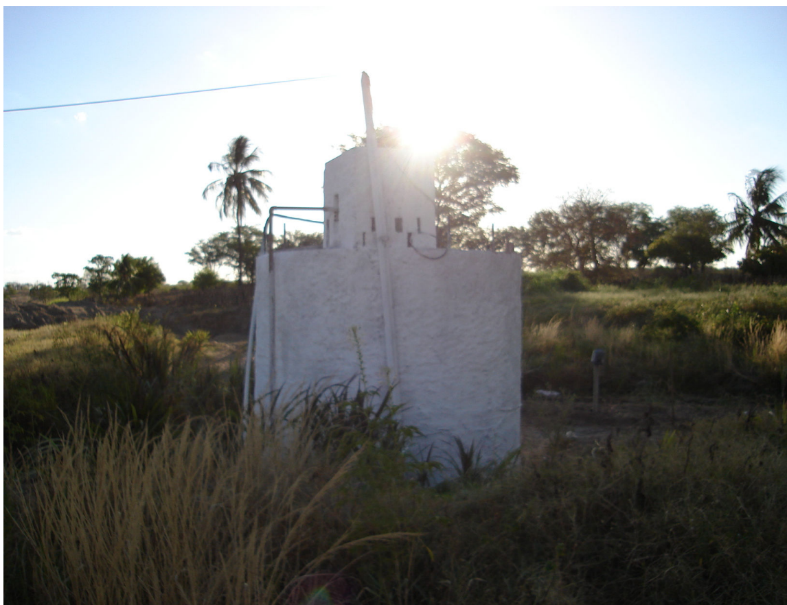
Figura 4.39 - Poço coletor concluído
