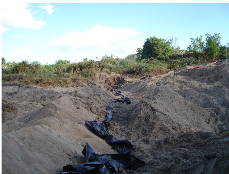
Figura 4.33 - Reposição de material escavado
