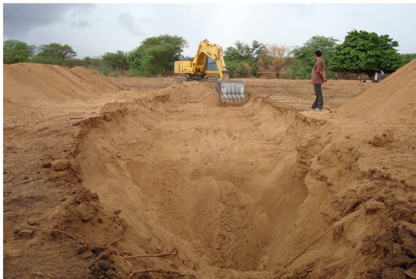
Figura 4.21 – Escavação com escavadeira hidráulica
