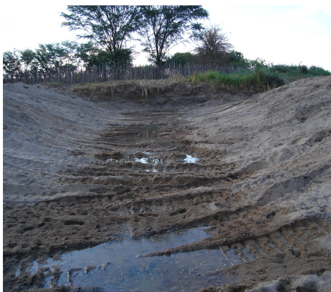
Figura 4.28 - Remoção com trator de altura seca
