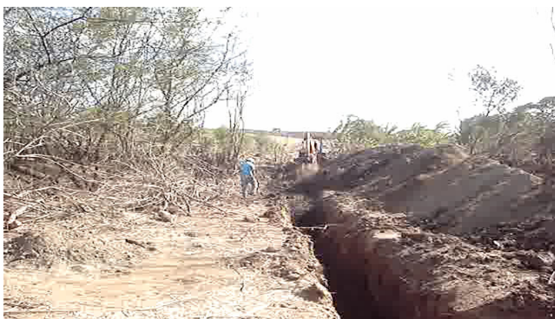
Figura 4.17 – detalhes da construção da barragem subterrânea
