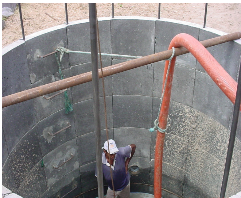
Figura 4.37 – Obras de construção de poço radial
