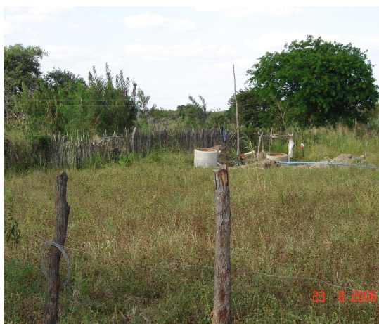
Figura 2.9 – Poço em construção para finalização em tubos PVC de 6", Ipueiras.
