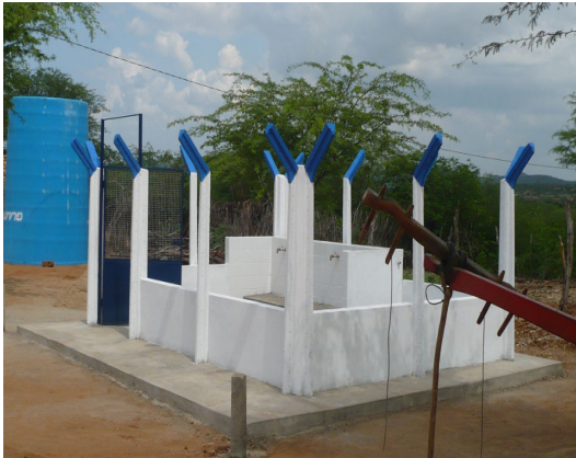
Figura 7.4 – Chafariz em construção, Serra Talhada - PE
