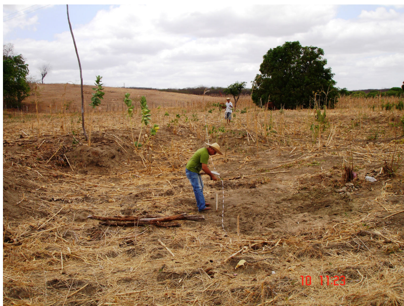
Figura 4.2 – nivelamento topográfico realizado em poços e eixo da barragem
