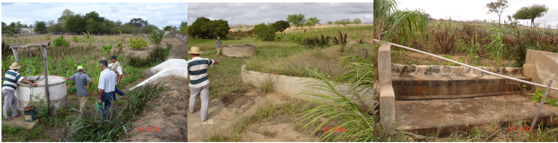
Figuras 9.1, 9.2 e 9.3 – Microbarragens subterrâneas da ONG PATAC – Soledade, Paraíba.
