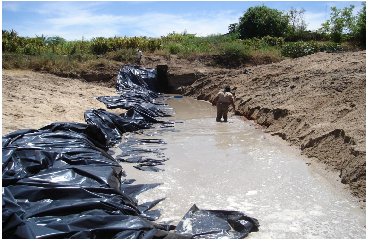
Figura 4.31 - Instalação de lona plástica
