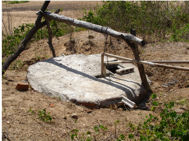
Figura 2.31 – Poço amazonas (P42-C1), equipado com bomba.
