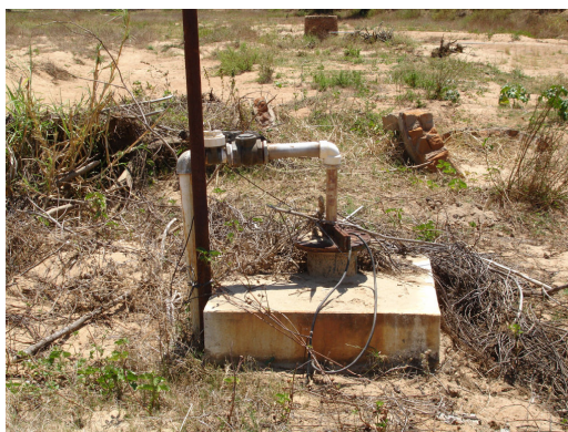
Figura 2.37 – Poço tubular raso, utilizado também como poço de injeção para o poço radial, reforçando o abastecimento da rede de Betânia.
