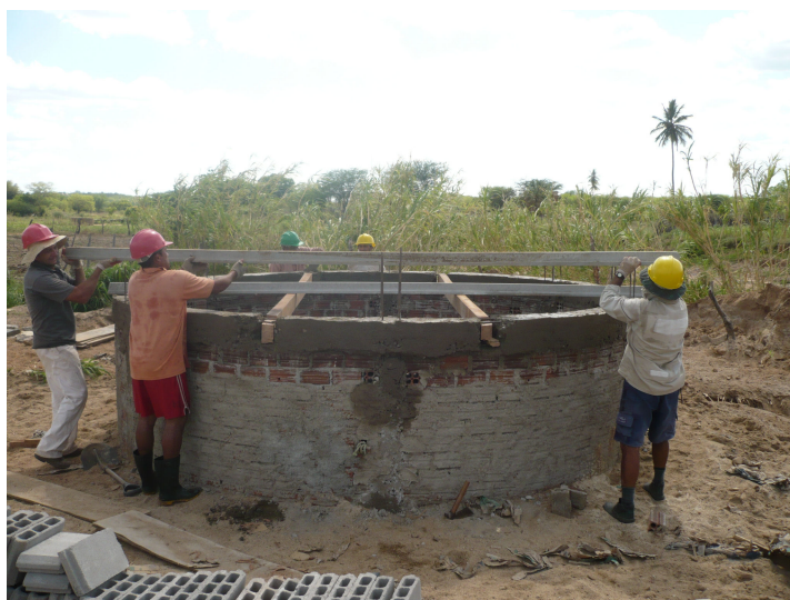
Figura 4.42 – Poço amazonas em construção, Serra Talhada - PE
