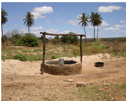
Figura 2.23 – Poço amazonas (P25-C7)
