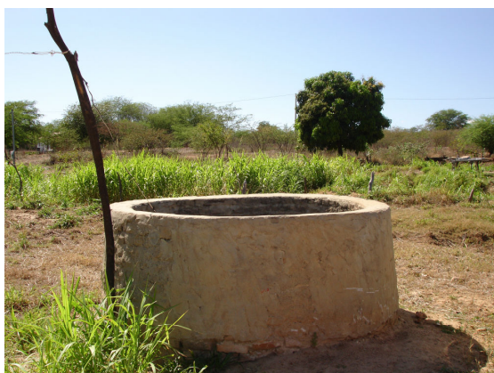
Figura 2.17 – Poço amazonas (P9-C3)
