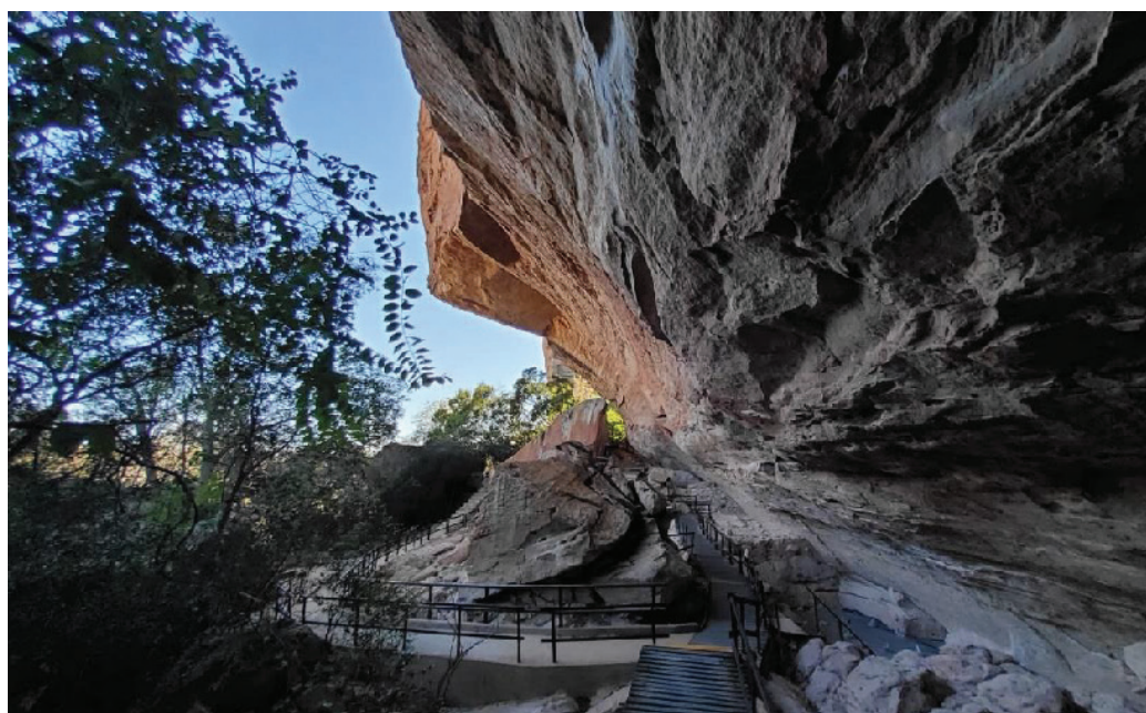
Figura 19 - Vista da Toca do Local de interesse geológico do Meio, uma encosta com relevo negativo e sinais de movimentação de massa, com blocos caídos, outros em balanço e inúmeras cicatrizes de quedas de blocos.
