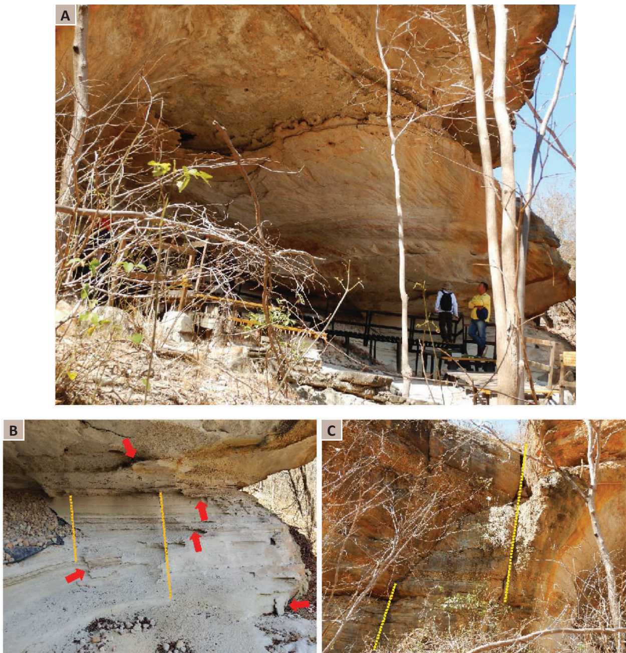
Figura 34 - Sinais de instabilidade do maciço rochoso: internamente com deslocamento e quedas dos estratos (a e b) e externamente por alargamento das diáclases (linhas pontilhadas) com movimentação de blocos (c). Foto: Autores (2023).
