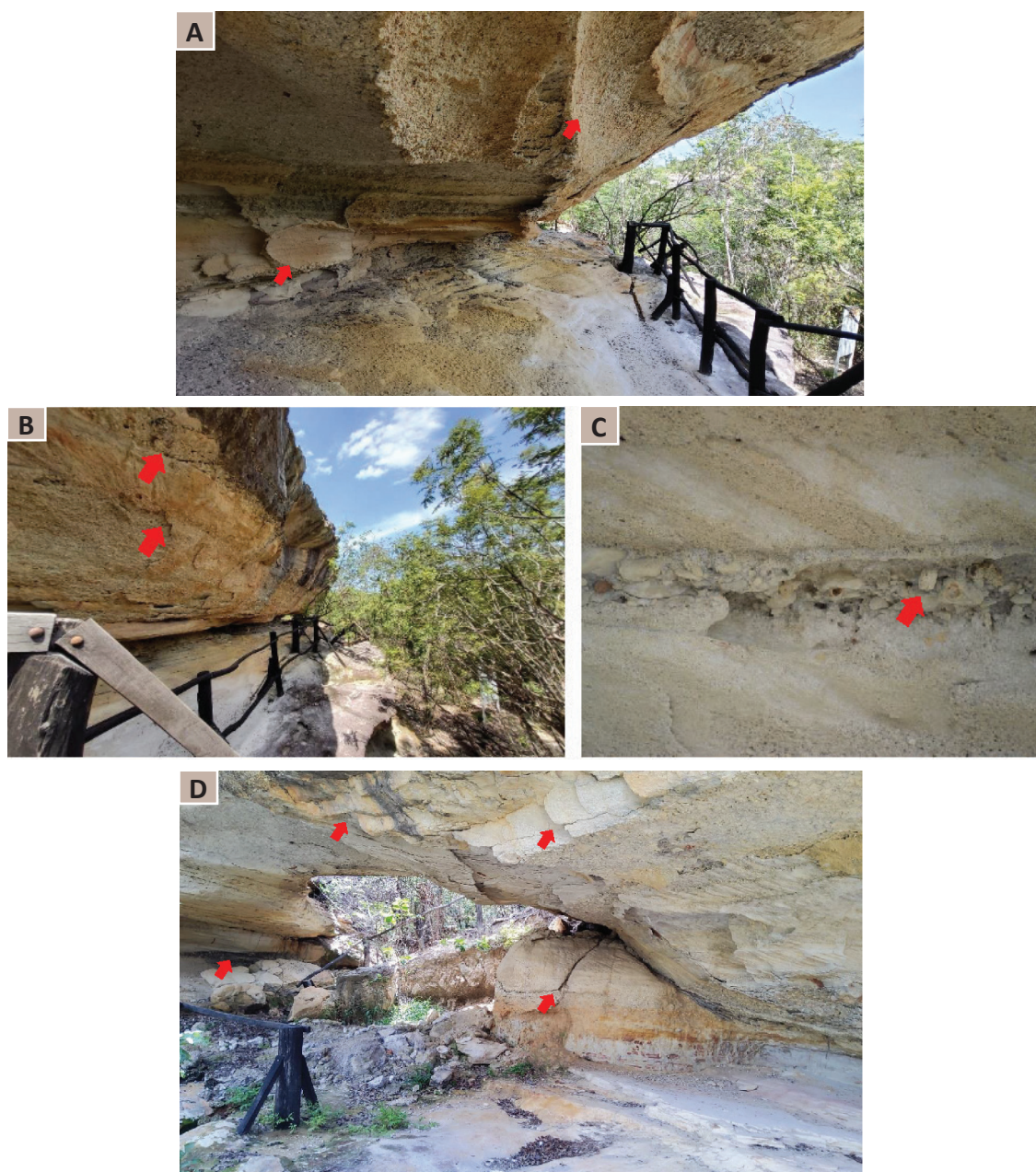
Figura 88 - Nichos instáveis e cicatrizes de desprendimento (a); blocos instáveis (b, d), fraturados e caídos e cicatriz de quedas (d), esfoliação (b) e seixos instáveis por lavagem e carreamento do cimento pela erosão diferencial (c). Foto: Autores (2023).
