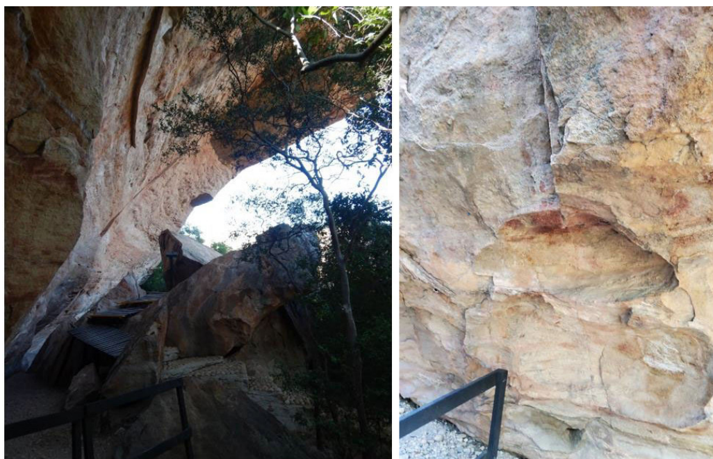
Figura 22 - Grande quantidade de blocos caídos, cicatrizes recentes, sinais de deslocamento e formação de nichos como ação dos agentes de intemperismo em relevo negativo, neste caso água pluvial e variações climáticas confere ao local de interesse geológico um risco alto de atingimento a visitantes. Foto: Autores (2023).
