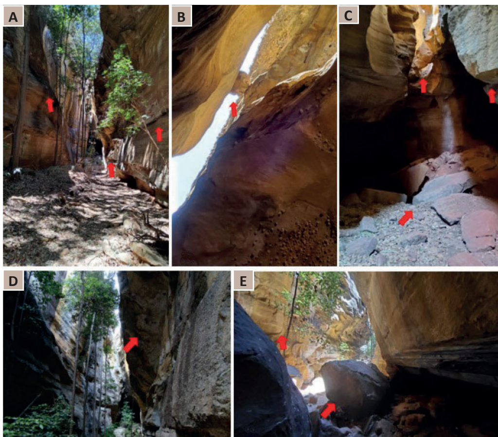
Figura 35 - Arenitos da Formação Ipu no cânion da Toca do Inferno (a, d), com paredões com sinais de forte erosão hídrica (b, d), com blocos em balanço (a, c) e caídos (c, e), outros instáveis e presos na parede mais fechada com relevo negativo (b, d).
