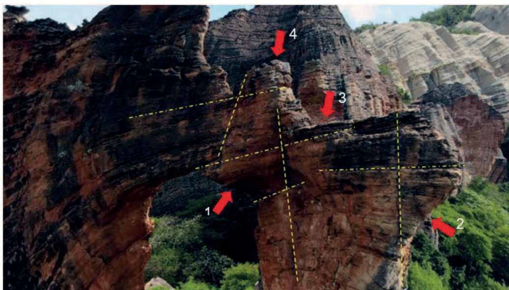
Figura 31 - Arco superior do furo central do LIG da Pedra Furada com indicativos de pontos de fragilidades que conferem ao mesmo um grau elevado de risco a movimentos de massa: queda de bloco em balanço (setas 1, 2); tombamento de blocos (setas 3, 4); linha amarelas em traço (diáclases); linhas amarelas traço ponto (descontinuidades). Foto: Autores (2023).
