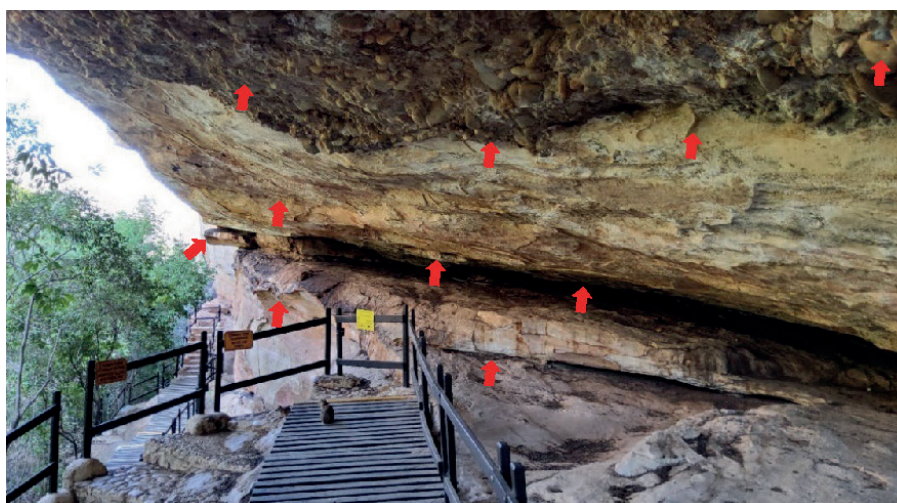
Figura 61 - Feições indicadoras de situações de risco geológico: diáclases, quedas de seixos e blocos, deslocamento e erosão diferencial. Fotos: Autores (2023).
