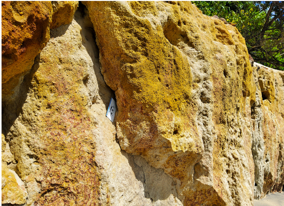
Figura 9 - Falésia formada nos sedimentos do Grupo Barreiras. Foto: arquivo dos autores.
