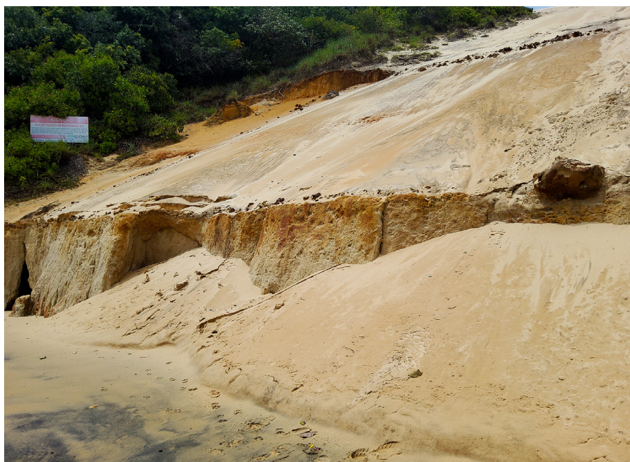
Figura 11 - Pilhas de sedimentos arenosos deslizam diariamente da duna durante a maré baixa e são carregados pelo mar durante a maré alta. Foto: arquivo dos autores.
