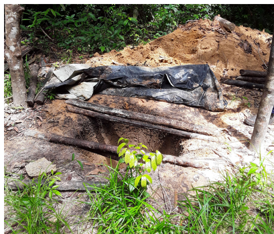
Figura 3 - Escavação do poço amazonas 2, com nível estático verificado de 5,41m.
