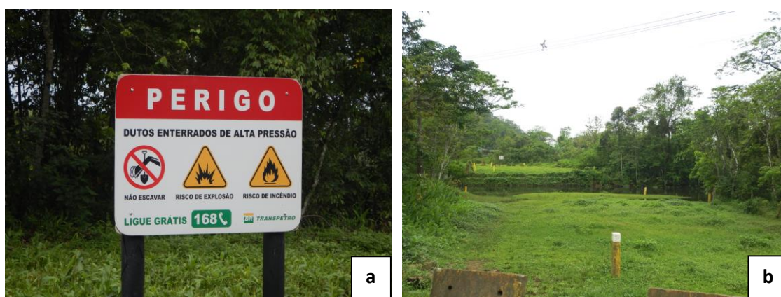
Figura 29 – (a) Sinalizações em superfície da ocorrência de (b) dutos de enterrados para o transporte de gás e infraestrutura correlata
