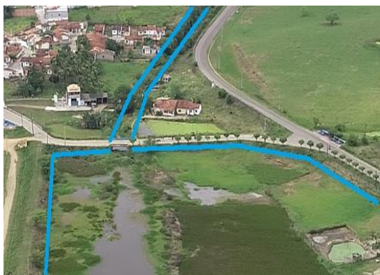
Figura 7 – Estrangulamento de uma vasta drenagem natural em um canal de irrigação e construções de casas à jusante do estrangulamento.
