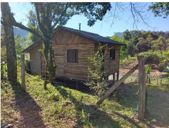
Figura 3 – Erosão fluvial a menos de um metro da moradia
