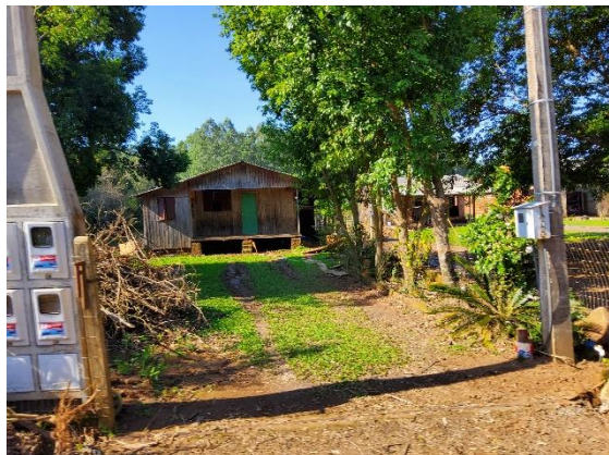
Figura 5 – Casa de baixo padrão construtivo atingida pela inundação.
