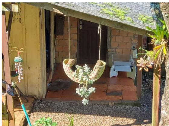
Figura 9 – Casa com trincas no piso.
