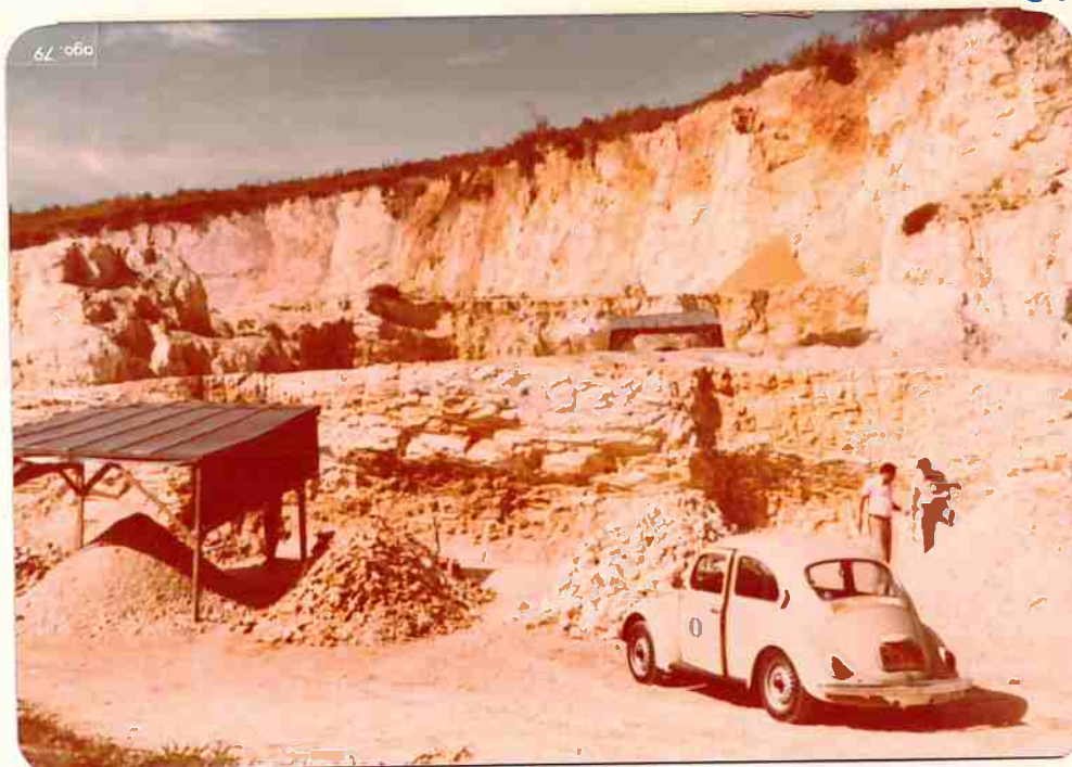
Foto 59 - Extração manual de filito na região de Santana de Parnaíba. Mineração Maria Luíza.
