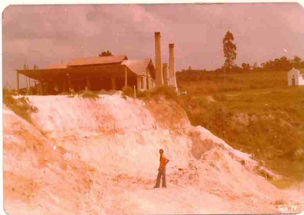
Foto 45 - Jazida de caulim da Mineração Ouro Branco, em Tijuco Preto (Cotia), vendo-se ao alto as instalações de moagem e secagem do material.
