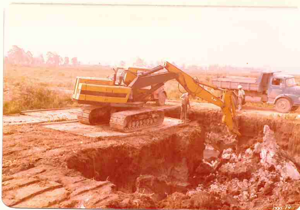
Foto 34 - Jazida de argila da COPAMI em Jundiapéba, Mogi das Cruzes. A baixo resistênciã do solo obriga ao uso de pranchas para o deslocamento das máquinas.
