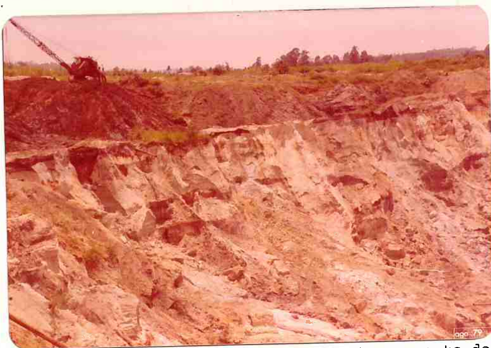
Foto 16 - Trabalho de remoção do capeamento no porto-de-areia Bandeirantes, em Guarulhos. Trata-se de sedimentos de várzea similares aos de Itaquaquetuba.
