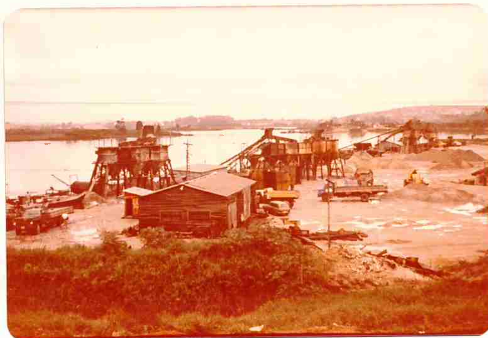
Foto 20 - Extração de areia por dragagem em lagos resultantes da inundação de antigos portos. Vila Gustavo, Carapicuíba.
