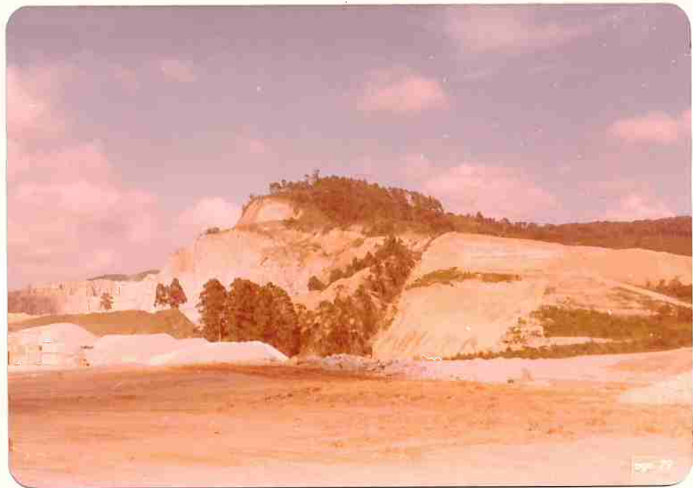
Foto 7 - Vista geral da Pedreira Reago, em Guarulhos, observando - se espesso capeamento de solo.
