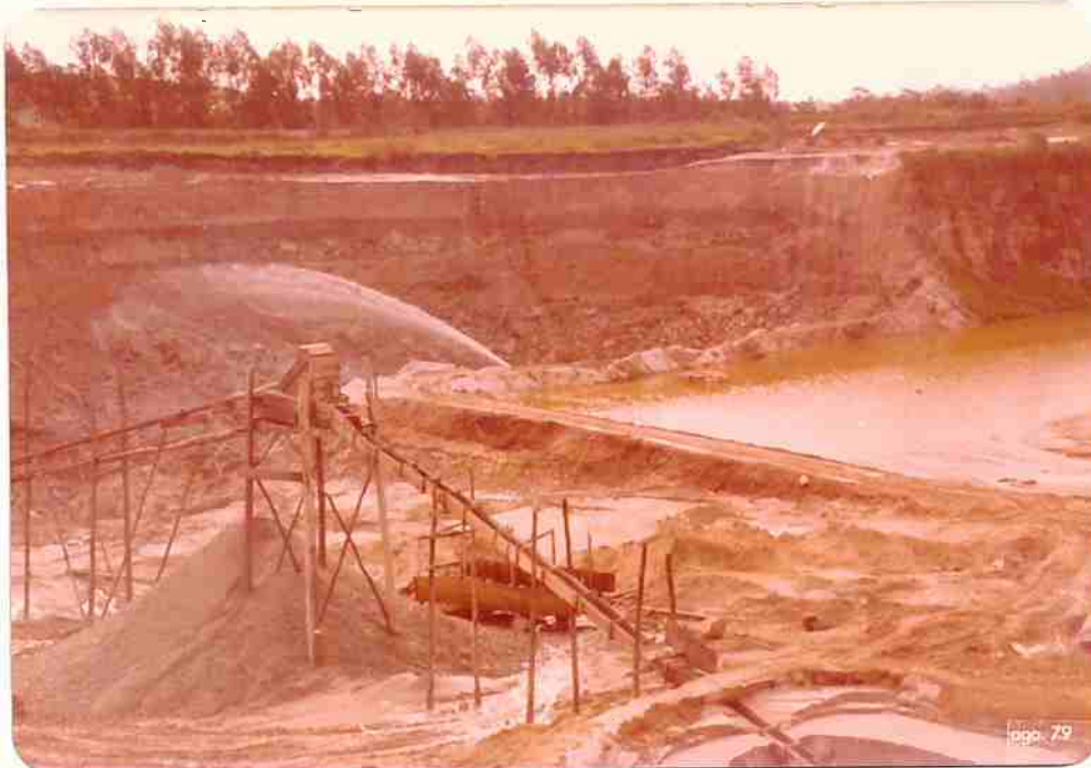
Foto 21 - Vista parcial do porto-de-areia União, em Suzano. Observam-se os trabalhos de desmonte hidráulico, bem como a represa para decantação de finos e a peneira para separação de cascalho.
