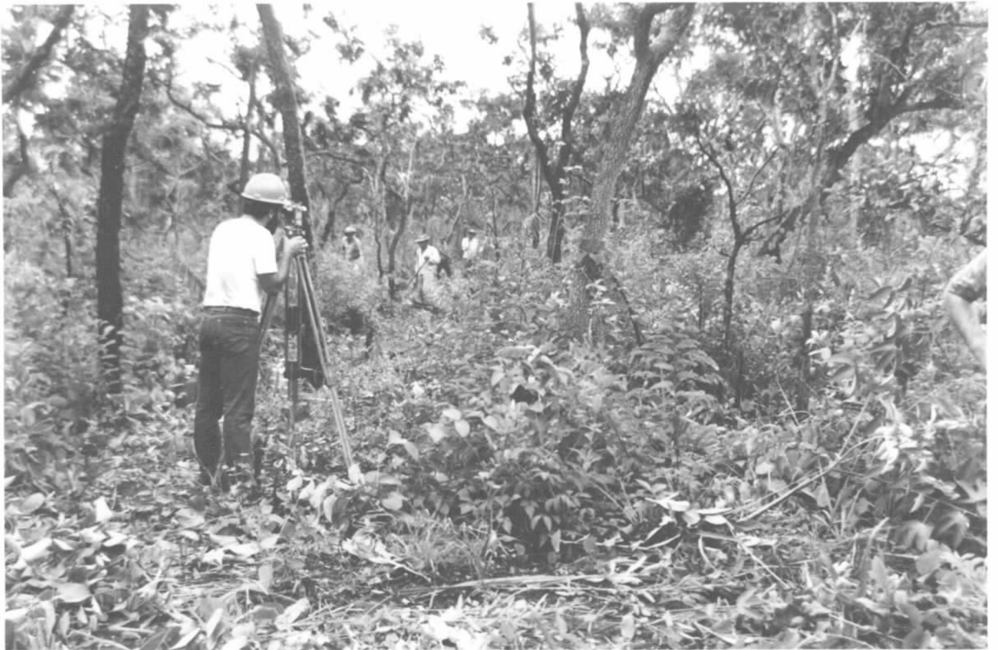
FOTO Nº 13 - Serviço de topografia.
