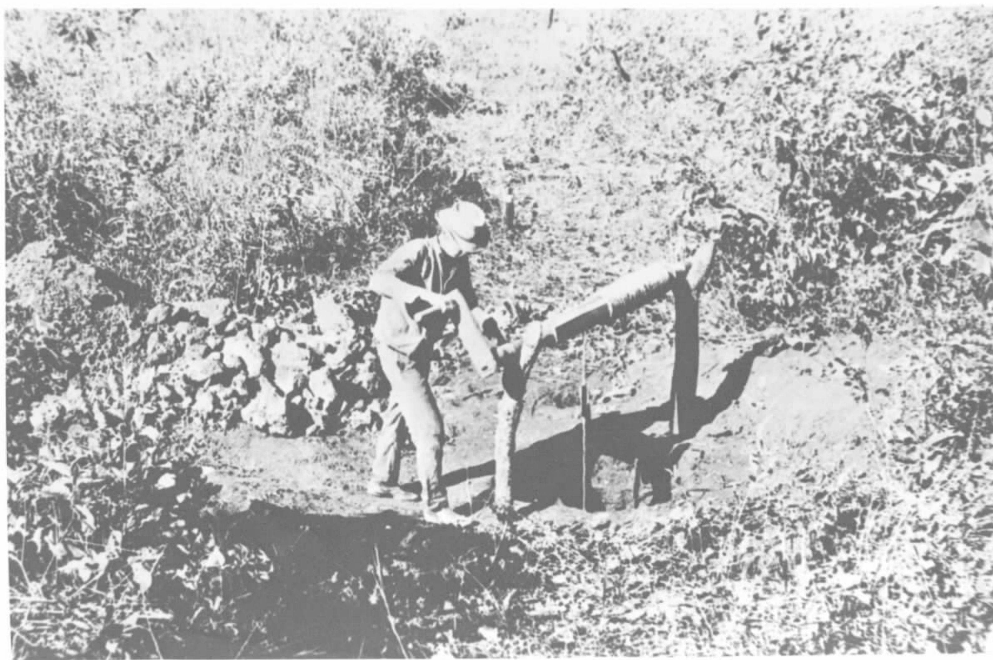
FOTO Nº 10 - Aspecto da abertura de poços sem escoramento com auxílio de um sarilho.
