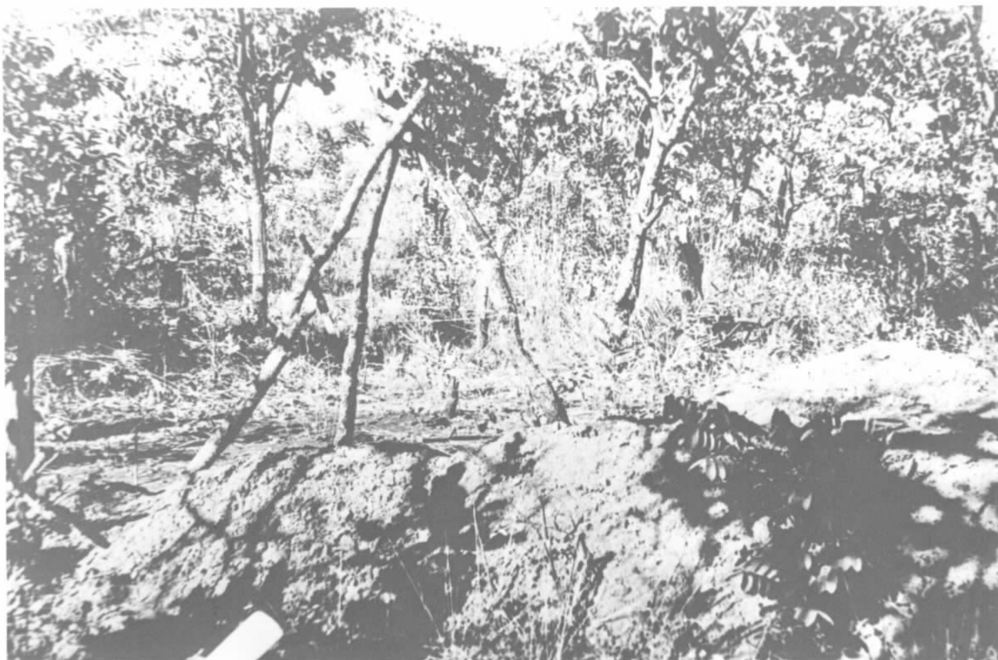
FOTO Nº 09 - Poço executado. Cercado por medida de proteção.
