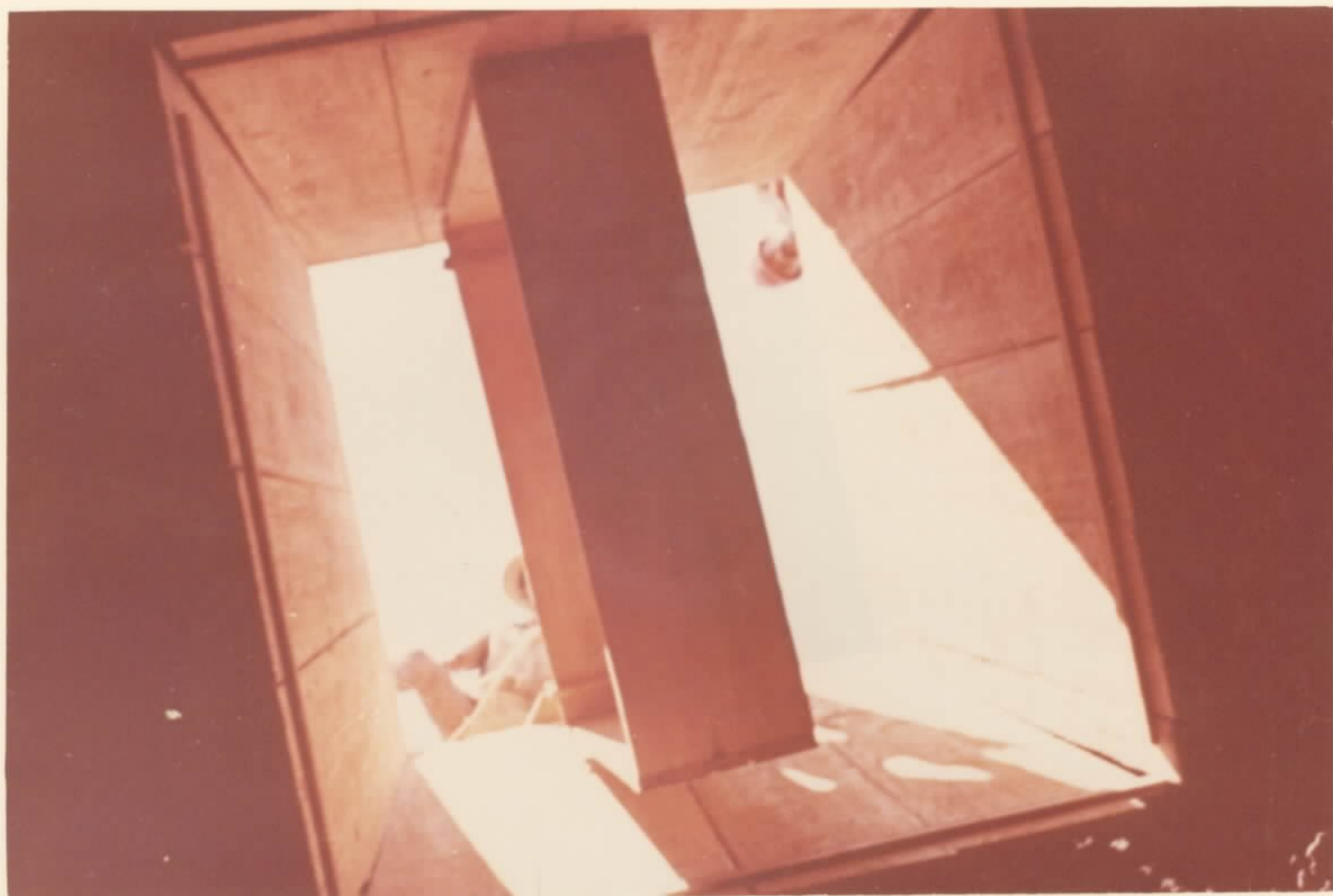
FOTO Nº 11 - Poço escorado. Vista de baixo para cima.
