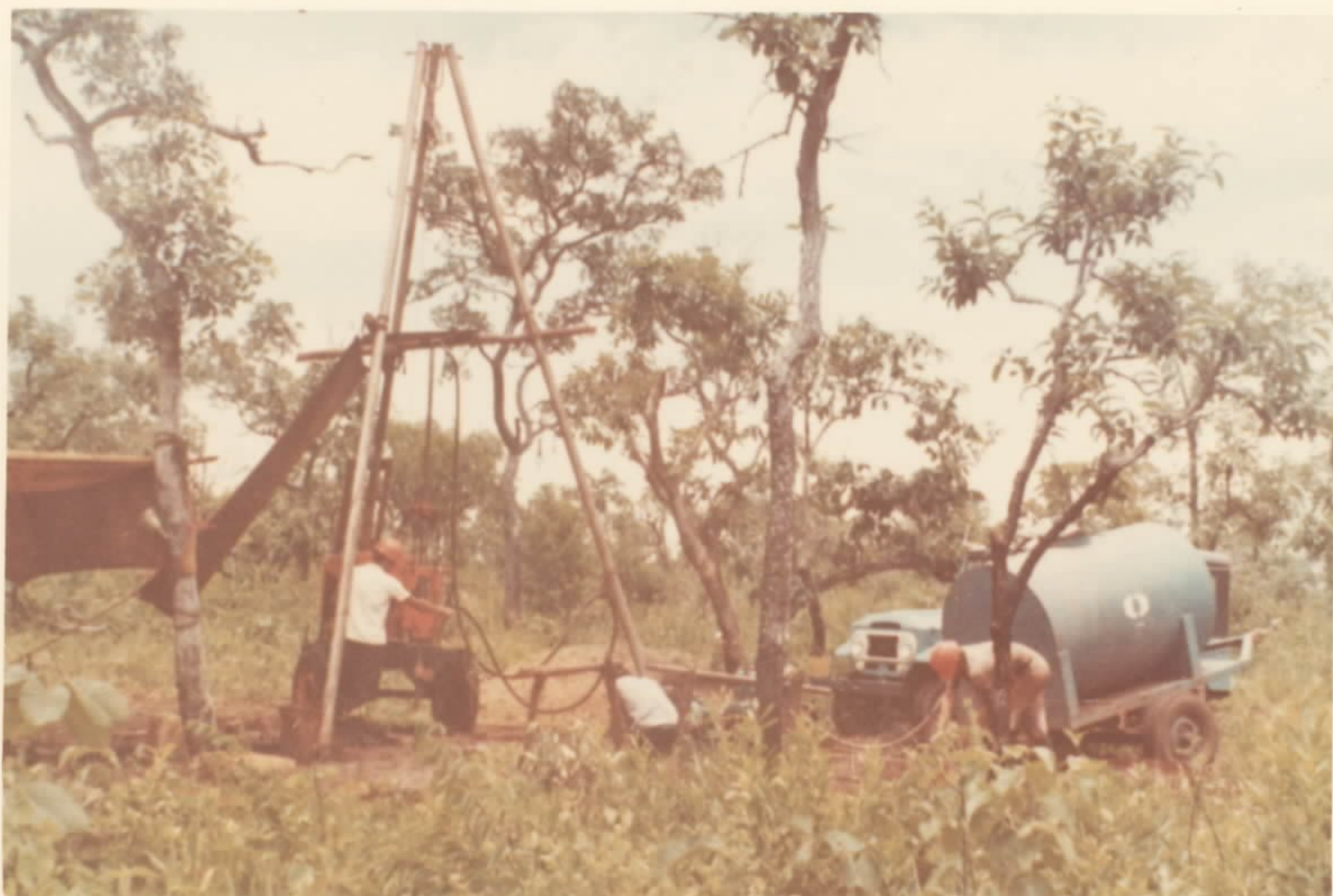
FOTO Nº 15 - Aspecto da sondagem.
